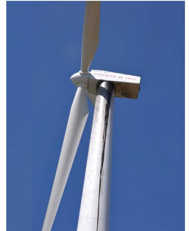
Figura 37. Fuga de aceite en aerogenerador.
