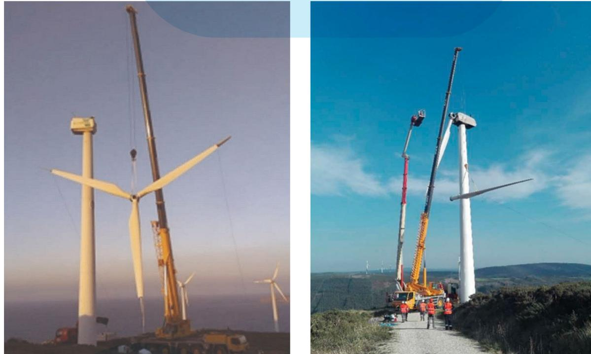
Figura 13. Desmontaje del rotor completo (izq.) y desmontaje por palas (der.).
