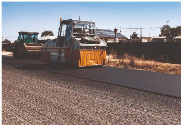
Figura 29. Aplicando la mezcla en el pavimento.
