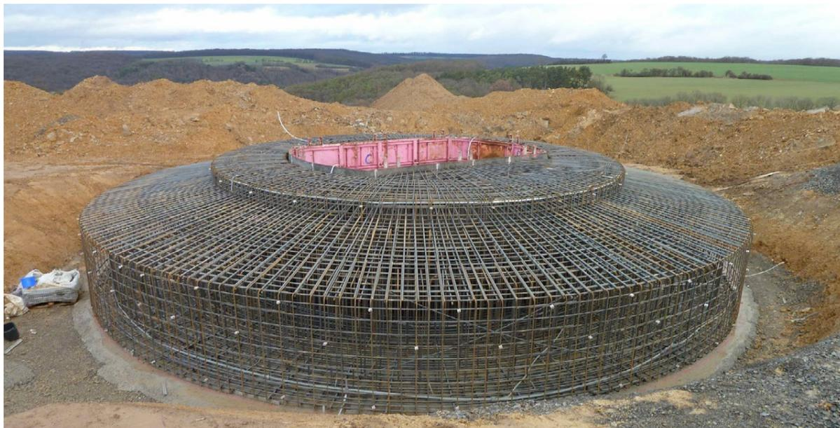
Figura 9. Esqueleto armado de una cimentación anclada.
