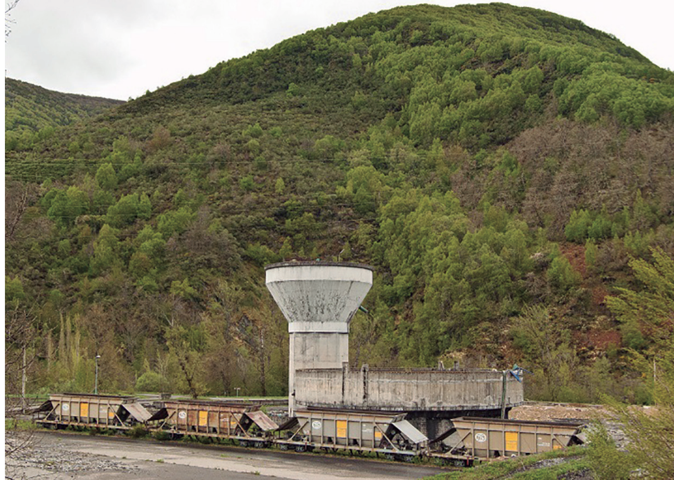
Lavadero abandonado en Villablino. © Ministerio de Agricultura
