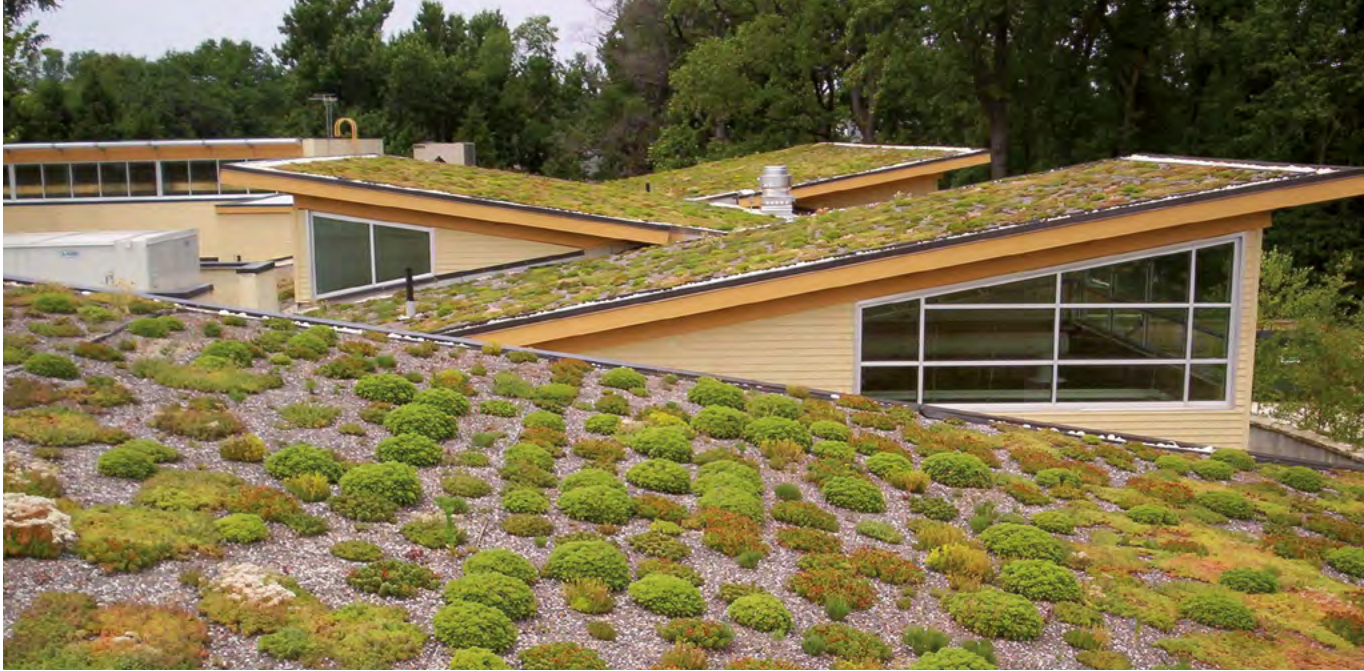
Tejado verde en el condado británico de Arlington, una Solución basada en la Naturaleza cada vez más comúnmente utilizada que reduce la escorrentía y ayuda a regular la temperatura
