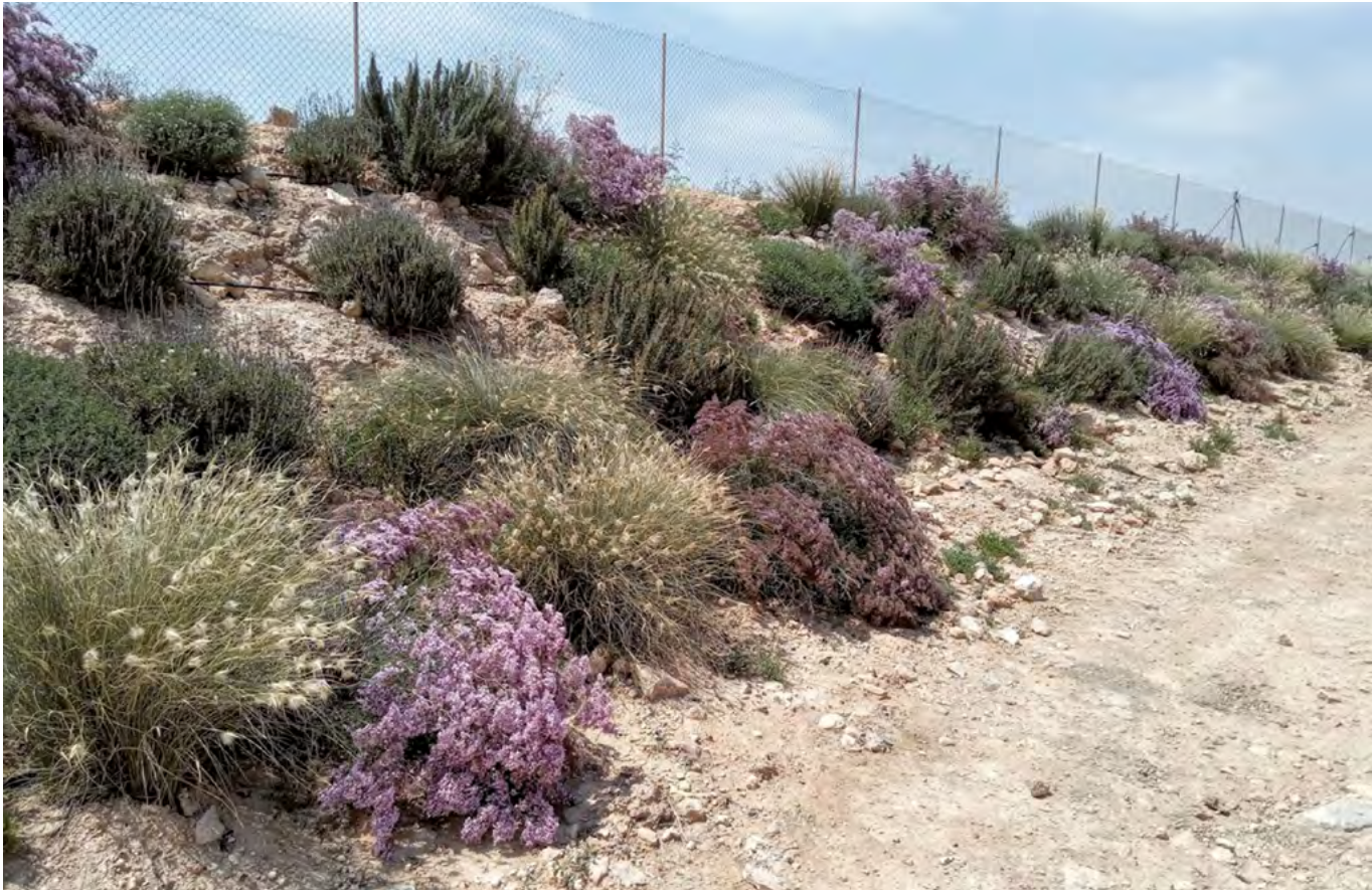
Talud revegetado en balsa de riego área de cultivo intensivas. La revegetación no sólo asegura el talud sino que disminuye la generación de flujos del mismo hacia el cultivo, flujos que se pueden concentrar en regueros de mayor entidad © JSB
