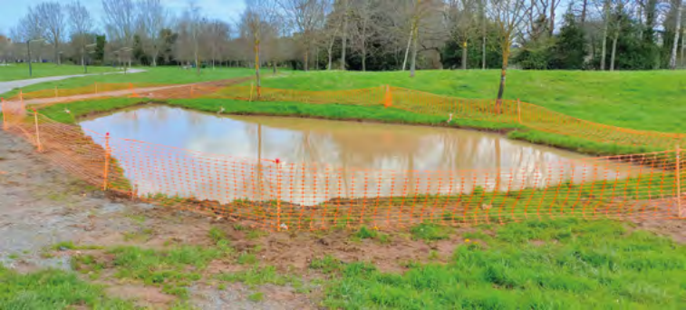
Jardín de lluvia en construcción en Gijón, una actuación que mejora la permeabilidad del suelo
