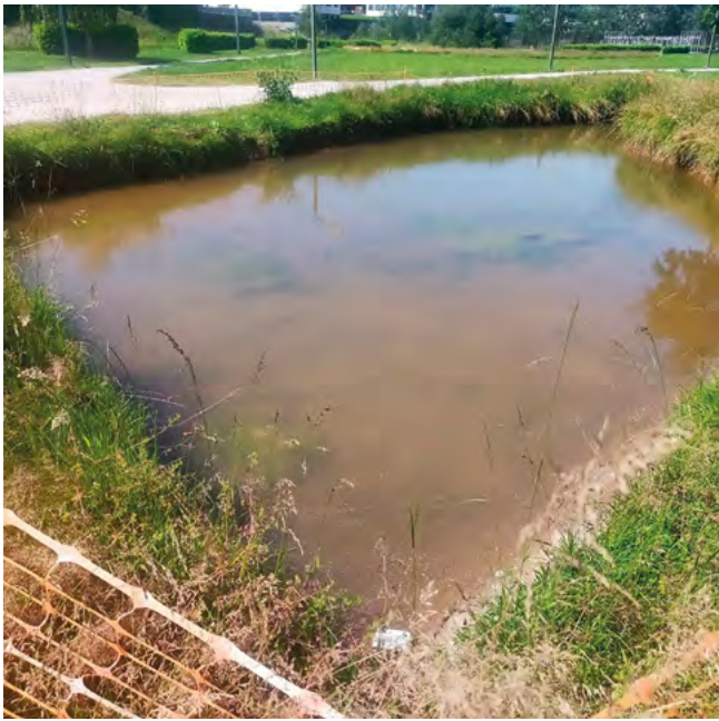
Jardín de lluvia en proceso de ejecución en el entorno del parque fluvial
