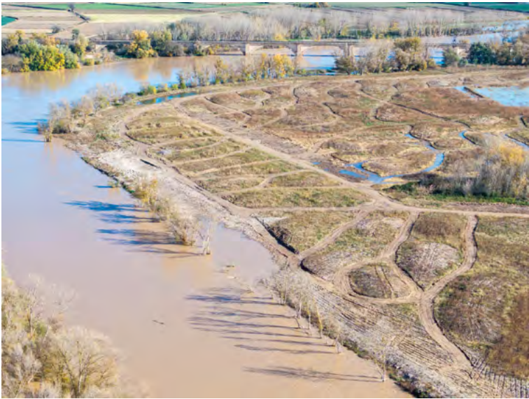
Crecida de caudales del Ebro en el meandro de La Roza (Alfaro, La Rioja), recuperado y renaturalizado a través de un proyecto de adecuación morfológica del programa LIFE Ebro Resilience © LER-P1
