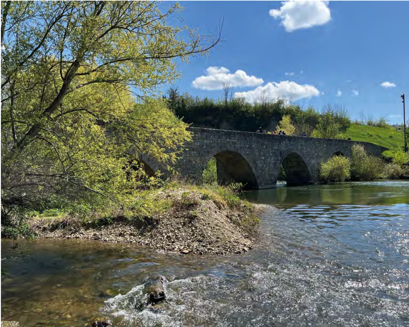
Acarreos a retirar en el río Arga, junto al puente viejo de Burlada (Navarra)
