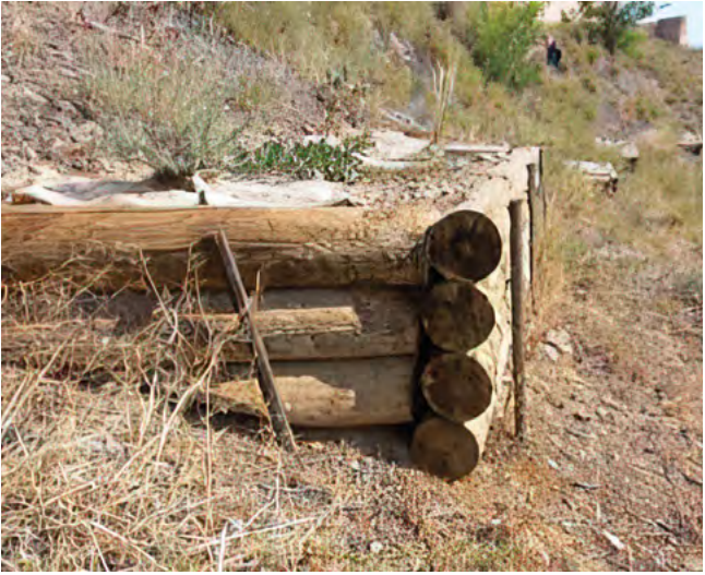
Fajina para talud en Lleida
