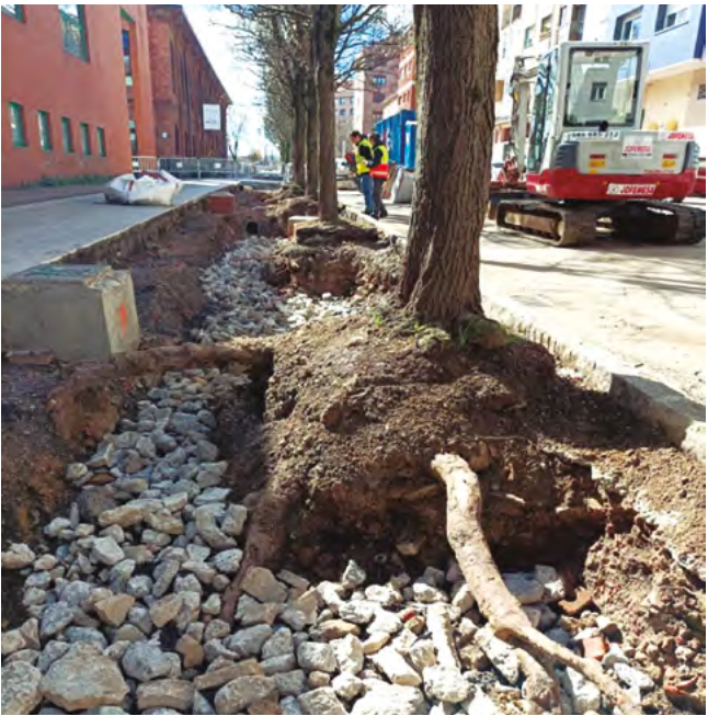
Sistema radicular liberado de un alcorque típico viario. Calle Alejandro Farnesio Fotos y gráficos: Gijón Ecoresiliente
