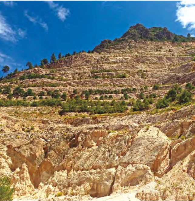
Cantera revegetada mediante el modelo de berma-talud en Vilallonga (Valencia) © J. Cortina
