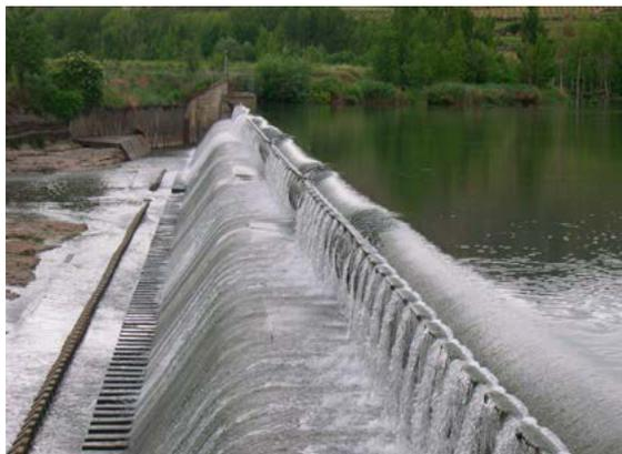
La principal innovación de esta central fue la colocación de una presa inflable de 1,6m de altura y 197 m de longitud en un solo vano, récord del mundo en longitud en ese momento, con el objetivo de no elevar de manera permanente el nivel del río, ya que, en situaciones de crecida o avenida, la presa se desinfla y evita posibles afecciones aguas arriba de la presa.
