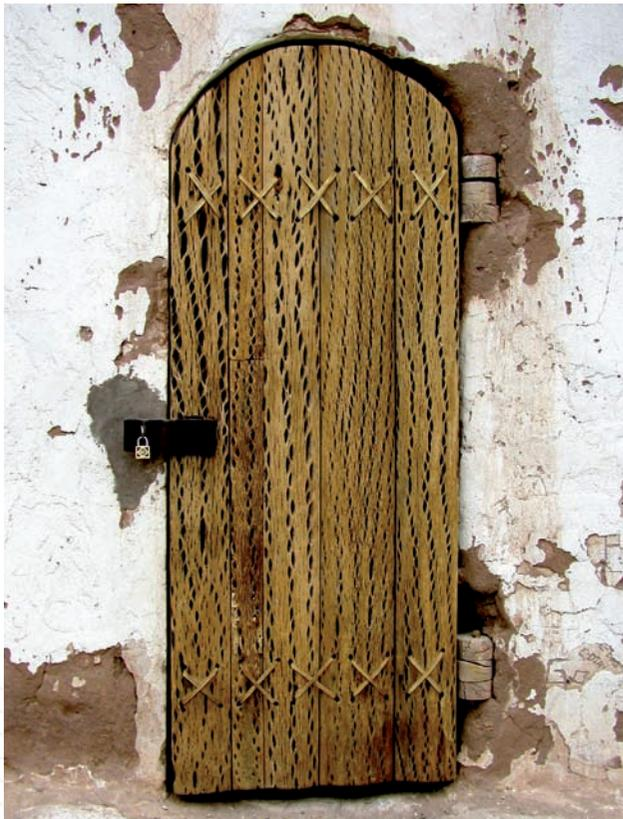
Figura 2. Puerta fabricada con tejido lignificado de cactus (Atacama, Chile).
