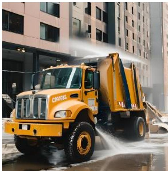
**Figura 9.25.** Zona habilitada para el lavado de los camiones antes de salir de la obra (Imágenes creadas mediante software Canvas- Multimedia Mágico™).
