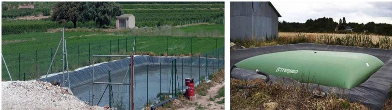
**Figura 9.30.** Izquierda: Balsa de purines impermeabilizada con cierre perimetral (Miró y Teira, 2010). Derecha: Balsa de purines cubierta (Sidrach, 2020).
