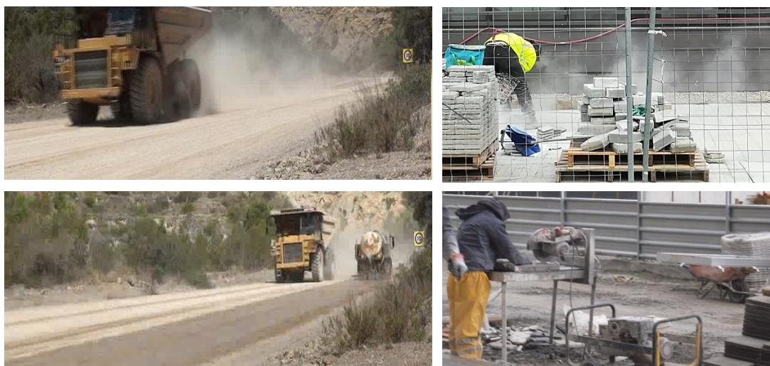
**Figura 9.20.** Ejemplo de emisiones de polvo por paso de camiones y corte en seco (arriba) y de la disminución de las mismas mediante aplicación de agua (abajo).
