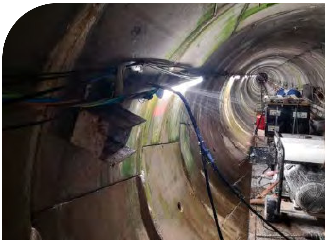
Interior túnel hidráulico Jalón - Grío
