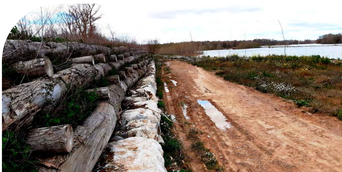
Muro Krainer en mota del río Ebro en "El Estajao" (La Rioja)
