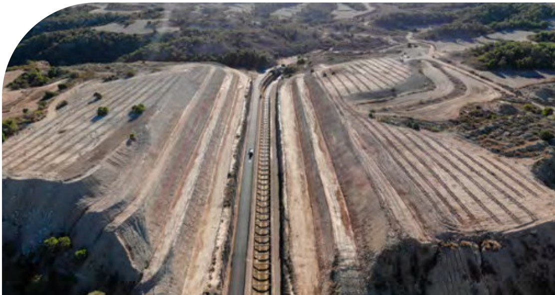
Vista aérea trinchera Alcubierre
