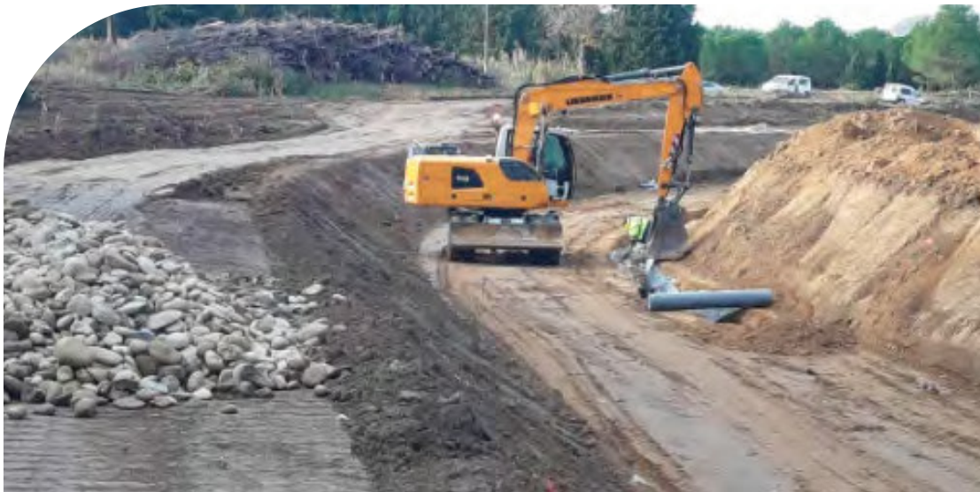
Excavaciones en emisario La Sotonera
