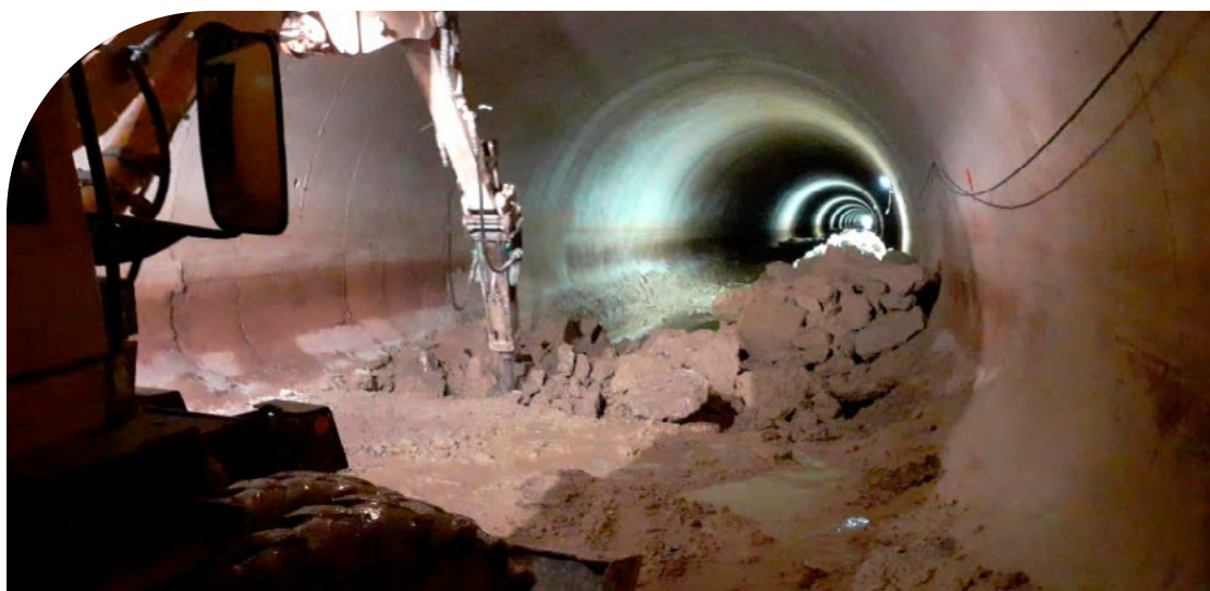
Mantenimiento del túnel de Farasdués
