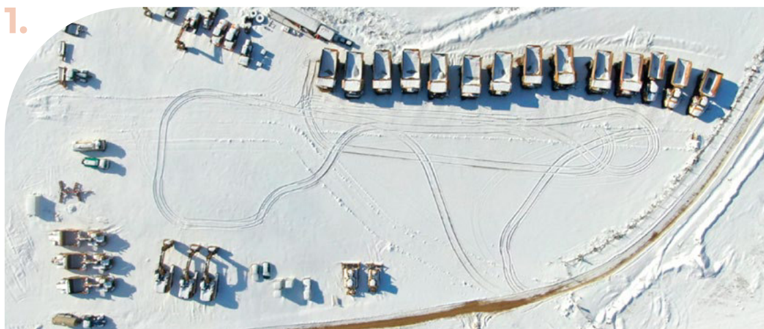
Obras del embalse de Almudévar, Huesca
