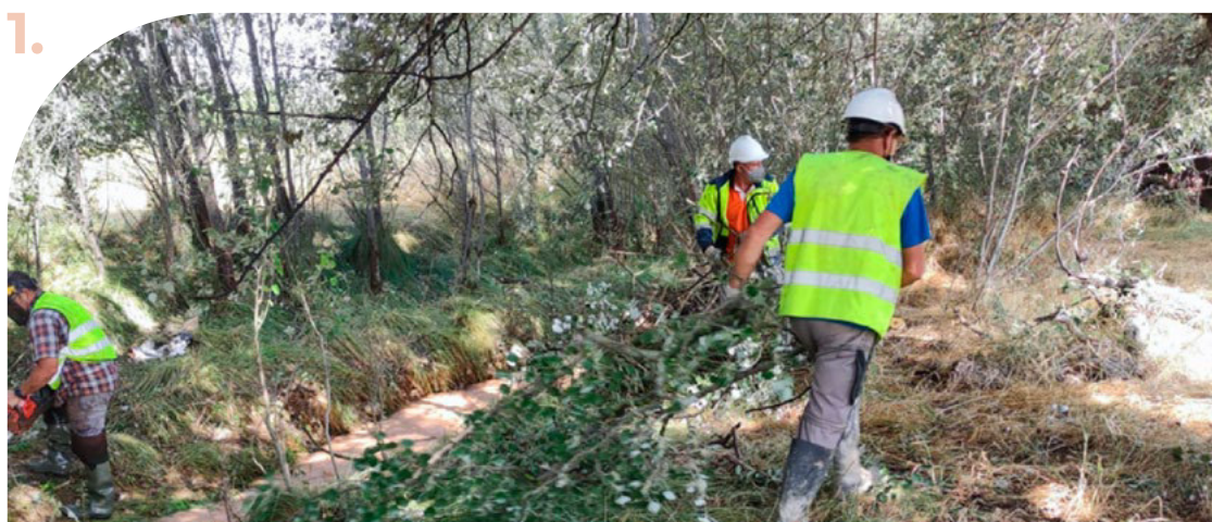
Mantenimiento de cauces
