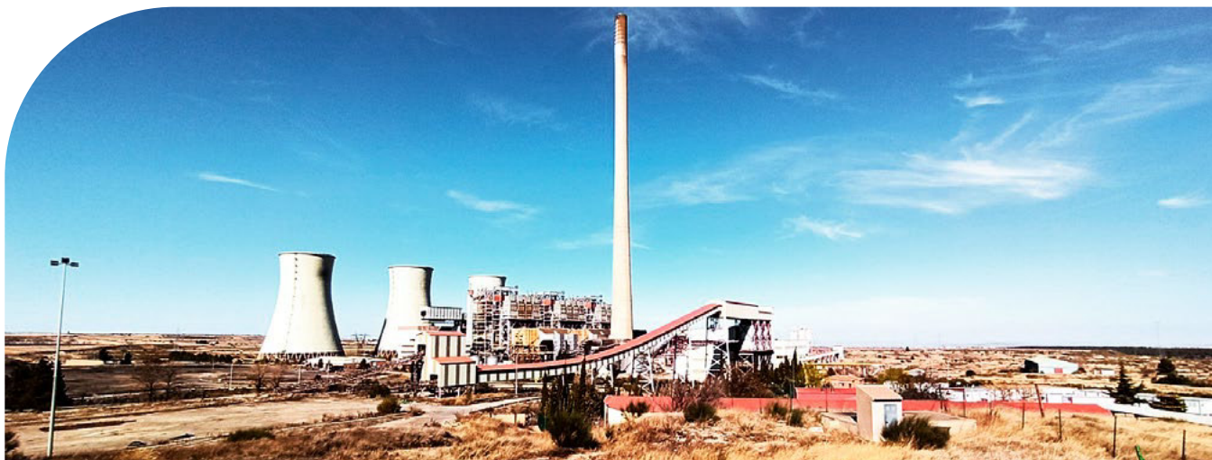
Central Térmica de Andorra
