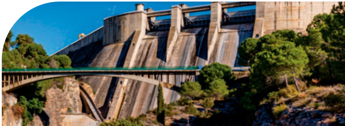
Presa de el Grado
