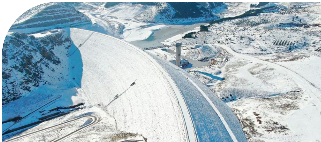
Presa de Mularroya
