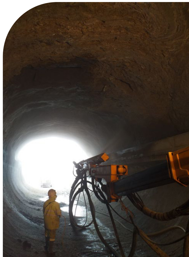
Estabilización de túneles del Canal de Aragón y Cataluña (Lleida/Huesca)
