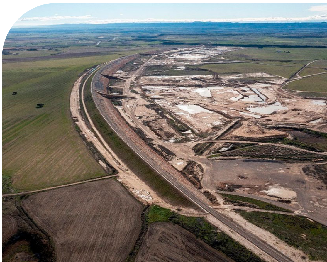
Estado actual dique este
