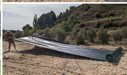
Sistema de desenrollado de lámina con soporte (arriba) y manual (dcha.)
