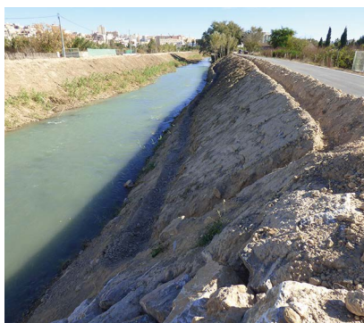
Zanjas longitudinales (superior e inferior) paralelas al cauce
