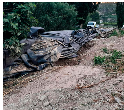
Daños producidos por la DANA de 2019 en zonas de actuación cubiertas con lámina de PEAD
