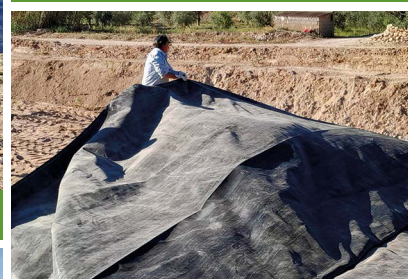
Extensión manual de geotextil
