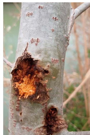
Daños superficiales en tronco afectado
