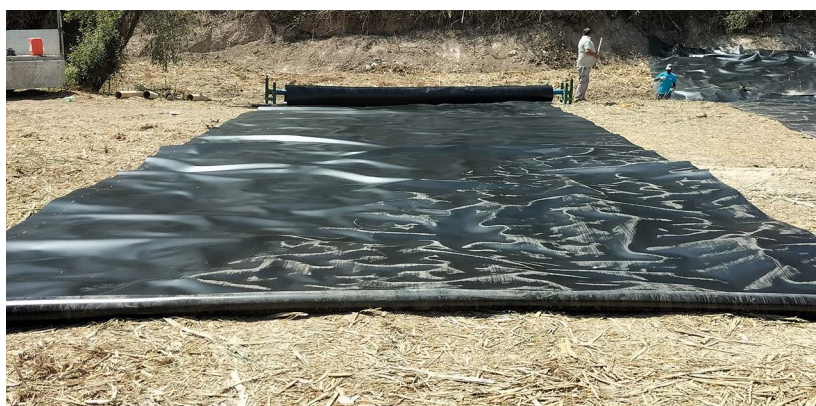
Sistema de desenrollado de lámina con soporte (arriba) y manual (dcha.)
