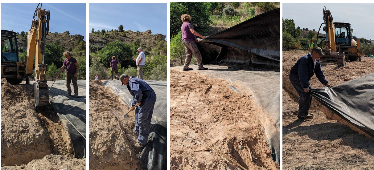
Instalación del primer paño (geotextil)
