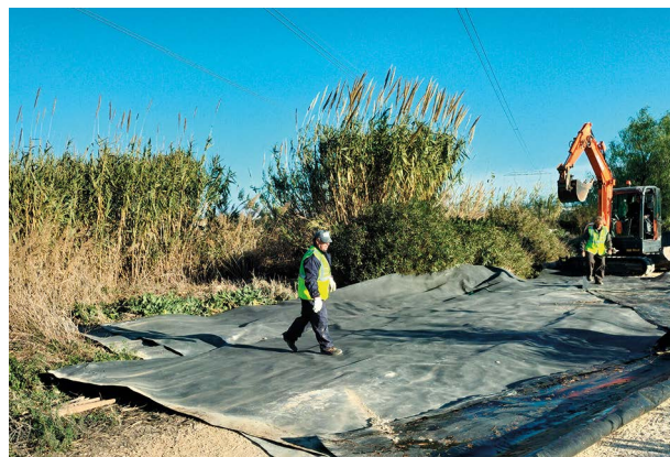
Proceso de retirada de lámina de PEAD
