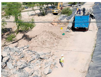
Daños producidos por la DANA de 2019 en zonas de actuación cubiertas con lámina de PEAD
