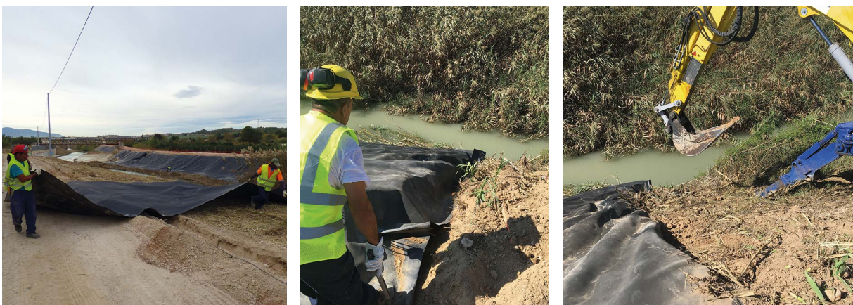
Instalación del primer paño (PEAD)
