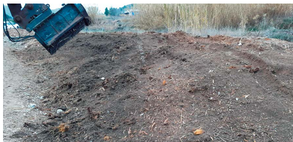
Desbroce mecanizado en formaciones monoespecíficas de caña
