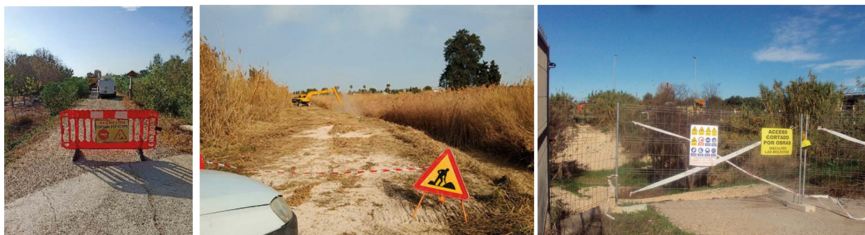
Señalización de la zona de actuación
