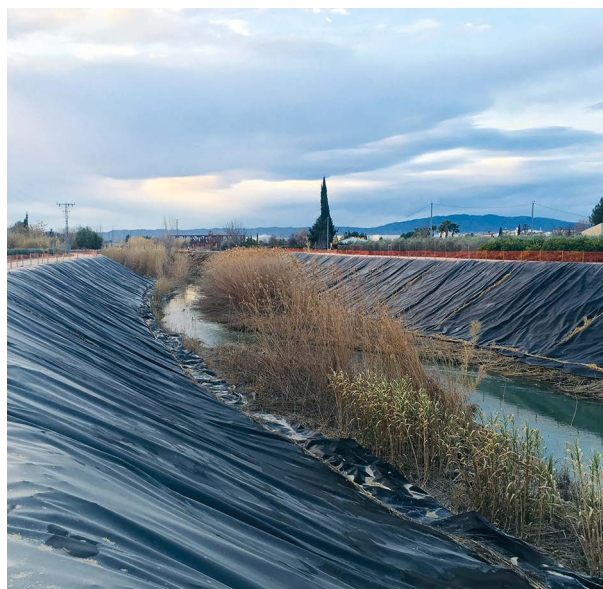
Zona laminada con PEAD
