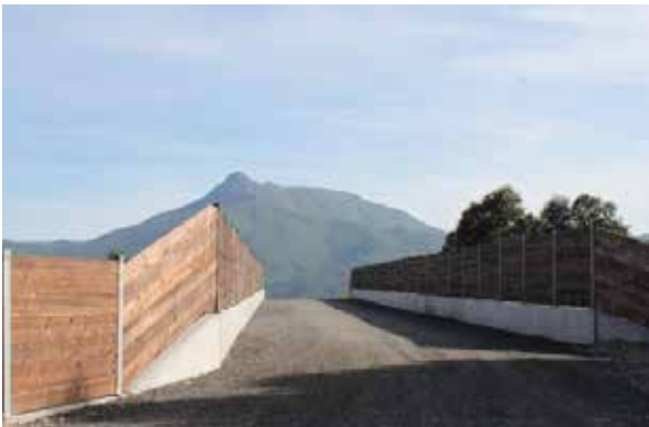
Figura 13.3. En caso de que la aridez u otras causas impidan la revegetación del paso se mantendrá un sustrato natural o de zahorras. Foto: Minuartia.
