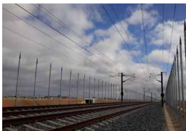
Figura 23.5. Vista general de una pantalla de tubos exentos (PTE) instalada en una línea de ferrocarril (izquierda) y detalle de los postes con un diseño en su parte superior que dificulta el posado de las aves (derecha). Fuente: ADIF - Alta Velocidad y Proyecto LIFE Impacto Cero.
