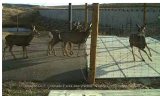
Figura 17.7. Dos tipos de placas electrificadas para impedir el paso de cérvidos. En la derecha se observa la reacción de un cérvido al pisar la placa electrificada, consiguiendo que vuelva al exterior de la vía y evitando que cruce el resto del grupo. Fotos: C. Rosell y Colorado DOT, Colorado Parks and Wildlife & Wildlife Connectivity Institute.
