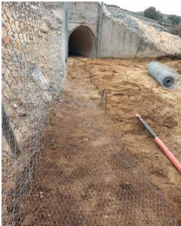
Figura 14.11. Refuerzo de malla de triple torsión en forma de L en la parte basal de un vallado para lince. Foto: Junta de Comunidades de Castilla - La Mancha.
