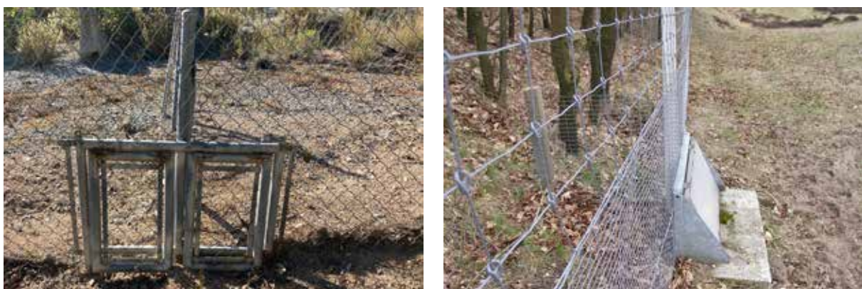
Figura 16.6. A la izquierda, puerta de escape doble. A la derecha, puerta de escape específica para tejón. Ambos ejemplos disponen de vallado, perpendicular al cerramiento, para interceptar los movimientos de la fauna y guiarlos hacia las puertas de salida. Este tipo de dispositivos requieren frecuentes acciones de conservación y, si no cuentan con un mantenimiento adecuado, pueden convertirse en puntos de entrada de fauna al interior de la vía. Fotos: M. Oñorbe y C. Rosell.
