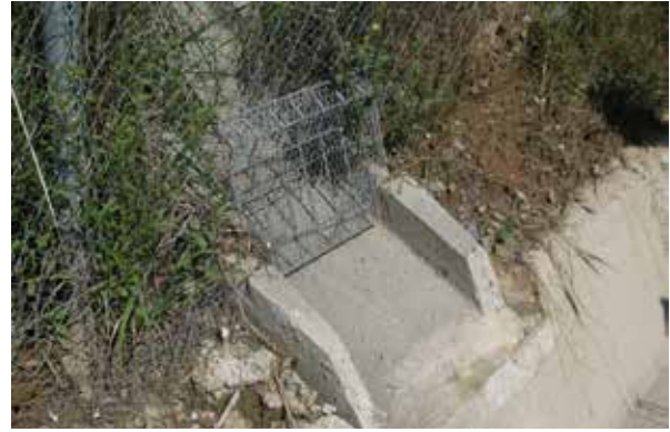
Figura 14.6. Dos alternativas de sistemas destinados a impedir el paso de animales por los puntos de intersección del cerramiento con las cunetas de drenaje perimetral. Fotos: Minuartia.
