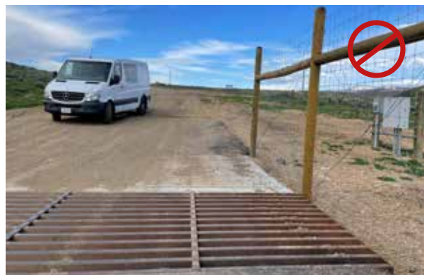
Figura 17.11. Debe evitarse la instalación de los dispositivos en zonas en pendiente, ya que ello facilita que el sustrato de los caminos cubra las placas electrificadas o llene las zangas de los pasos canadienses, reduciendo así su efectividad. Foto: P. Kramer – Wildlife Connectivity Institute.
