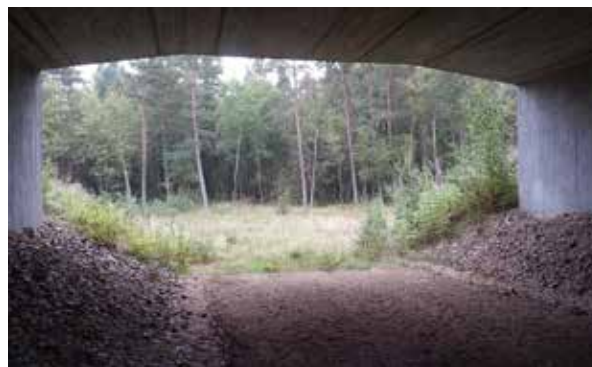
Figura 6.3. Paso inferior con la base de sustrato natural. La ausencia de luz y humedad impide el crecimiento de vegetación en el interior de la estructura. Foto: C. Rosell.
