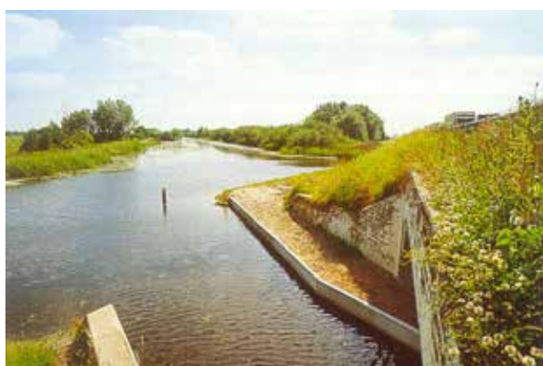
Figura 9.3. Plataforma lateral que facilita una óptima conexión de las plataformas secas del drenaje con los hábitats naturales de su entorno. Foto: H. Bekker.
