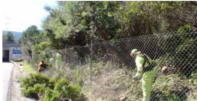
Figura 26.5. Desbroces en ambos lados de los vallados perimetrales para facilitar su conservación y gestión. Fuente: Túneles BCS.
