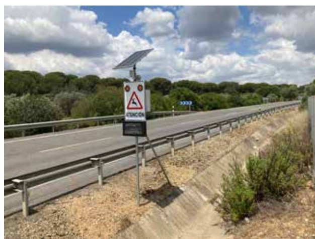
Figura 19.5. Señal activada por detectores de fauna en un paso de fauna a nivel. Foto: M. Oñorbe.
