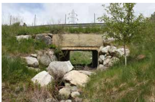
Figura 8.5. Integración del acceso en los taludes del terraplén. Foto: M. Fernández Bou.
