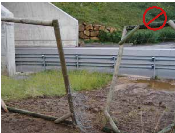
Figura 14.16. La falta de mantenimiento facilita la entrada de animales en las vías. Foto: F. Navàs.
