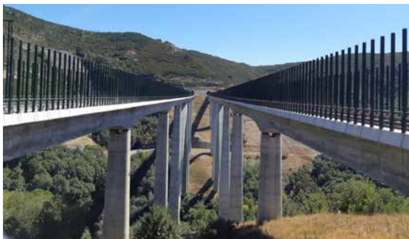
Figura 23.4. Pantalla de tubos sobre un viaducto en una vía de ferrocarril de alta velocidad. Foto: ADIF - Alta Velocidad.
