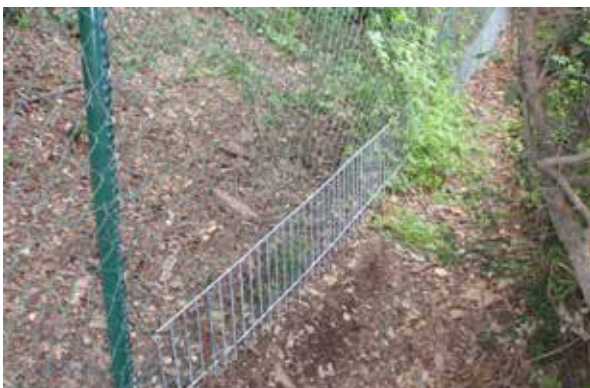
Figura 14.8. Refuerzo para jabalí de malla electrosoldada rígida en un tramo del vallado especialmente conflictivo. Foto: Túnel Barcelona-Cadí.
