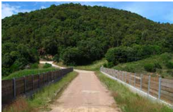
Figura 3.3. Paso superior con camino en el sector central de la estructura y dos franjas laterales revegetadas para la fauna. Foto: Departament de Territori, Habitatge i Transició Ecològica, Generalitat de Catalunya.
