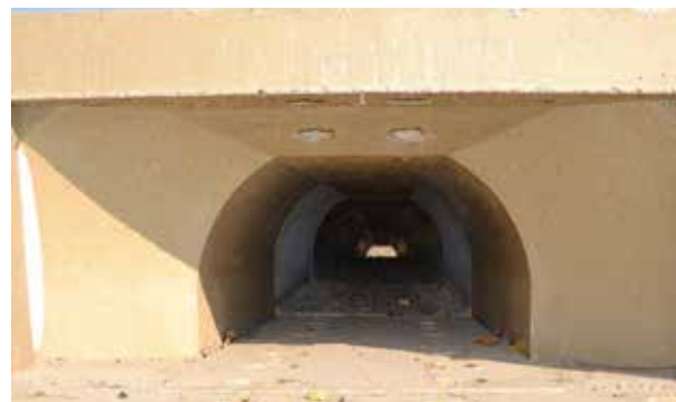
Figura 11.4. Vista del interior de un paso para anfibios de sección semicircular. Las paredes verticales y la base plana facilitan el avance de los anfibios. Foto: M. Puky.
