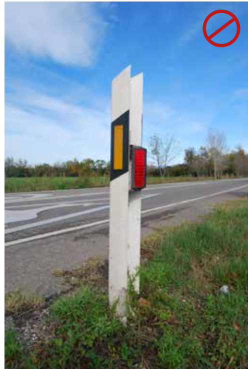
Figura 20.3. No se aconseja la instalación de reflectores (de distintos tipos) que refractan la luz de los faros de los vehículos proyectándola hacia el entorno de la vía, ya que distintos seguimientos han mostrado su reducida efectividad por la rápida habituación de los animales. Fotos: C. Rosell.
