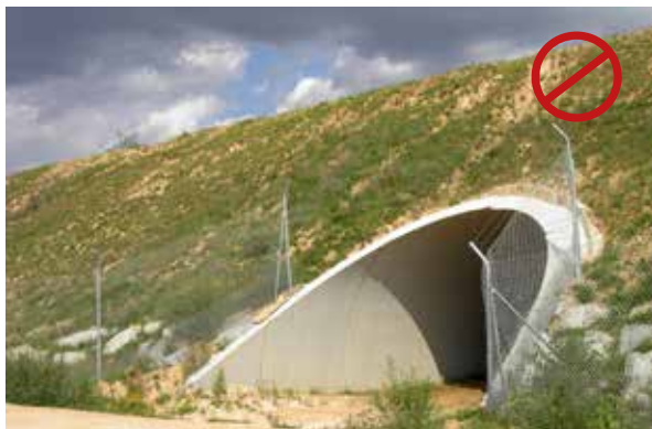
Figura 14.14. La malla debe conducir al paso sin dejar zonas abiertas de acceso al talud. Foto: C. Rosell.
