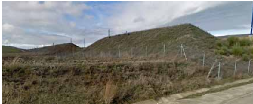
Figura 23.2. Caballones de tierra contruidos en el margen de una línea de ferrocarril para forzar a las aves a elevar su trayectoria de vuelo. Foto: ADIF - Alta Velocidad.
