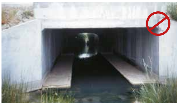
Figura 9.10. Falta de rampas que conecten las franjas secas con las zonas adyacentes. Foto: F. Navàs.
