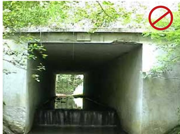
Figura 10.4. Escalón en el interior del drenaje que supone un obstáculo para el movimiento de fauna acuática. Foto: J. Dufek.
