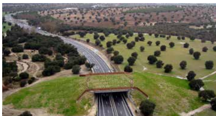
Figura 2.3. La instalación de pantallas opacas permite mitigar los impactos de luz y ruido causados por el tráfico asociado a la infraestructura. Foto: Comunidad de Madrid.
