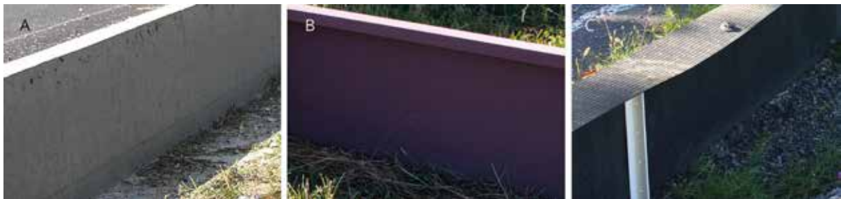
Figura 15.3. El uso de materiales alternativos que provean una superficie lisa y opaca, como el hormigón (A), metal (B) o polímeros reciclados (C), son especialmente indicados para especies trepadoras como los anfibios y los reptiles. Fotos: Animex Internacional y Minuartia ('IENE Biodiversity and Infrastructure Handbook').
