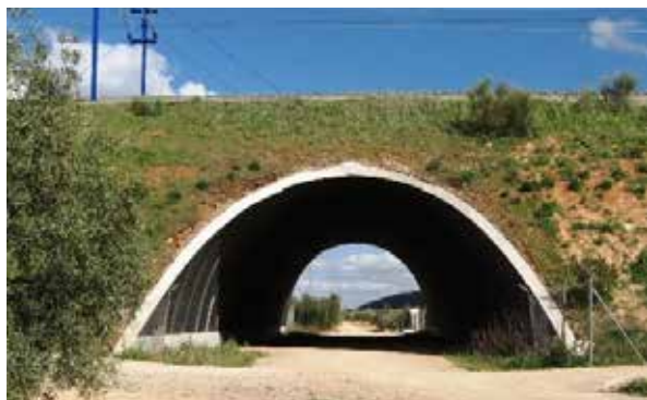
Figura 6.2. Bóveda que permite una gran sección sin tabiques. Foto: ADIF.
