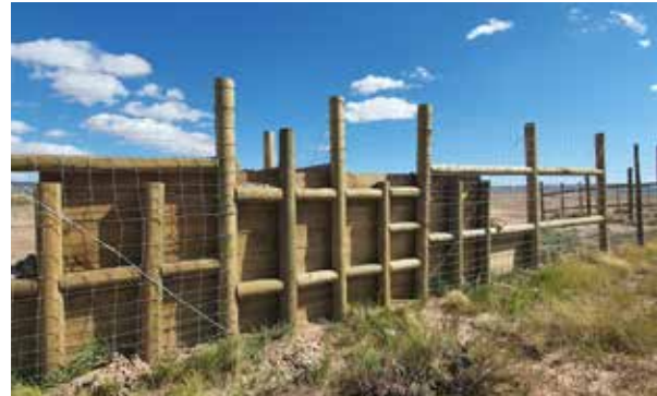
Figura 16.1. Rampa de tierra compactada que dispone de un tramo de valla perpendicular al cerramiento perimetral para facilitar el acceso de animales y conducirlos hacia la zona de salto al exterior. Vistas desde el interior y el exterior del cerramiento. Fotos: C. Rosell.
