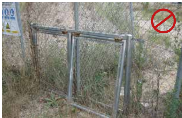
Figura 16.8. Puertas basculantes de escape para medianos carnívoros que quedan entreabiertas a causa de la oxidación de las bisagras, crecimiento de vegetación u otras deficiencias, constituyendo un punto de entrada de animales al interior del vallado. Fotos: F. Navàs.
