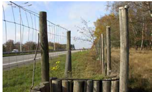
Figura 16.2. Rampa de doble sentido, de tierra compactada, en las que los animales que siguen el vallado son conducidos hacia al exterior del cerramiento perimetral. La madera tratada y la revegetación mejoran su integración con el entorno. Fotos: C. Rosell.
