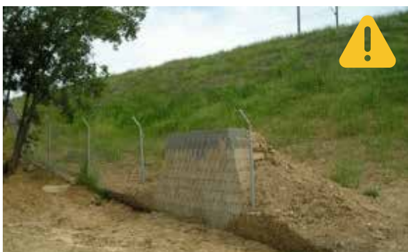
Figura 16.3. Dos alternativas de rampas situadas en terraplenes. A la izquierda, rampa en medio cono en la base de un terraplén. A la derecha, rampa a medio terraplén, y creando una discontinuidad en el vallado que facilita el salto al exterior. Fotos: CEDEX y M. Olsson ('IENE Biodiversity and Infrastructure Handbook').
