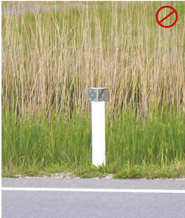
Figura 20.3. No se aconseja la instalación de reflectores (de distintos tipos) que refractan la luz de los faros de los vehículos proyectándola hacia el entorno de la vía, ya que distintos seguimientos han mostrado su reducida efectividad por la rápida habituación de los animales. Fotos: C. Rosell.
