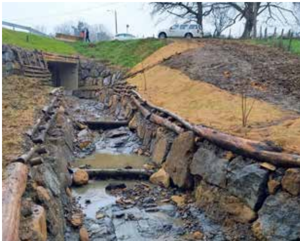
Figura 27.1. El uso de técnicas de bioingeniería en los cursos fluviales que atraviesan las vías de transporte, frente a otras técnicas como las canalizaciones hormigonadas, facilita el restablecimiento de la vegetación y mejora la infiltración. Fotos: Diputación Foral de Bizkaia.
