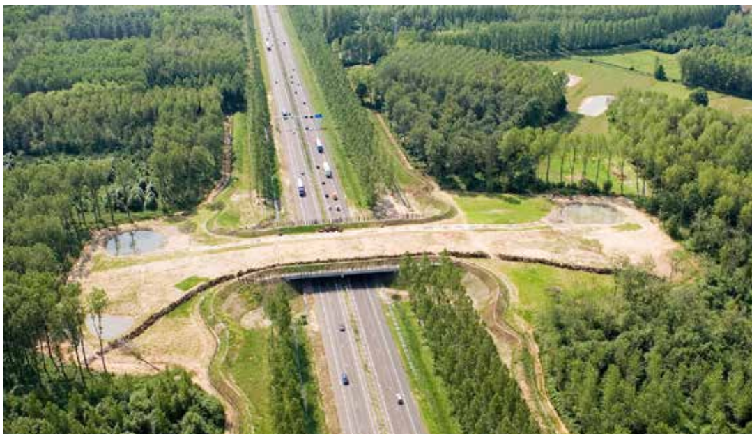
Figura 12.2. Acondicionamiento de accesos de un ecoducto que combina motas de tierra e hileras de ramas que facilitan refugios y conducen a los animales hacia la estructura. Las balsas también tienen la función de atraer a la fauna. Foto: H. Bekker.
