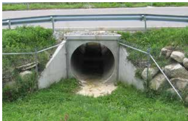
Figura 12.6. Correcta instalación del cerramiento perimetral adosado a las aletas de un paso. Foto: M. Fernández Bou.
