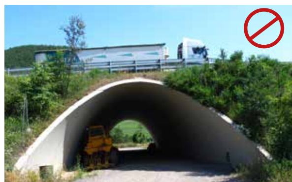
Figura 7.8. Uso inadecuado del interior de un paso inferior multifuncional para estacionar maquinaria. Foto: M. Fernández Bou.
