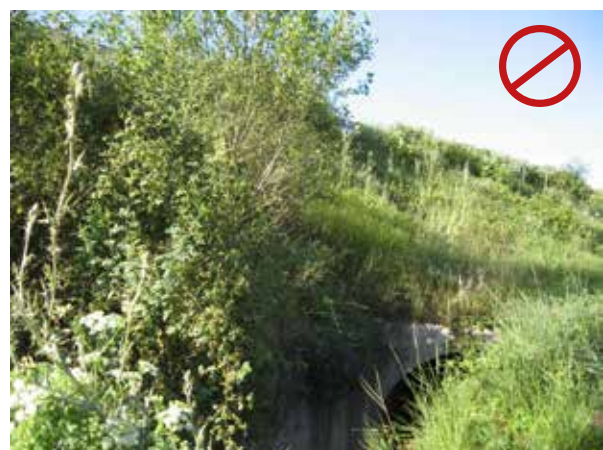
Figura 12.8. La existencia de franjas de vegetación conectando el hábitat de los márgenes del curso de agua con la calzada facilita la conducción de los animales hacia esta, aumentando la probabilidad de atropello. Foto: F. Navàs.
