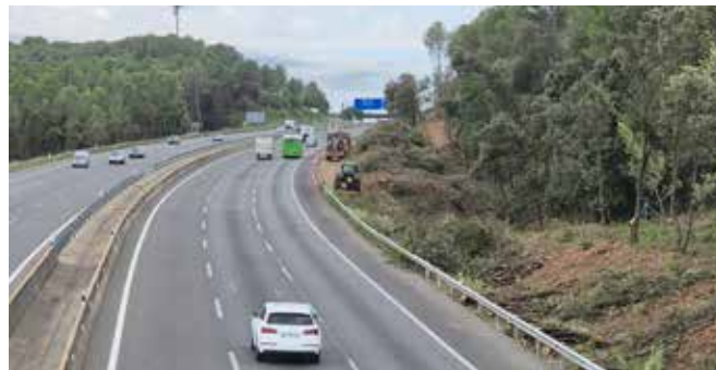
Figura 26.2. Los desbroces y/o talas de árboles en las proximidades de la calzada pueden ser recomendables para evitar el inicio o propagación de incendios forestales a través de márgenes de las vías de transporte. Foto: C. Rosell.
