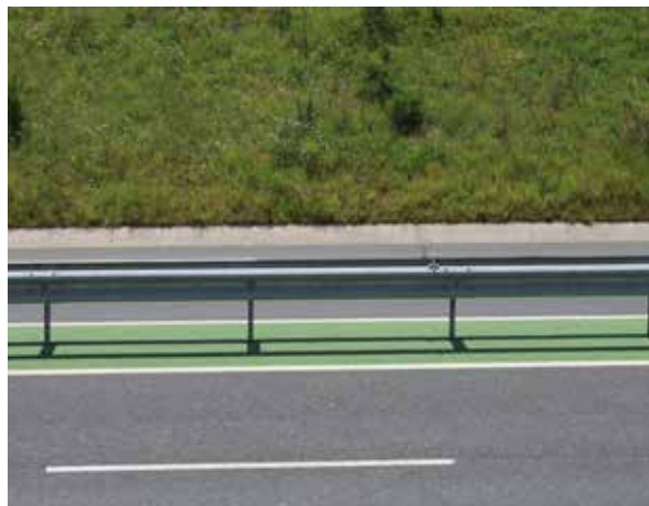
Figura 22.2. Mediana de separación de carriles sin vegetación que puede ser adecuada en tramos en los que la proliferación de topillos u otras presas, podrían atraer a rapaces o carnívoros comportando un aumento del riesgo de atropellos. Foto: C. Rosell.
