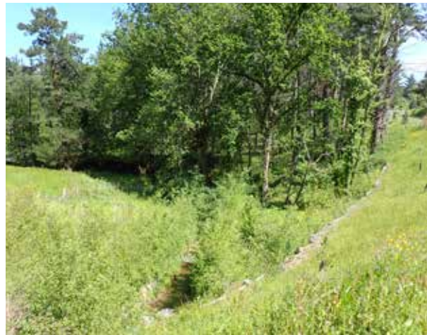
Figura 27.1. El uso de técnicas de bioingeniería en los cursos fluviales que atraviesan las vías de transporte, frente a otras técnicas como las canalizaciones hormigonadas, facilita el restablecimiento de la vegetación y mejora la infiltración. Fotos: Diputación Foral de Bizkaia.
