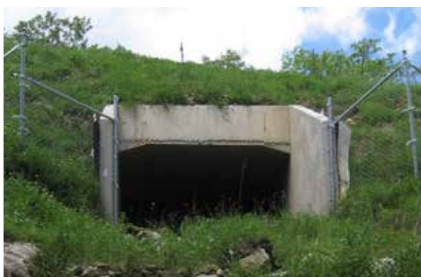
Figura 8.4. La correcta colocación del cerramiento facilita la localización de los accesos. Foto: M. Fernández Bou.
