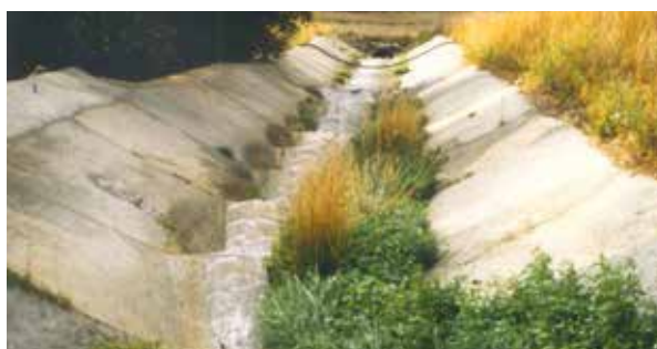
Figura 9.8. Bajante de protección del terraplén con las paredes laterales en pendiente, adaptadas para facilitar los movimientos de fauna. Foto: C. Rosell.
