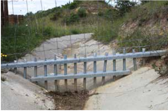
Figura 14.6. Dos alternativas de sistemas destinados a impedir el paso de animales por los puntos de intersección del cerramiento con las cunetas de drenaje perimetral. Fotos: Minuartia.
