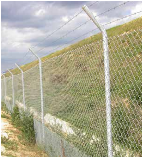
Figura 15.4. Cerramientos que combinan voladizo en su parte superior, para impedir el salto de cérvidos, y refuerzo basal para evitar el acceso de pequeños vertebrados. Foto: M. Fernández Bou.
