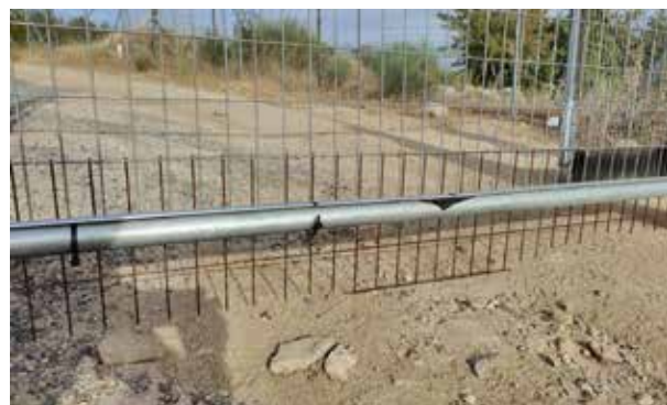
Figura 17.6. Refuerzos de malla electrosoldada adosados a puertas para evitar el acceso de fauna por debajo de las mismas. Fotos: Minuartia y Junta de Comunidades de Castilla-La Mancha.
