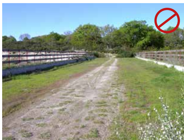
Figura 2.9. Circulación motorizada por un paso superior específico para la fauna y pantalla lateral que no es completamente opaca. Foto: C. Rosell.
