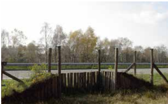
Figura 16.2. Rampa de doble sentido, de tierra compactada, en las que los animales que siguen el vallado son conducidos hacia al exterior del cerramiento perimetral. La madera tratada y la revegetación mejoran su integración con el entorno. Fotos: C. Rosell.
