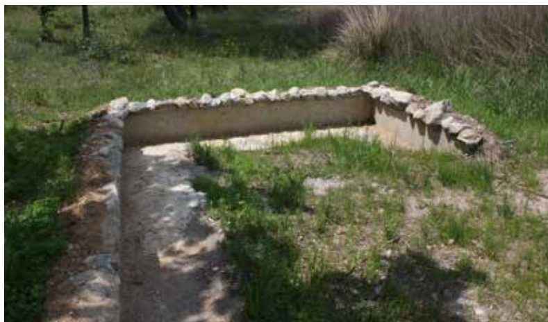
Figura 11.8. Los extremos de las estructuras de guía deben tener forma de 'U' para que los animales que se hayan desplazado en dirección opuesta al paso retornen a los hábitats circundantes y no puedan acceder a la calzada. Foto: Minuartia.
