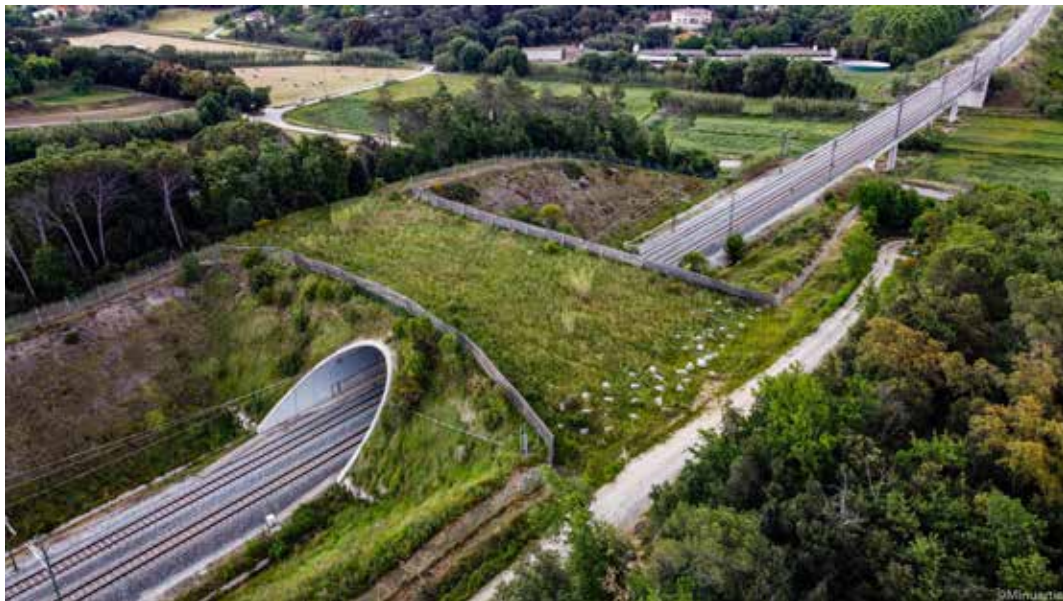
Figura 1.12. La instalación de piedras o troncos en los accesos de los ecoductos impide la entrada de vehículos al mismo. Otra opción es instalar barreras de postes de madera o metálicas dispuestas a una altura adecuada y con señalización indicando la prohibición de circulación de vehículos. Foto: ADIF - Minuartia.
