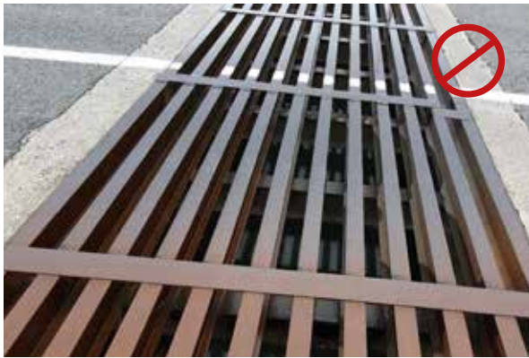
Figura 17.8. Los soportes transversales a las barras deben disponerse por debajo de éstas evitando así que queden superficies por las que puedan cruzar algunos animales. Foto: C. Rosell.
