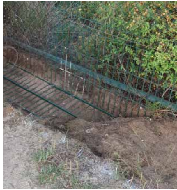
Figura 15.5. Refuerzo de malla electrosoldada rígida en forma de L en la parte basal del cerramiento para evitar el acceso de especies excavadoras como el conejo o el zorro. Foto: Aeropuerto de Barcelona.
