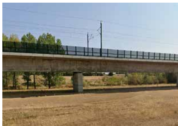
Figura 23.3. Las pantallas metálicas permiten elevar la altura del vuelo de las aves reduciendo el riesgo de mortalidad por colisión. Las pantallas opacas (izquierda), además, permiten reducir la contaminación acústica en los hábitats circundantes. Fotos: ADIF - Alta Velocidad.
