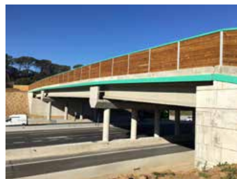
Figura 1.7. Las pantallas de madera tratada o placas de hormigón tintado requieren menor mantenimiento que la vegetación. Foto: C. Rosell ('IENE Biodiversity and Infrastructure Handbook').
