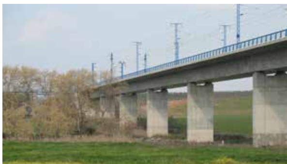
Figura 5.4. Viaducto por el que discurren diversos hábitats, facilitando su uso por una mayor cantidad de especies. Foto: ADIF.
