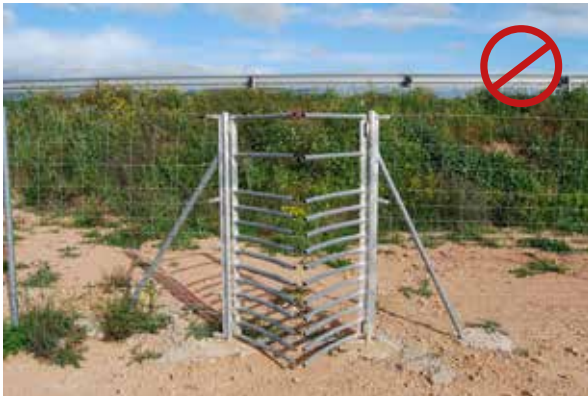
Figura 16.7. Diseño de un portillo de escape para ungulados que posibilita que se mantenga abierto permitiendo el libre acceso de animales (y personas) al interior del tramo vallado. Fotos: F. Navàs.
