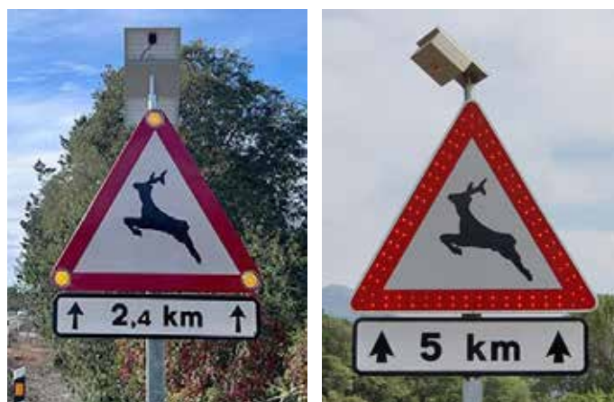
Figura 18.1. Señales P-24 reforzadas mediante la inclusión de luces destellantes en sus vértices (izquierda) y mediante la iluminación LED del triángulo rojo exterior (derecha). Fotos: Minuartia.
