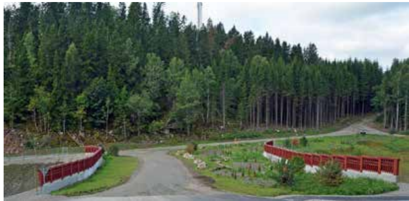
Figura 13.2. Adaptación de un paso superior de restitución de un camino. La instalación de la pantalla opaca evita perturbaciones generadas por el tráfico de la vía que discurre bajo el mismo. El sustrato naturalizado deja márgenes que se han revegetado, sin instalar bordillos ni barreras de separación. Foto: M. Linqvist.
