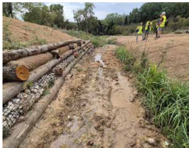
Figura 27.2. La aplicación de Soluciones basadas en la Naturaleza para la estabilización de taludes facilita su colonización por comunidades de flora y fauna, y contribuye a aumentar la resiliencia de la infraestructura. Foto: Minuartia.
