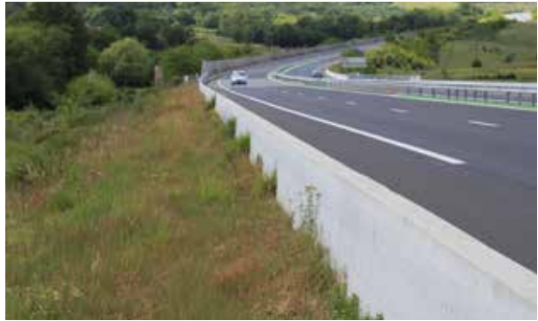
Figura 11.6. Cerramiento opaco de hormigón liso que constituye una óptima estructura de guía. Foto: C. Rosell.
