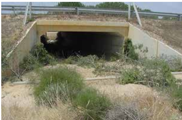
Figura 12.5. La disposición de hileras de ramas y las revegetaciones facilitan la conducción de la fauna hacia el interior de la estructura. Foto: P. Robles.
