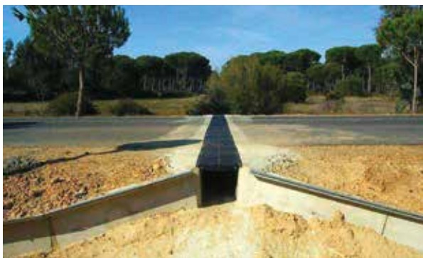
Figura 11.3. Paso de anfibios con estructura de guía formando embudo. Foto: GIASA.
