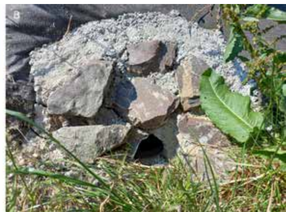
Figura 26.6. Refugios para fauna construidos mediante piedras. A: Hilera de piedras en un paso superior específico para la fauna proveyendo refugio para invertebrados, reptiles y pequeños mamíferos. B: Entrada de un refugio para micromamíferos instalado en un paso superior específico para la fauna en Francia. Fotos: Minuartia ('IENE Biodiversity and Infrastructure Handbook').
