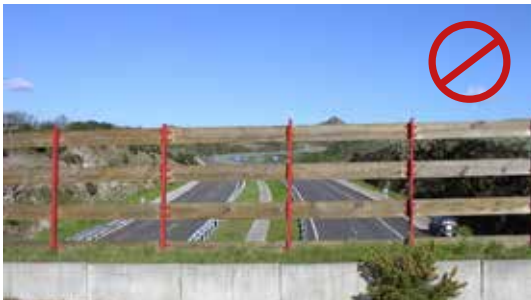
Figura 13.8. Las pantallas para reducir las perturbaciones en la superficie del paso deben ser completamente opacas. Foto: Minuartia.
