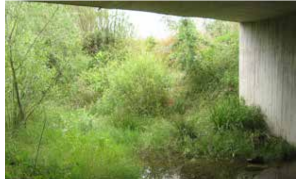
Figura 12.4. La existencia de vegetación natural hasta la entrada del drenaje facilita la conducción de los animales, favoreciendo su funcionalidad. Foto: M. Fernández Bou.
