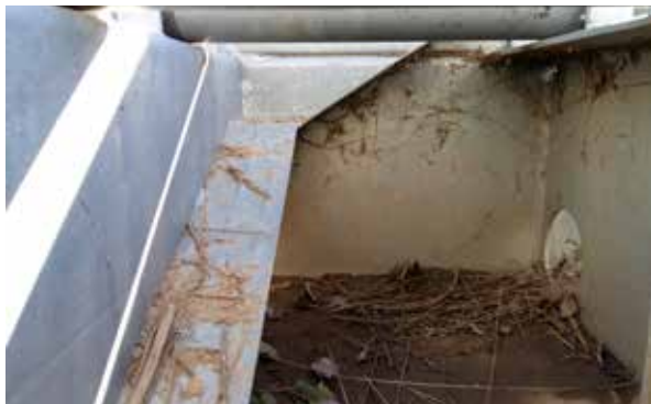
Figura 17.5. Sistema de rampa de salida para animales de pequeño tamaño cuando no es posible disponer de paredes laterales abiertas. Es preferible que la superficie de la rampa sea rugosa (derecha) para facilitar el desplazamiento de la fauna. Fotos: Minuartia.
