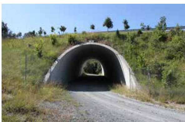
Figura 7.4. El camino sin pavimentar y el cerramiento bien adosado a las aletas favorecen el paso de fauna. Foto: M. Fernández Bou.
