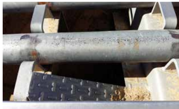
Figura 17.5. Sistema de rampa de salida para animales de pequeño tamaño cuando no es posible disponer de paredes laterales abiertas. Es preferible que la superficie de la rampa sea rugosa (derecha) para facilitar el desplazamiento de la fauna. Fotos: Minuartia.
