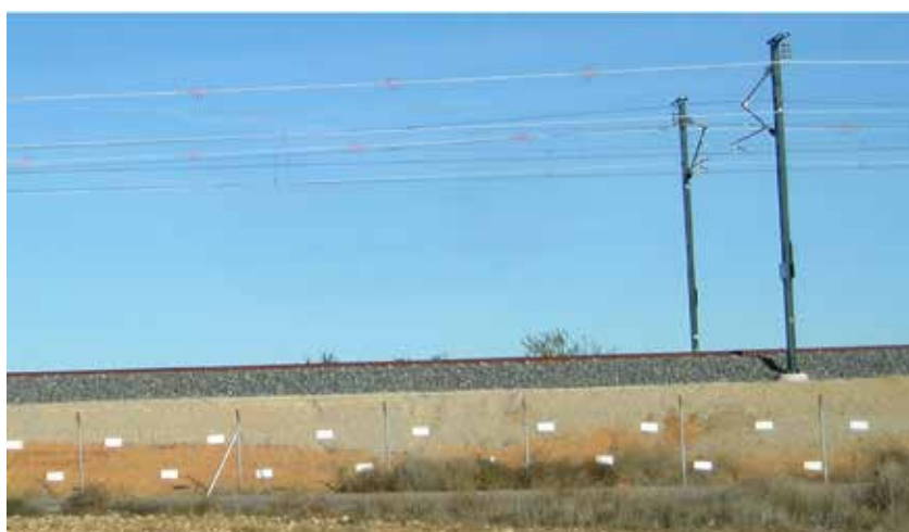
Figura 23.6. Señalización del tendido de la catenaria y del cerramiento mediante espirales y placas, respectivamente, en un tramo de línea de ferrocarril de alta velocidad que discurre por una zona con presencia de aves esteparias. No se dispone de datos de seguimiento sobre la efectividad de esta medida. Foto: CEDEX.
