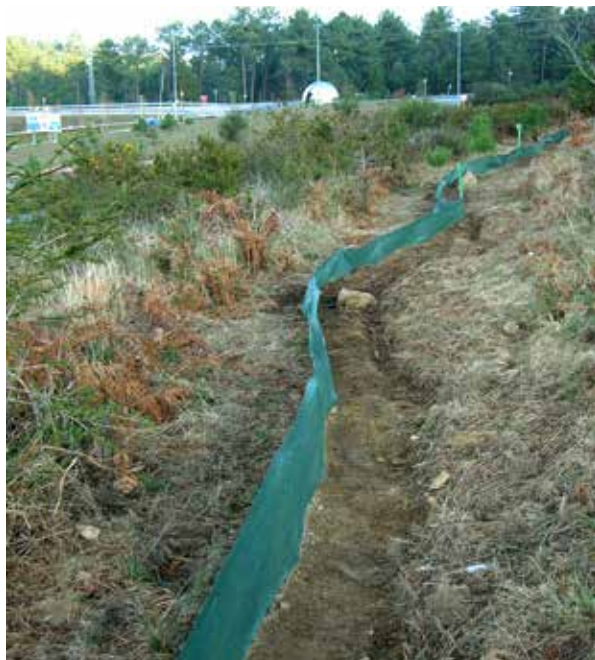
Figura 11.9. Barrera temporal que se combina con cubos de recogida. Foto: Oficina de Medio Ambiente, Universidad de Vigo.
