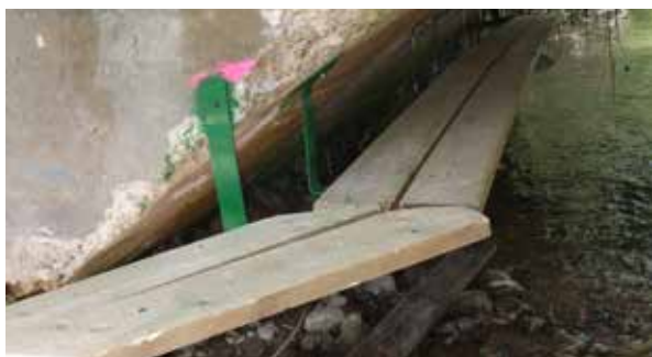
Figura 9.5. Plataforma para facilitar el desplazamiento de animales por el interior de un drenaje. Foto: Consejería de Fomento y Medio Ambiente, Junta de Castilla y León.
