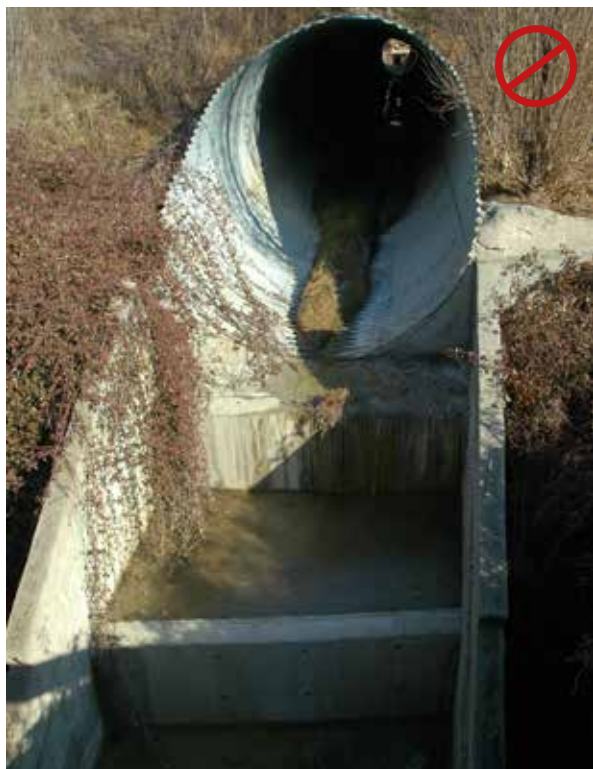
Figura 9.11. Bajante escalonado que constituye una trampa para la fauna. Foto: F. Navàs.
