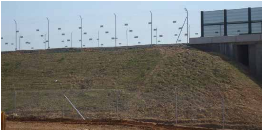
Figura 24.2. Marcaje del cerramiento perimetral mediante placas de color blanco para aumentar su visibilidad y reducir las colisiones de aves. Foto: ADIF - Alta Velocidad.
