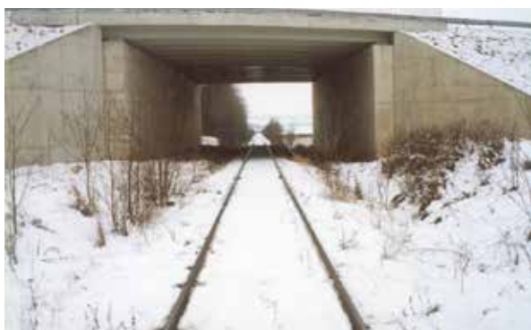
Figura 7.2. Paso de una vía de ferrocarril que combina el paso poco frecuente de trenes con el de fauna. Foto: V. Hlavac.
