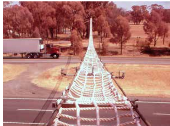
Figura 4.3. Paso de puente de malla. Se recomienda el uso de materiales ignífugos para evitar la propagación de fuego, especialmente en zonas con alto riesgo de incendio forestal. Foto: K. Soanes.
