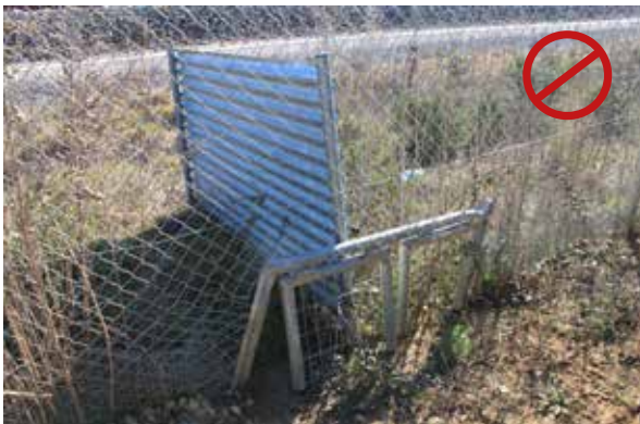
Figura 16.8. Puertas basculantes de escape para medianos carnívoros que quedan entreabiertas a causa de la oxidación de las bisagras, crecimiento de vegetación u otras deficiencias, constituyendo un punto de entrada de animales al interior del vallado. Fotos: F. Navàs.
