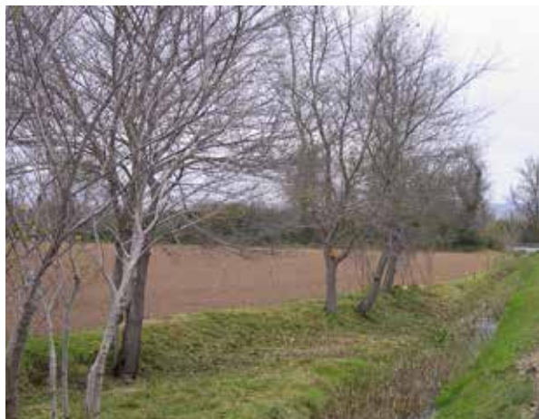
Figura 22.1. Desbroces para facilitar la visibilidad a los conductores y reducir los refugios para los animales en un tramo de carretera con alta concentración de accidentes causados por jabalíes y cérvidos. Foto: C. Rosell.
