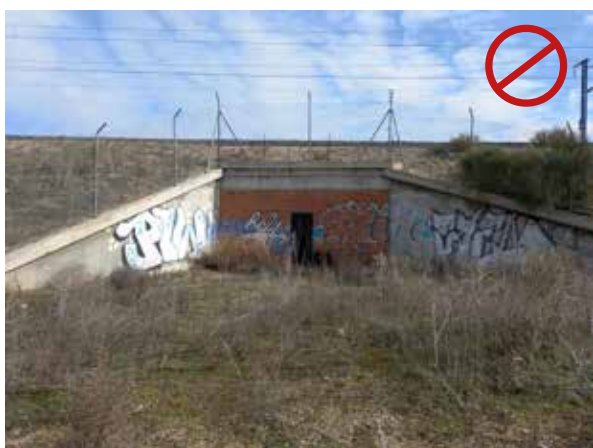
Figura 6.10. Los usos inadecuados pueden inhabilitar los pasos de fauna. En la imagen izquierda el paso se ha cerrado con tabiques, mientras que en la derecha se aprecian restos que delatan un frecuente uso de la estructura por personas, difícil de compatibilizar con el uso por parte de fauna silvestre. Fotos: Minuartia.
