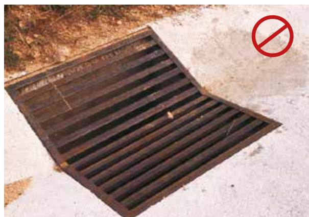
Figura 25.5. Las rejillas protectoras de pozos o arquetas deben ser densas para evitar la caída de pequeños animales en su interior. Además, es preferible que las paredes de estos se adapten para facilitar la salida de animales. Foto: C. Rosell.
