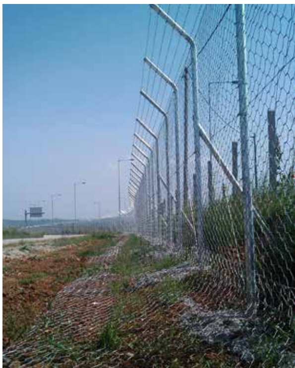
Figura 14.10. Vallado específico para oso instalado en autopistas en Grecia, que cuenta con voladizo superior y faldón inferior (antes de ser enterrado). Foto: L. Georgiadis.
