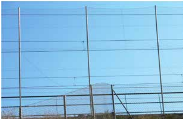
Figura 15.6. Cerramiento anticolidión para murciélagos de 5 m de altura y malla de simple torsión en una línea de ferrocarril de alta velocidad. Foto: ADIF.
