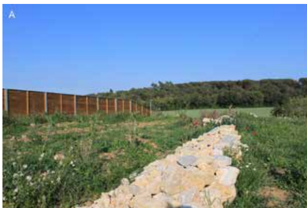
Figura 26.6. Refugios para fauna construidos mediante piedras. A: Hilera de piedras en un paso superior específico para la fauna proveyendo refugio para invertebrados, reptiles y pequeños mamíferos. B: Entrada de un refugio para micromamíferos instalado en un paso superior específico para la fauna en Francia. Fotos: Minuartia ('IENE Biodiversity and Infrastructure Handbook').
