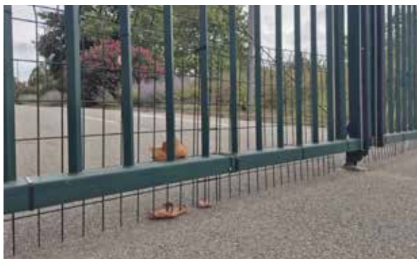
Figura 17.6. Refuerzos de malla electrosoldada adosados a puertas para evitar el acceso de fauna por debajo de las mismas. Fotos: Minuartia y Junta de Comunidades de Castilla-La Mancha.
