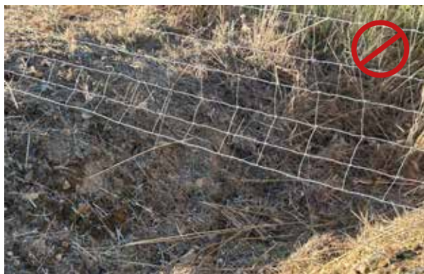
Figura 14.15. Malla sin enterrar que ha sido levantada por los animales. Foto: M. Oñorbe.
