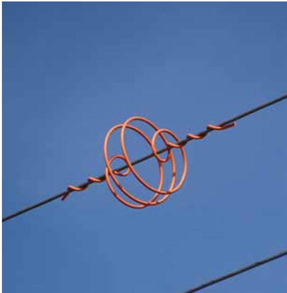
Figura 23.7. Detalle de una espiral instalada para aumentar la visibilidad de un tendido eléctrico. Existen gran diversidad de elementos que se aplican a la señalización de líneas de suministro, que no se tratan en detalle en este documento. Foto: J.Uhlikova ('IENE Biodiversity and Infrastructure Handbook').
