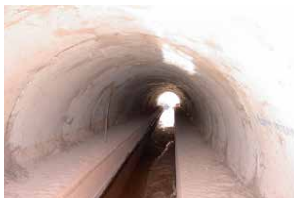
Figura 9.4. Interior de una bóveda con plataformas laterales secas. Foto: F. Navàs.
