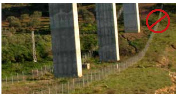
Figura 5.10. Sector bajo un viaducto con cerramiento perimetral en un extenso sector de su longitud, que impide el paso de los animales. Foto: Minuartia.
