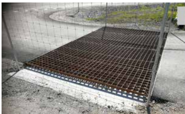
Figura 17.4. Los pasos de rejilla (tipo 'tramex') son una variante de paso canadiense que no requiere la construcción de fosa. Consisten en marcos de rejilla metálica que se disponen sobre la calzada, preferentemente encajados en un marco para permitir extracción y limpieza en caso de colmatado. Fotos: Marcus Elfstrom y Minuarta.
