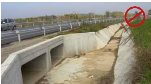
Figura 9.9. Las paredes de la acequia dificultan el retorno de los animales al entorno. Foto: F. Navàs.
