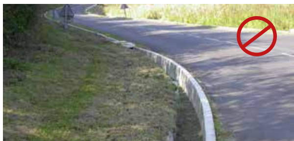
Figura 11.13. Las zanjas de recogida de anfibios que los conducen a las entradas de pasos ubicadas en su interior constituyen trampas para otros animales de pequeño tamaño. Foto: C. Rosell.
