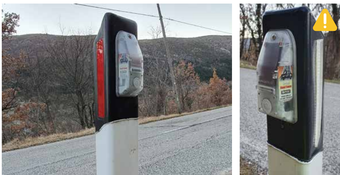
Figura 20.2. Dispositivos disuasorios instalados sobre hitos de arista y activados mediante los faros de los vehículos (también denominados 'barrera virtual'). En este caso no cuentan con detectores de fauna y sólo son operativos en período nocturno o crepuscular. Fotos: Minuartia.
