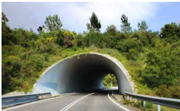
Figura 2.4. Paso situado en un tramo entre desmontes que permite depositar materiales excedentes de la excavación. Foto: M. Fernández Bou.
