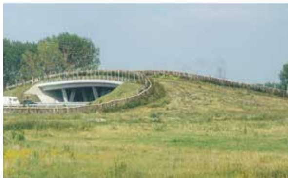
Figura 2.5. Paso situado en un terreno llano, con rampas de acceso con ligera pendiente. Foto: P. Farkas.
