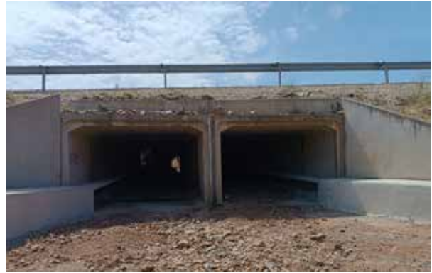
Figura 13.7. Adaptación de un drenaje mediante la instalación de banquetas secas laterales de hormigón a ambos lados de la estructura, antes y después de la actuación. Fotos: Junta de Comunidades de Castilla-La Mancha.
