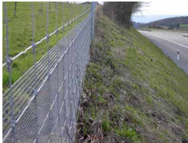
Figura 15.2. Instalación de un refuerzo para pequeña fauna en la parte exterior del cerramiento convencional. Este refuerzo no es aplicable para anfibios, que requieren vallas opacas. Foto: C. Rosell.
