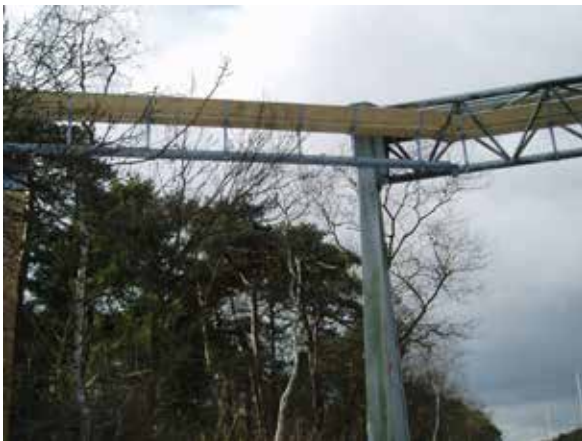
Figura 4.2. Plataformas de madera instaladas en un soporte de señalización de una autopista. Foto: H. Bekker.
