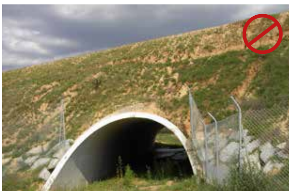
Figura 6.9. El vallado no adosado al interior de las paredes de la bóveda permite que algunas especies puedan acceder al talud en lugar de entrar en el paso. Foto: C. Rosell.
