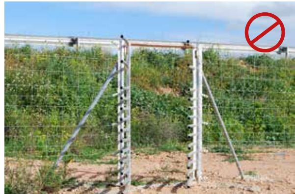
Figura 16.7. Diseño de un portillo de escape para ungulados que posibilita que se mantenga abierto permitiendo el libre acceso de animales (y personas) al interior del tramo vallado. Fotos: F. Navàs.
