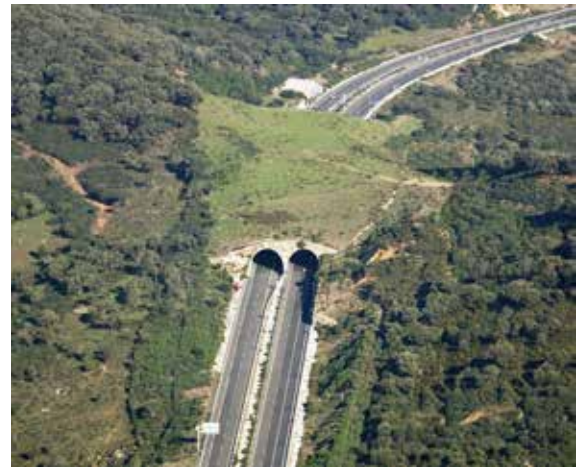
Figura 1.11. Los ecoductos permiten una restauración completa de la conectividad ecológica. Además, permiten depositar materiales excedentes de la excavación, reduciendo los costes y la huella de carbono del proyecto. Foto: GIASA. Junta de Andalucía.
