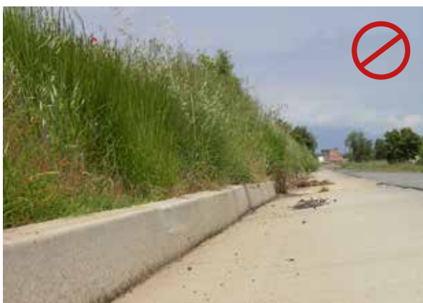
Figura 25.4. La pared vertical de la cuneta supone una barrera para los animales pequeños que caen en el interior de la calzada y no pueden salir de ella. Foto: C. Rosell.
