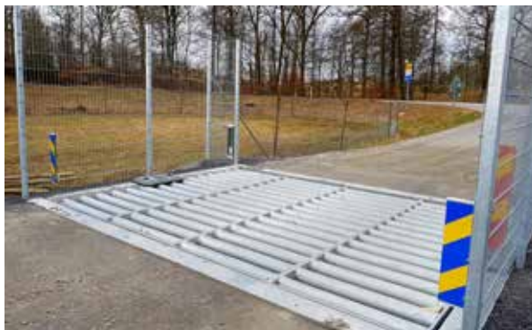
Figura 17.2. Paso canadiense instalado en una carretera de Suecia. Los paneles de malla instalados a ambos lados impiden que los animales puedan utilizar este espacio para acceder a la calzada. Foto: M. Elfstrom - EnviroPlanning.
