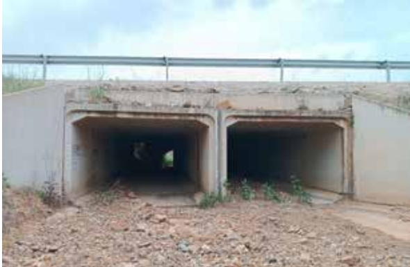
Figura 13.7. Adaptación de un drenaje mediante la instalación de banquetas secas laterales de hormigón a ambos lados de la estructura, antes y después de la actuación. Fotos: Junta de Comunidades de Castilla-La Mancha.
