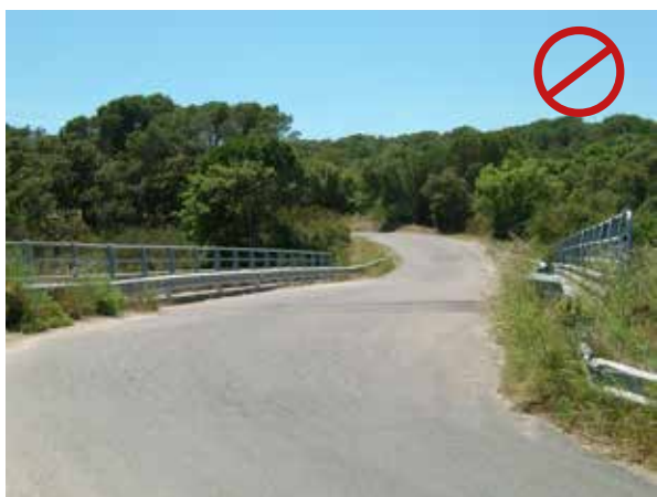
Figura 3.5. Paso que podría haber sido acondicionado para la fauna colocando pantallas de madera y con una revegetación completa de las franjas laterales. Foto: F. Navàs.
