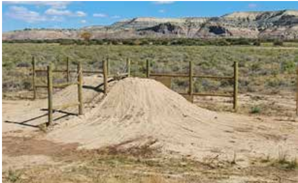
Figura 16.1. Rampa de tierra compactada que dispone de un tramo de valla perpendicular al cerramiento perimetral para facilitar el acceso de animales y conducirlos hacia la zona de salto al exterior. Vistas desde el interior y el exterior del cerramiento. Fotos: C. Rosell.
