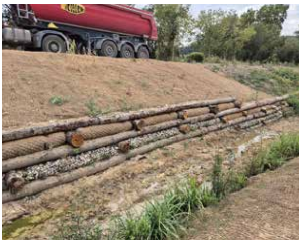
Figura 27.2. La aplicación de Soluciones basadas en la Naturaleza para la estabilización de taludes facilita su colonización por comunidades de flora y fauna, y contribuye a aumentar la resiliencia de la infraestructura. Foto: Minuartia.
