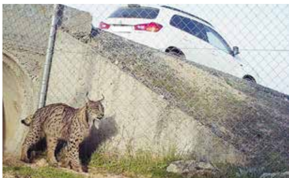
Figura 14.4. Una correcta instalación del vallado perimetral, adosado a las alas de las estructuras transversales (en este caso un drenaje) facilitan su uso por parte de la fauna, reduciendo el riesgo de que puedan acceder a la calzada. Foto: Junta de Comunidades de Castilla-La Mancha.
