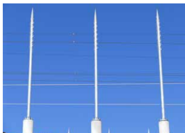
Figura 23.5. Vista general de una pantalla de tubos exentos (PTE) instalada en una línea de ferrocarril (izquierda) y detalle de los postes con un diseño en su parte superior que dificulta el posado de las aves (derecha). Fuente: ADIF - Alta Velocidad y Proyecto LIFE Impacto Cero.
