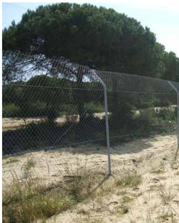
Figura 14.12. Cerramiento específico para lince ibérico. Foto: S. Banuls.
