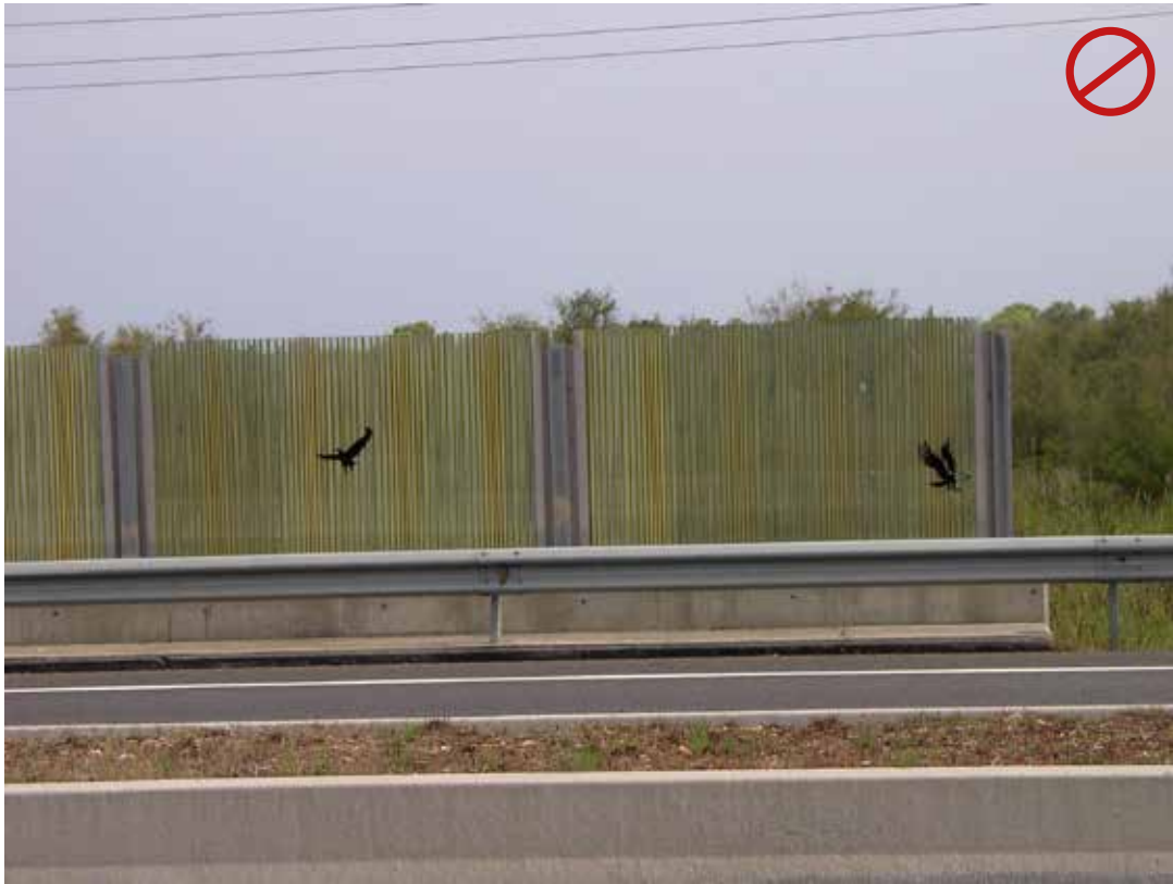
Figura 24.3. Pantalla transparente con siluetas de rapaces que no son efectivas para impedir las colisiones de aves. Además, las bandas verticales no destacan, ya que son del mismo color que la vegetación del entorno. Foto: F. Navàs.
