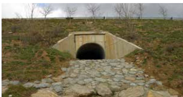
Figura 9.7. Encachado que sustituye un bajante escalonado en la salida de un drenaje. Foto: C. Rosell.
