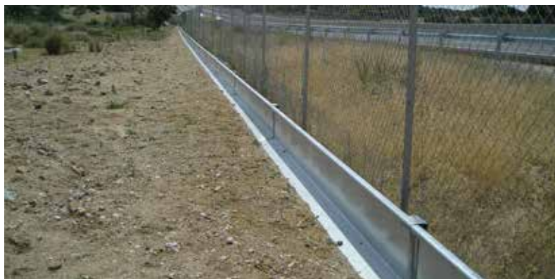
Figura 11.7. Estructura opaca de metal aplicada a un cerramiento perimetral, para guiar los anfibios a los pasos. Requiere un buen anclaje al terreno para evitar que se desprendan las placas. Foto: CEDEX.
