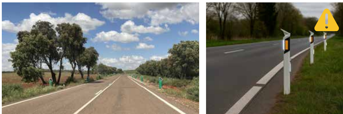
Figura 20.1. Distintos modelos de balizas disuasorias activadas por sensores de fauna que emiten luces y sonidos cuando se aproxima un animal. Algunos modelos cuentan con sensores de vehículos al inicio del tramo por lo cual solo se activan cuando hay tráfico. Fotos: M. Oñorbe y F. Pérez.
