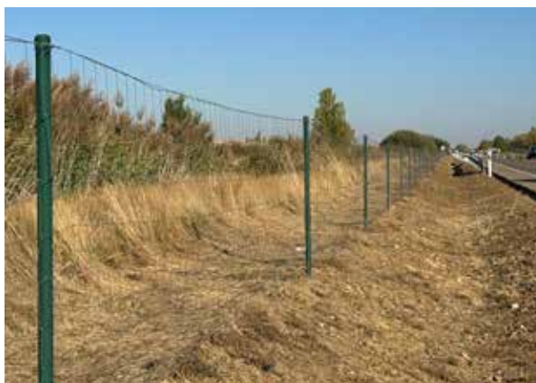
Figura 22.4. Los desbroces de los márgenes de las vías facilitan también la inspección del cerramiento perimetral y reducen el riesgo de propagación de incendios. Foto: M. Oñorbe.
