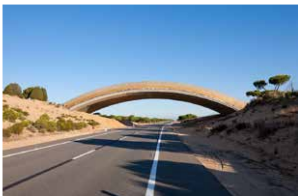
Figura 2.6. Los ecoductos y pasos superiores pueden realizarse aplicando múltiples tipologías constructivas. La que muestra la imagen reduce los materiales y movimientos de tierras necesarios para su construcción. Foto: Agencia de Obras Públicas, Junta de Andalucía (‘IENE Biodiversity and Infrastructure Handbook’).
