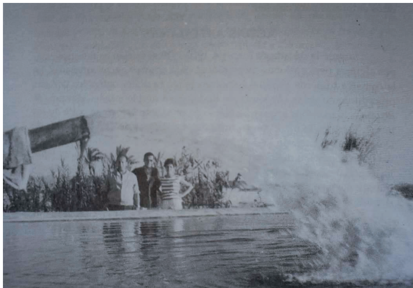
Figura 3.20. Aguas extraídas por pozos en la finca La Capellanía, Torre Pacheco. Fuente: Ferrándiz (2005:344).
