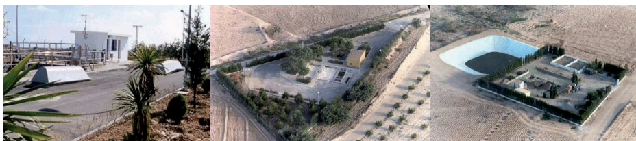
Figura 5.20. EDAR La Murta (izq.), EDAR Corvera (centro) y EDAR Los Martínez del Puerto (dcha.). Fuente: www.esamur.com
