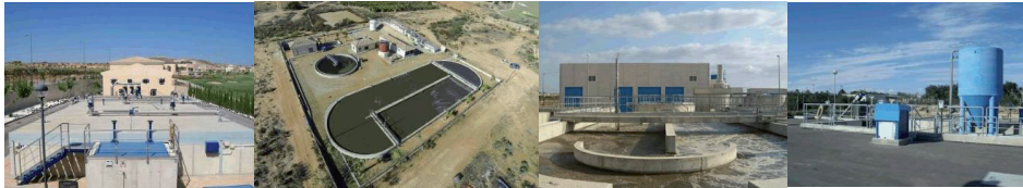
Figura 5.22. EDAR Los Cañares-La Tercia, EDAR Finca El Escobar, EDAR Sucina y EDAR Casas Blancas, de izquierda a derecha. Fuente: www.esamur.com
