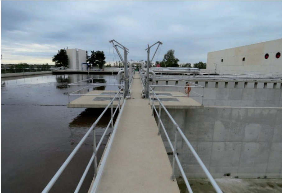
Figura 5.1. Tratamiento secundario en EDAR San Pedro del Pinatar. Foto: M. B. Bernabé-Crespo.
