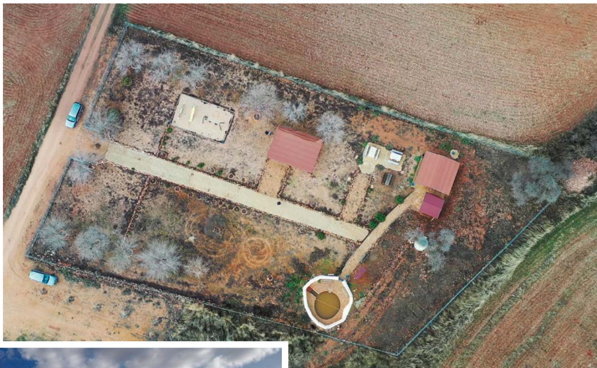
Figura 16.8. Vista general de los Baños del Barranco tras su remodelación en el año 2019 (C. Camuñas, STA CN IGME-CSIC)
