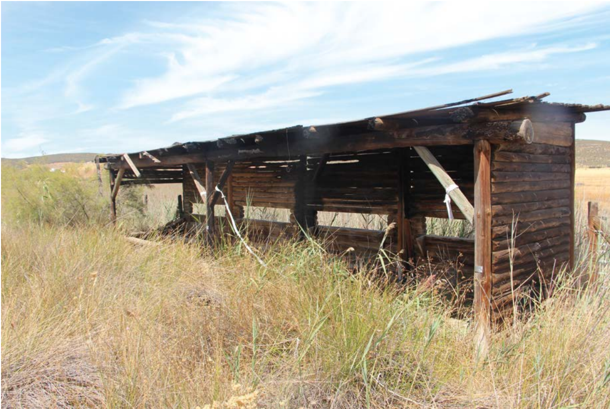
Figura 11.3. Vista de la caseta de observación de aves de la laguna de Caracuel desde la carretera N-420 en septiembre de 2022 (L.A. Carreño)
