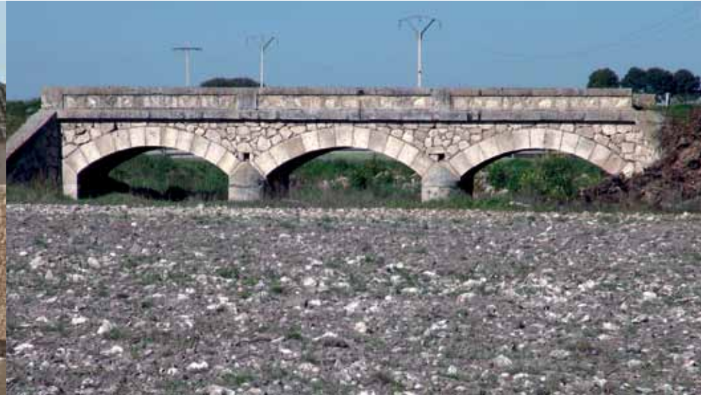
Puente Navarro. El desvío del río ha dejado parte de este puente en seco.
