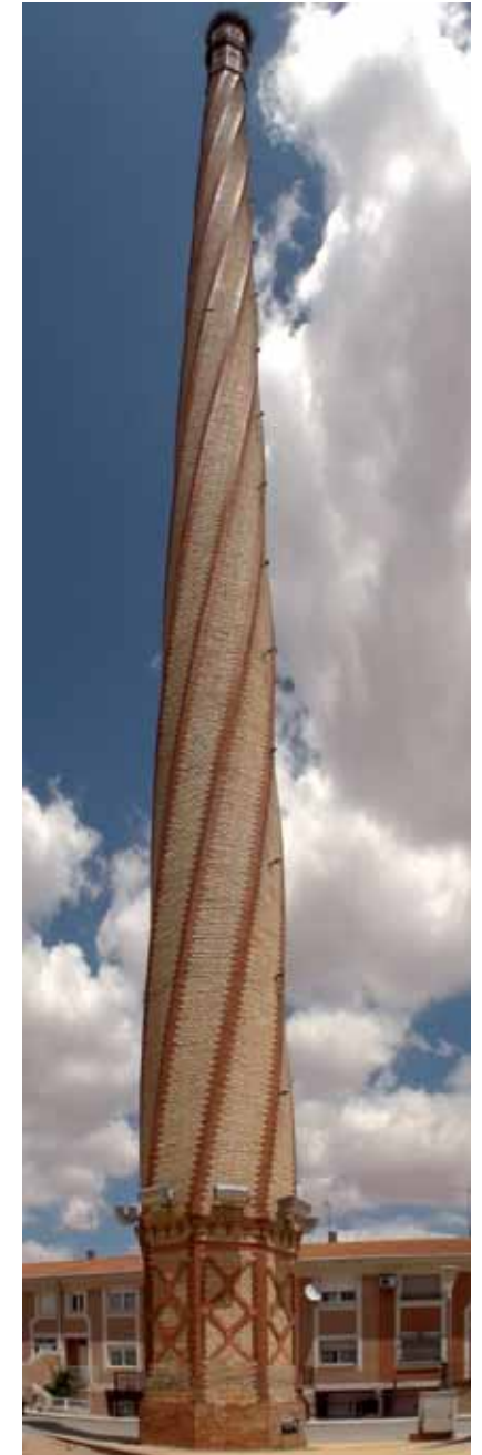
Chimenea de una antigua alcoholera en Tomelloso.
