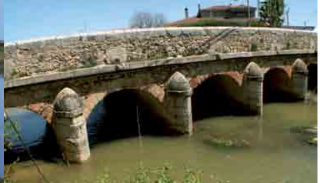
Puente de El Provencio, sobre el río Záncara.
