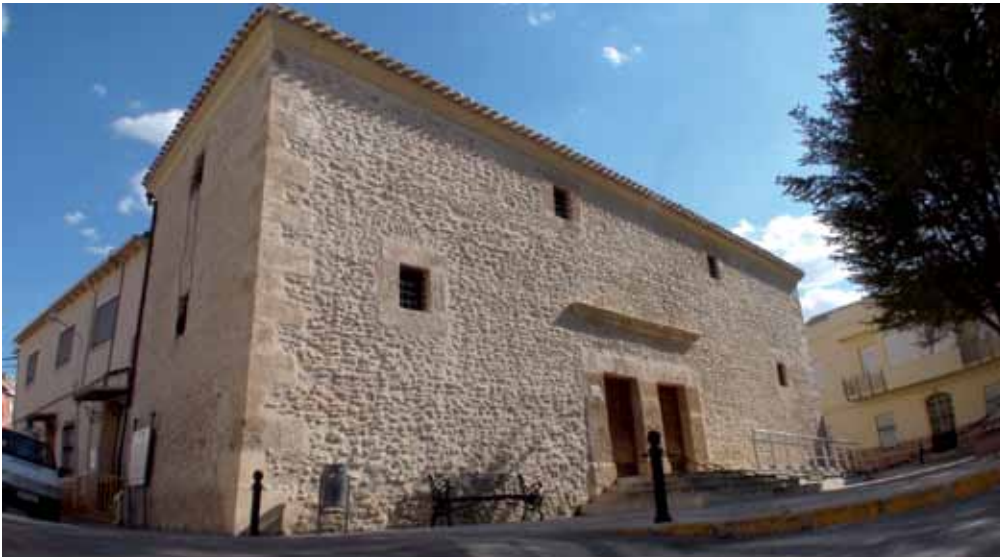
Pósito de la Tercia en Argamasilla de Alba.
