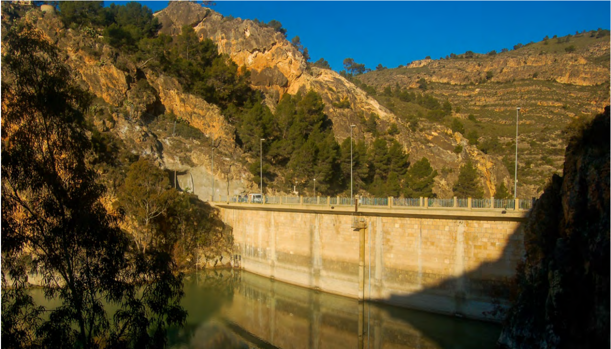
Presa del embalse de Alfonso XIII, construido en los inicios del siglo XX e inaugurado en 1915 por dicho rey. Este embalse estaba contemplado en el Plan Gasset y su principal función era amortiguar y laminar las avenidas.
