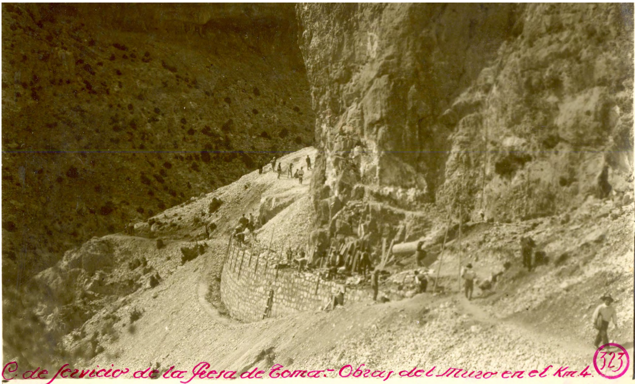
Construcción del camino de servicio para llegar a la Presa de Toma. Se aprecia lo agreste del paisaje y la necesidad de estabilizar el terreno mediante grandes hormas de piedra. Fuente: archivo MCT.
