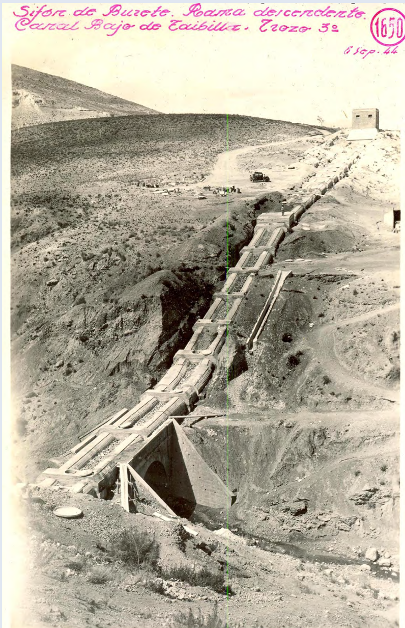
Construcción del sifón de Burete en la sierra homónima, cerca de Cehegin.
