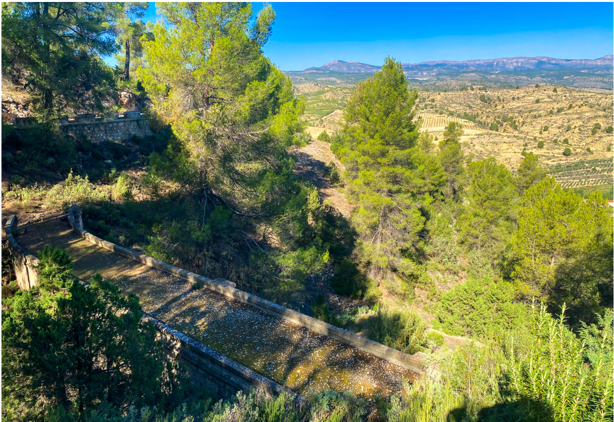
Perspectiva del Canal Alto desde el Camino de Servicio unos kilómetros más abajo de la localidad de Vizcable. Se aprecia la hondonada del valle del río Taibilla y, al fondo, las grandes elevaciones de la Sierra del Segura.
