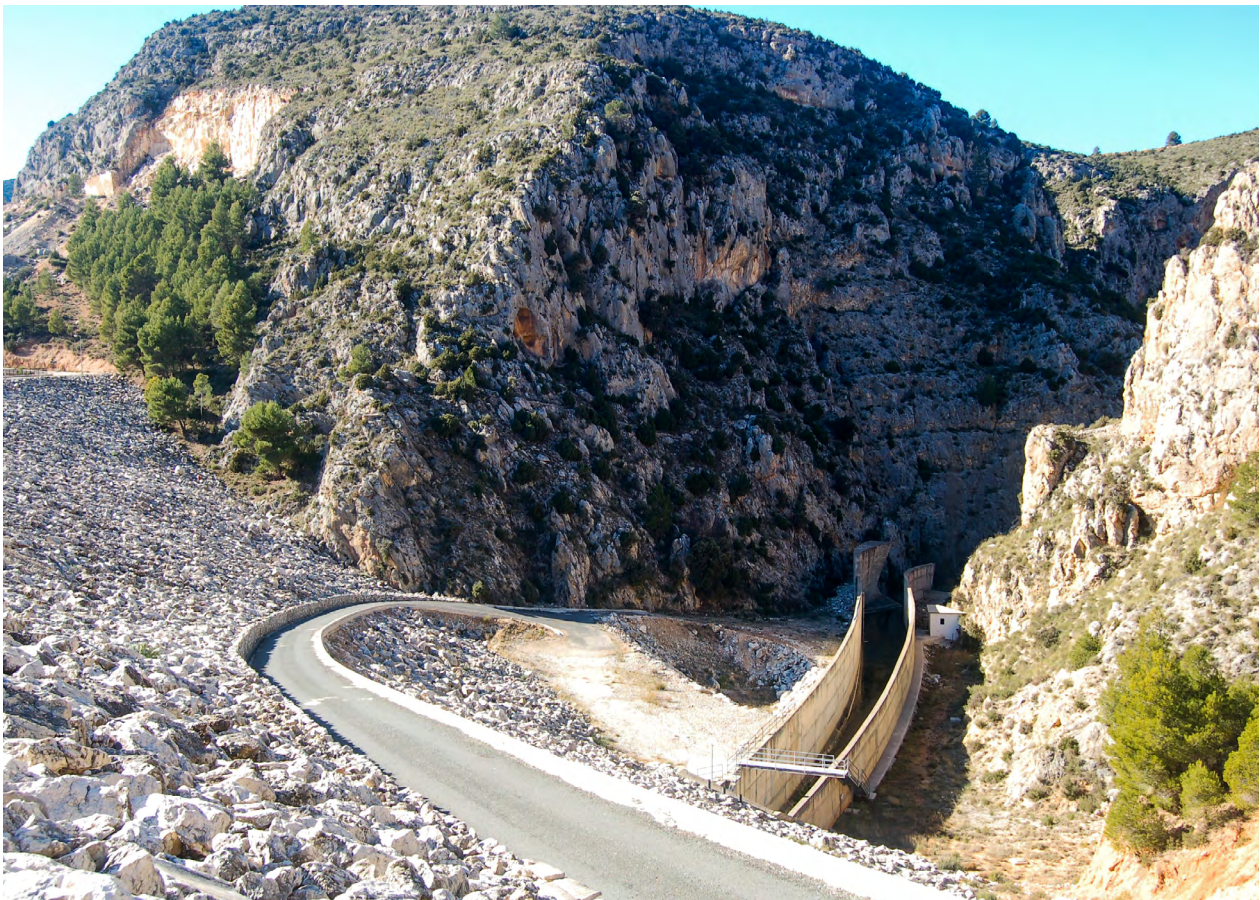
Aliviadero del embalse del Taibilla, en la cabecera del Estrecho del Aire.
