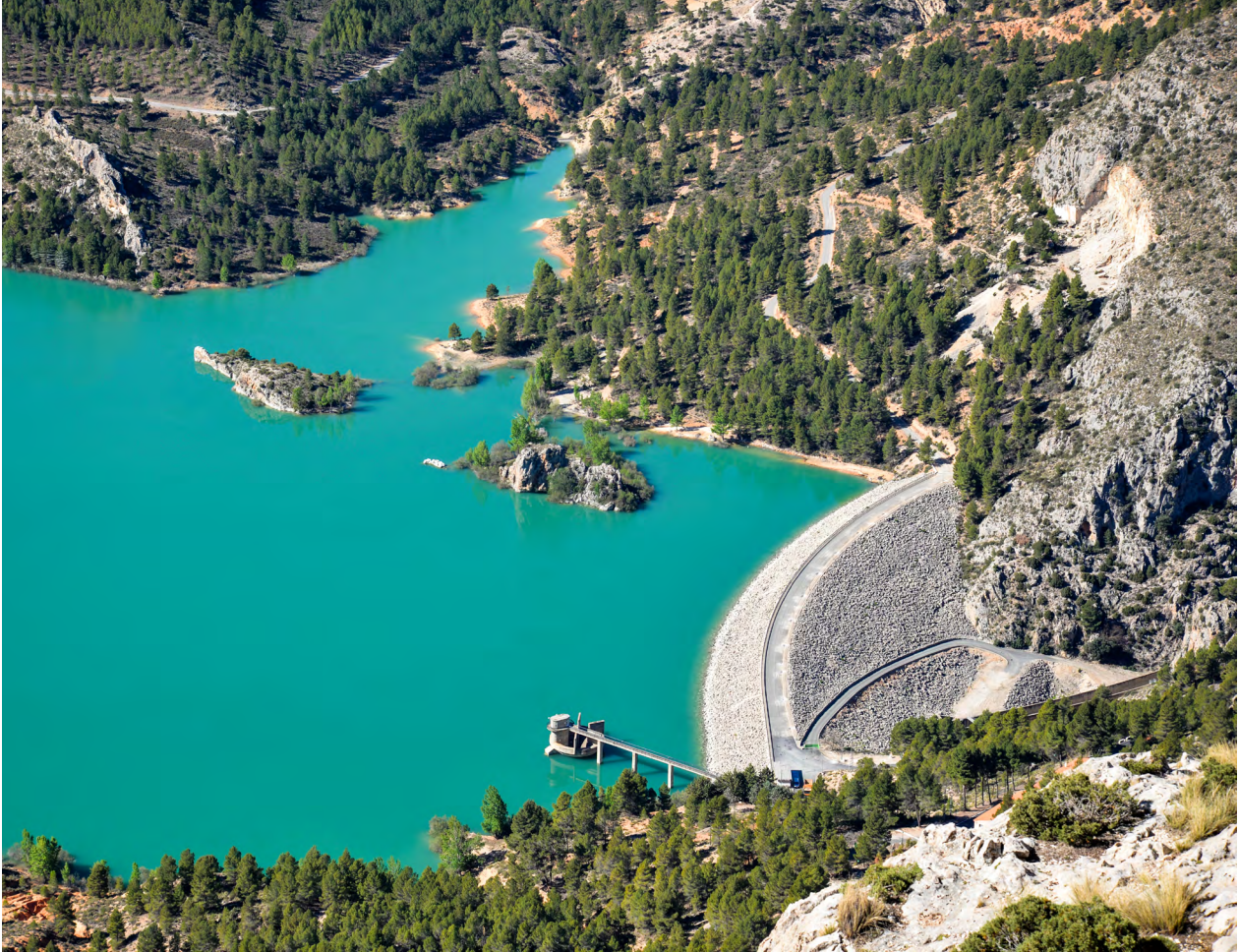
Vista de la Presa del Embalse desde el propio Puntal del Aire.
