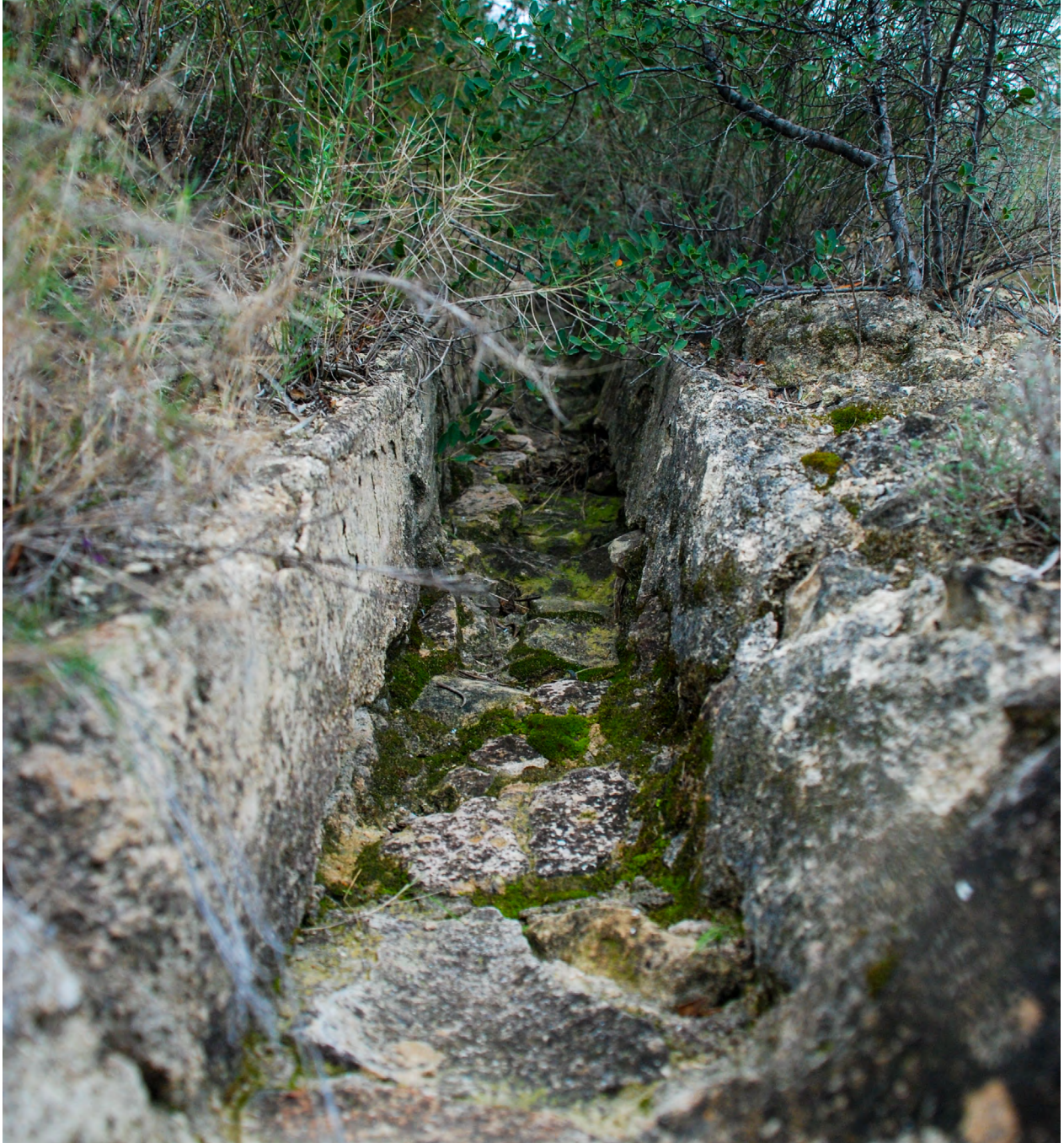
Caño de piedra para conducir agua desde el manantial del Madroñal hacia las paratas aledañas. Cara norte de la sierra del Oro.
