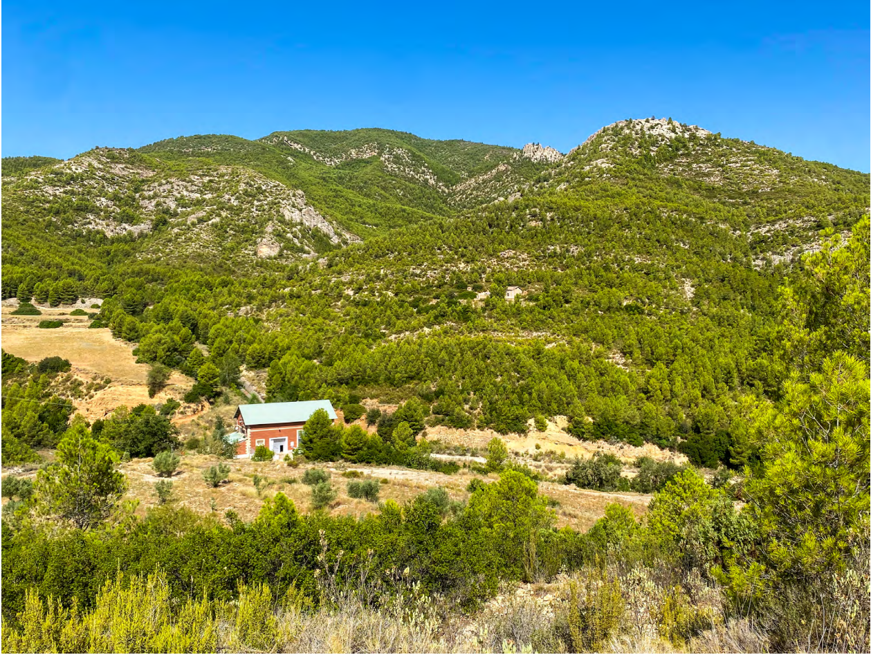
Central hidroeléctrica de la Murta, en el caserío del Campanero.
