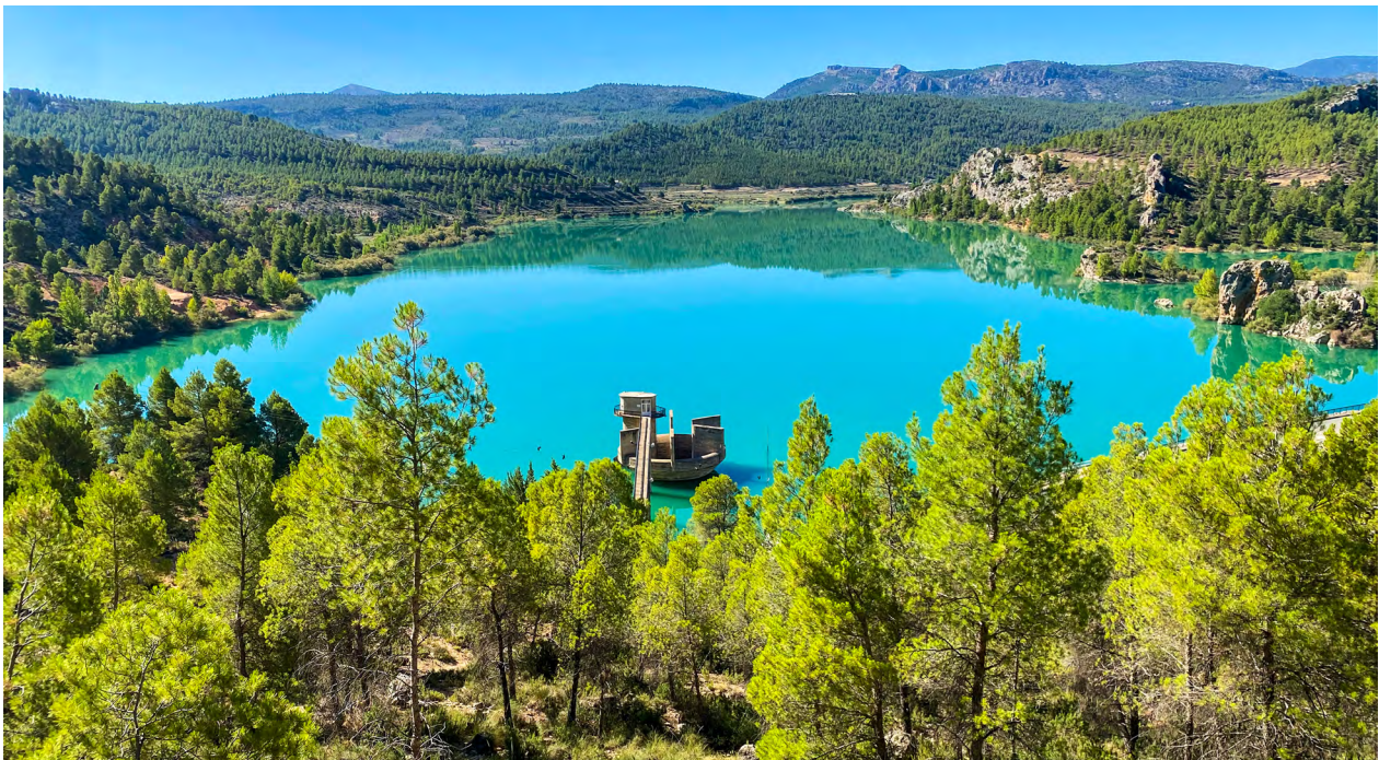
Presa de Embalse, ubicada el término municipal de Nerpio en la vega de Turrilla, unos kilómetros por debajo del casco urbano de Nerpio. Obsérvese el cambio en la cubierta vegetal de las laderas del embalse (año 2023).
