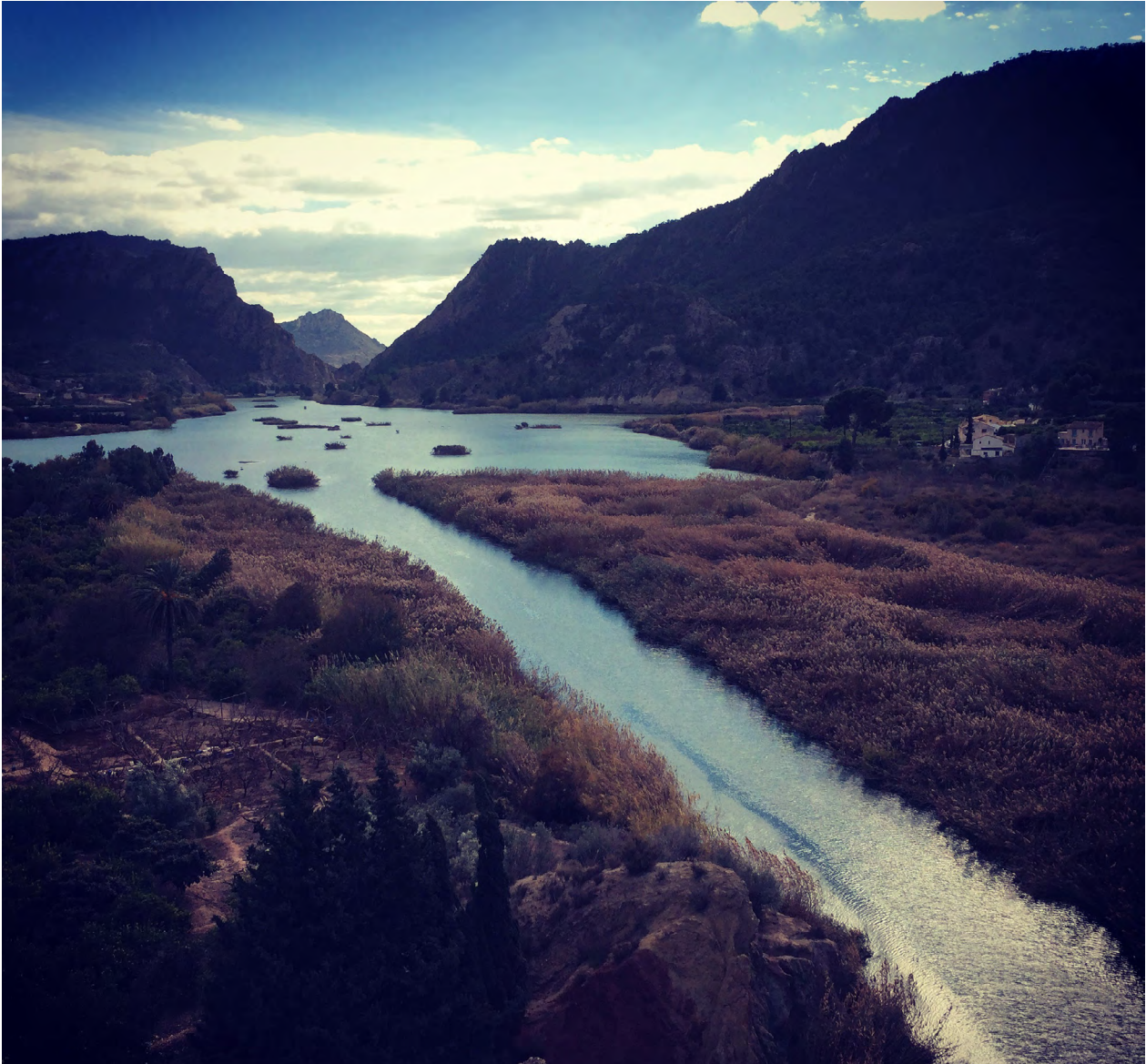
Embalse del Azud de Ojós desde el mirador del Alto Bayna, en Blanca. Este embalse modula la llegada de aguas del Trasvase Tajo-Segura que son derivadas, por impulsión, a ambos márgenes de la cuenca. Posteriormente, los canales del postrasvase conducen el recurso hacia lugares tan lejanos como Alicante y Almería.
