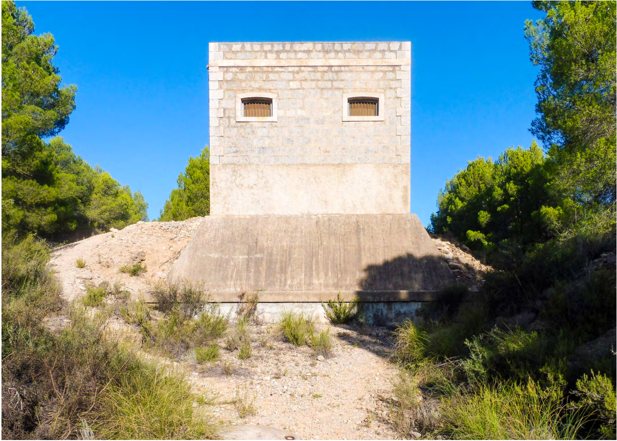
Cámara de carga del sifón de Burete.
