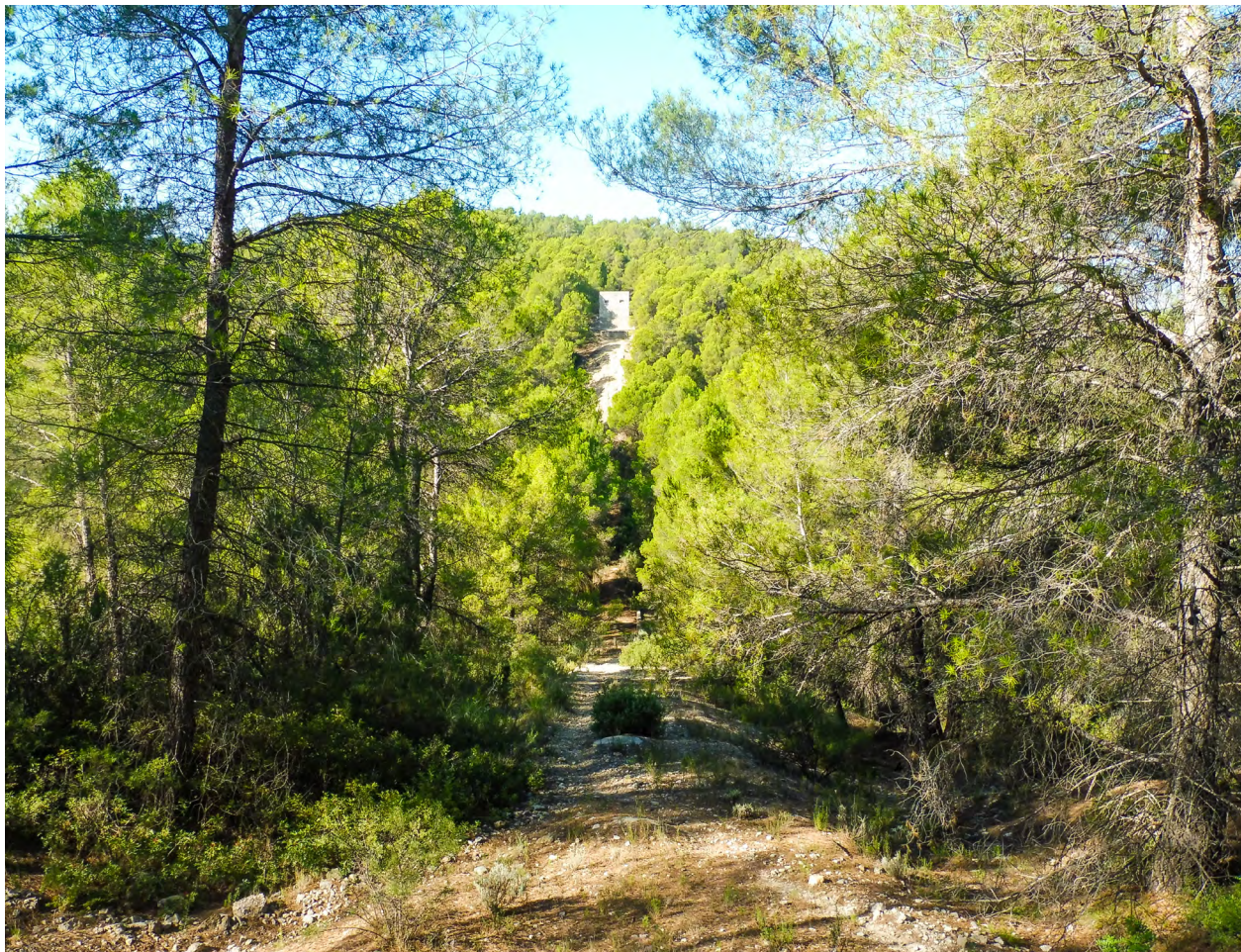
Sifón de Riego Nuevo. El tramo descendente enfrente. El tramo ascendente a nuestros pies.
