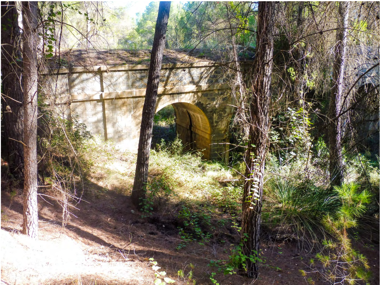
Portasifón en el sifón de Rompe Albardas, bajo la autovía RM-15 o Autovía del Noroeste.
