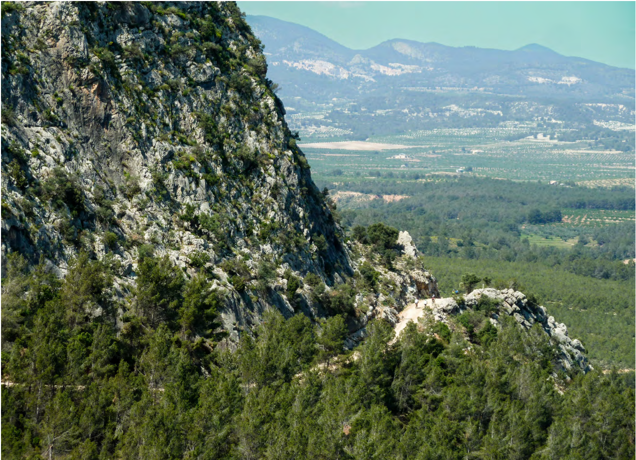
Paredes verticales cortadas a tajo por el camino de servicio del Canal de Espuña. Viendo a los ciclistas se tiene una idea clara de la dimensión de las mismas.
