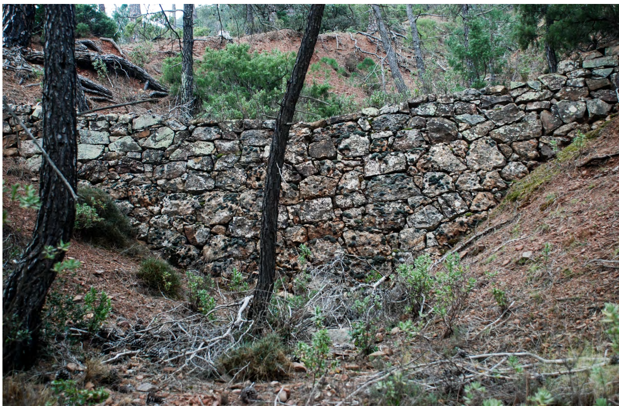
En los barrancos de Espuña es frecuente encontrar estos diques de corrección hidrológica-forestal para evitar que las lluvias torrenciales arrastren el suelo fértil de las laderas.
