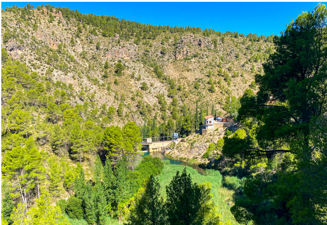
La Presa de Toma vista desde aguas arriba al borde del camino de servicio.
