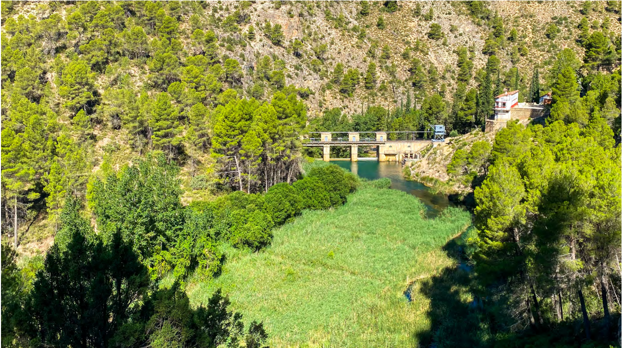
Presa de Toma, ubicada el término municipal de Nerpio y entre los poblados de Turrilla y Vizcable, unos kilómetros por debajo del actual Embalse del Taibilla en el paraje denominado Cenajo Frío. Su función es regular el caudal en origen del Canal Alto.
