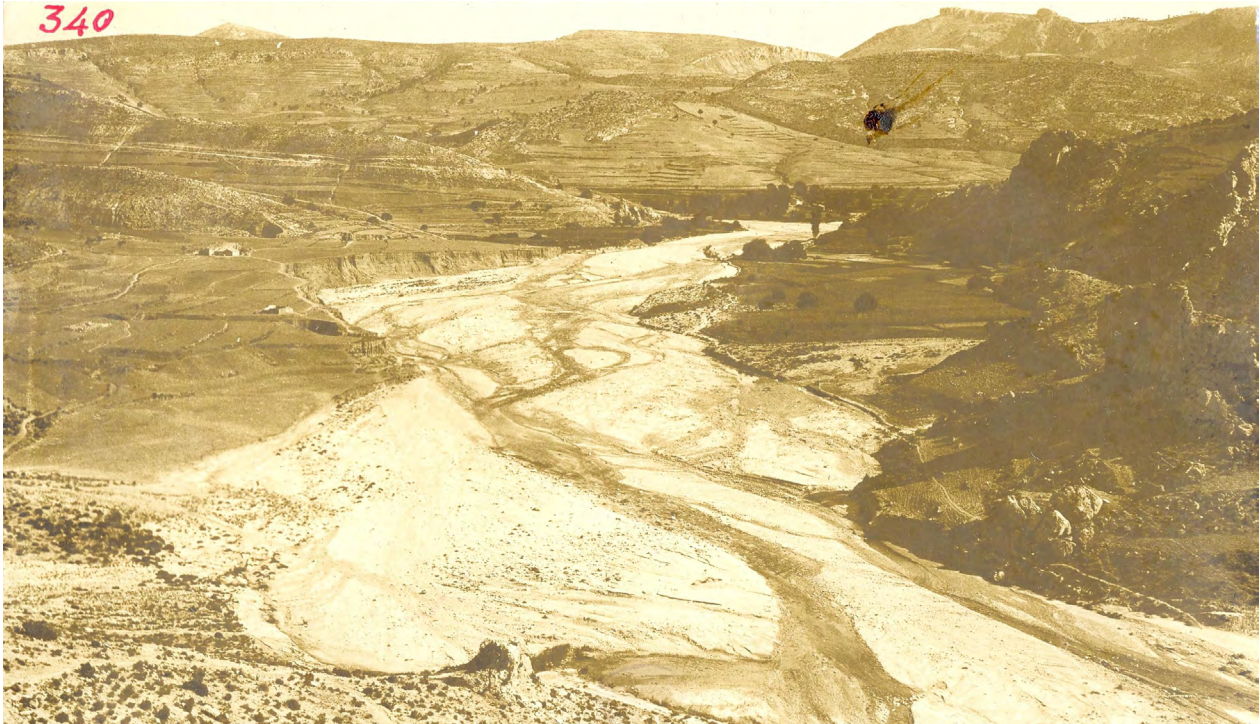
Vaso del embalse para la malograda Presa del Estrecho del Aire (año 1930). Fuente: archivo de la MCT.
