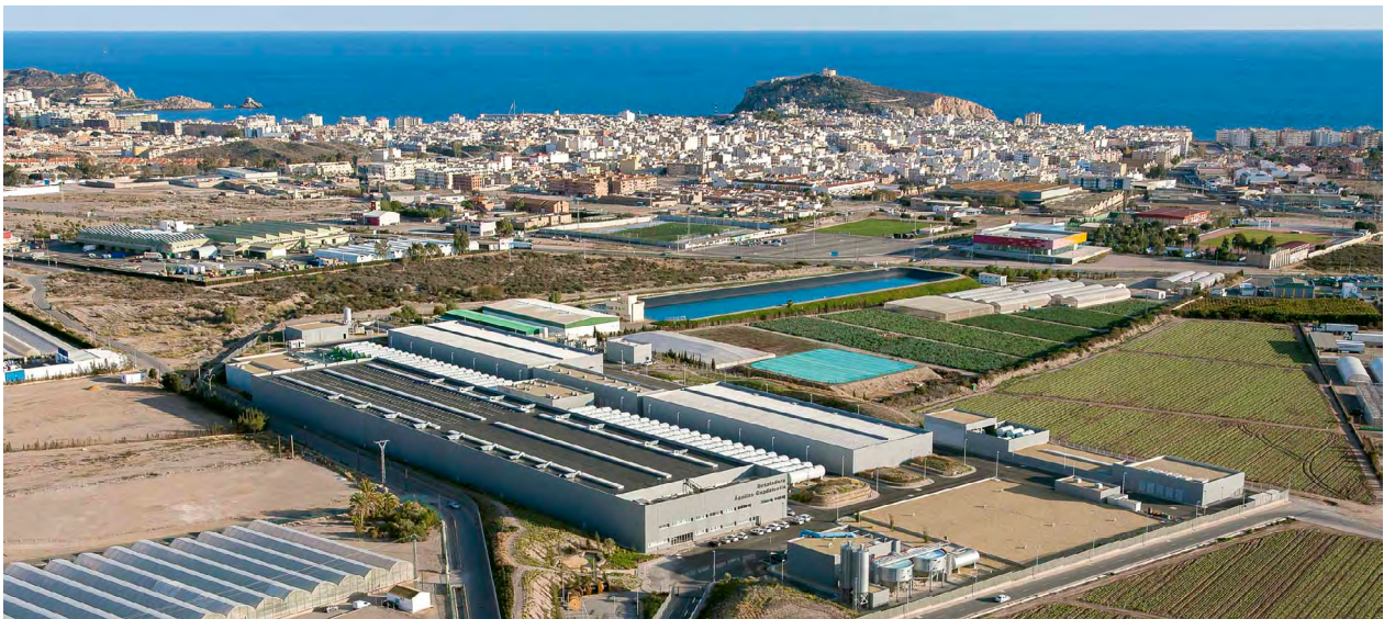
Instalación desalinizadora de Águilas propiedad de la sociedad ACUAMED y que da servicio a la Mancomunidad de los Canales del Taibilla así como a otros usuarios. Fuente: archivo de ACUAMED.
