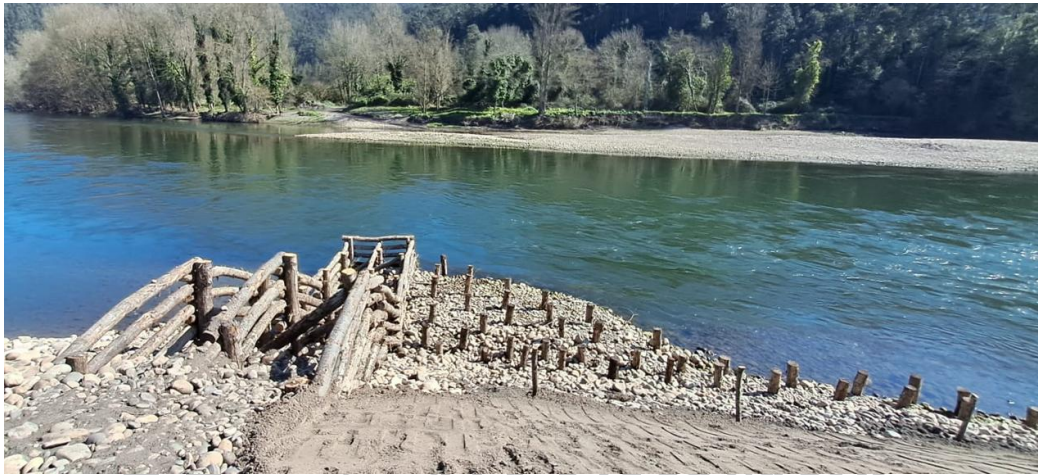
Figura 22. Imágenes durante las obras de bioingeniería en 2022.
