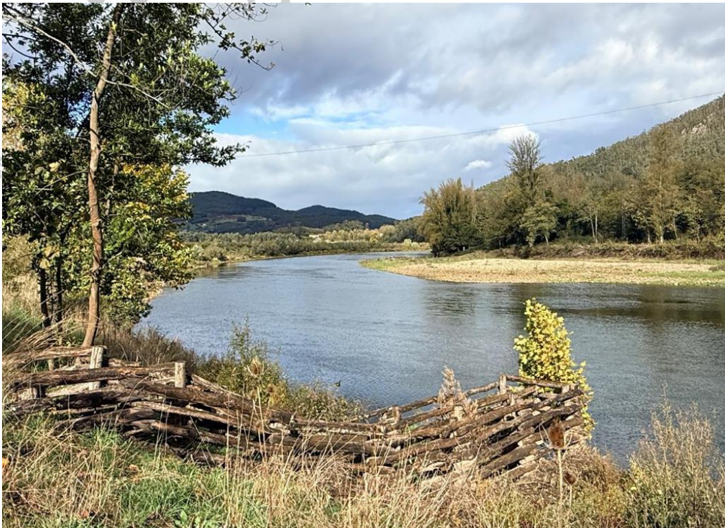
Figura 23. Arriba imagen durante las obras en 2021 (arriba) y abajo imagen actual, con aspecto de un deflector orgánico en primer término.
