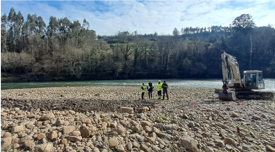
Figura 16. Trabajos de reubicación de sedimento sobre el meandro de Villamarín.
