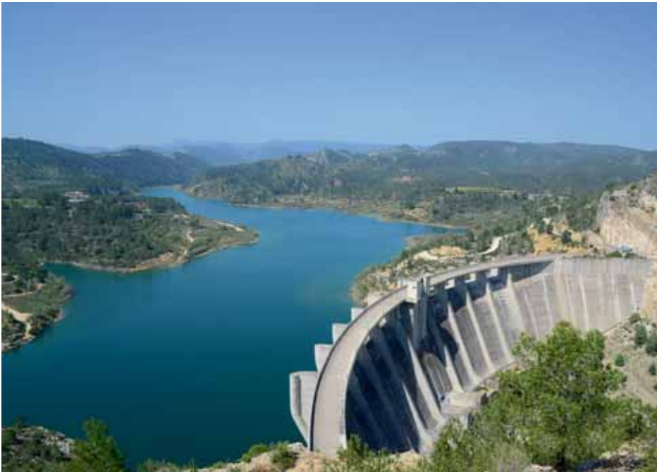
Presa de Escalona
