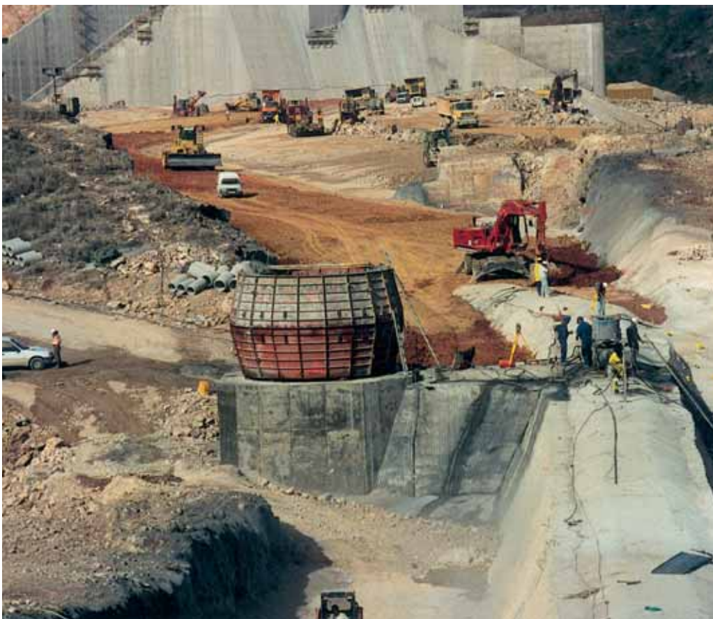
Prefabricación, transporte y colocación de módulos
