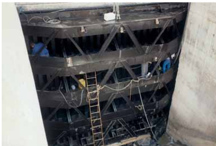
Cierre del túnel de desvío
