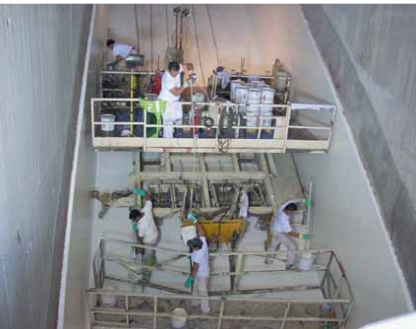
Obra Trabajos de pintado del blindaje
