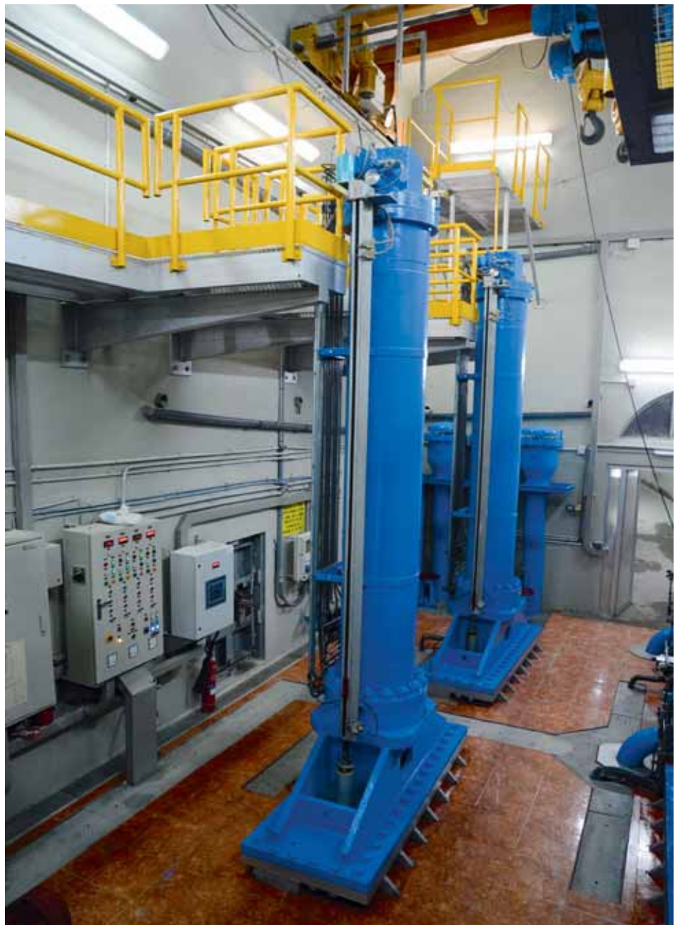
Equipos hidromecánicos y cuadros de control del desagüe de fondo
