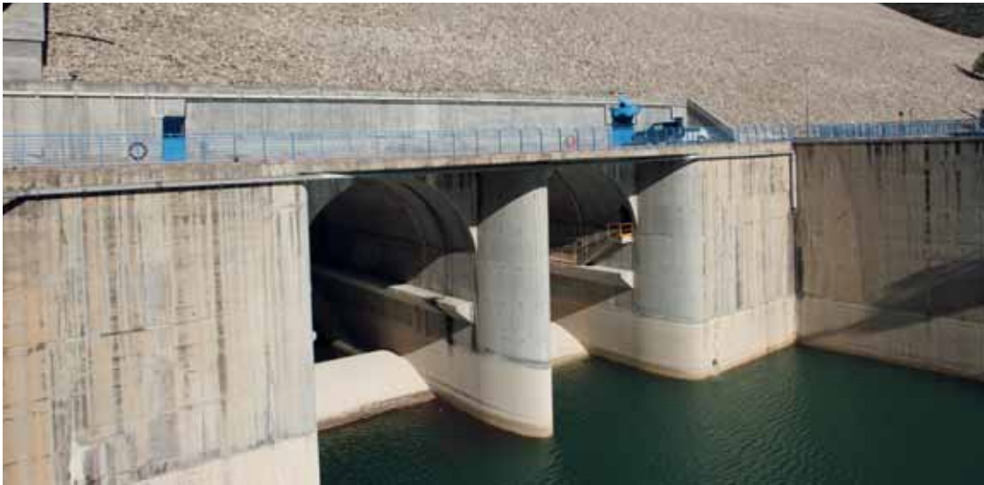
Azud a la salida del desagüe intermedio
