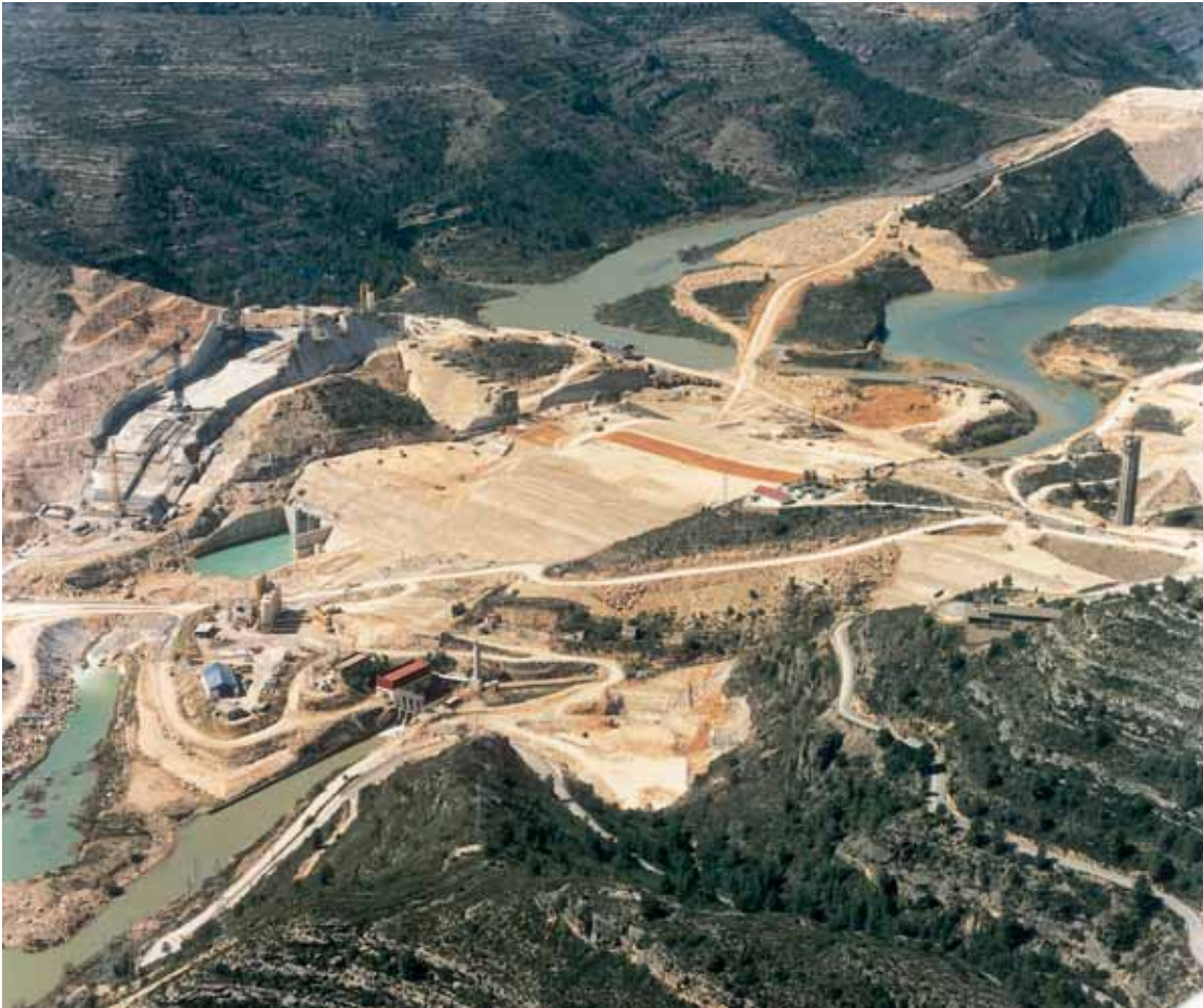
Vista general de las obras, 1993
