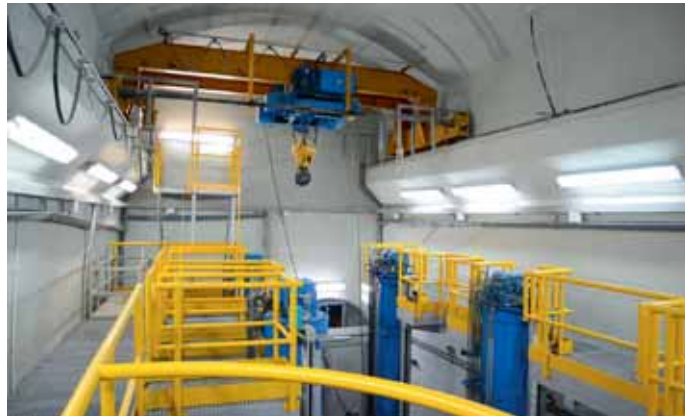
Equipos hidromecánicos y cuadros de control del desagüe de fondo
