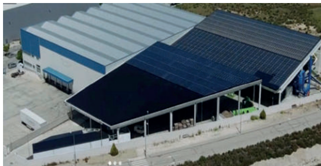
Vista del campo solar en Chiloeches
