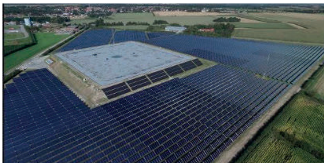
Campo solar térmico con almacenamiento PITES, Gram, Dinamarca
