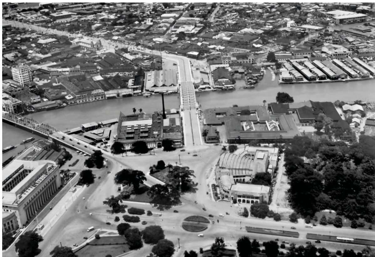
Fig. 74. Terrenos del antiguo Jardín botánico de Arroceros a finales en 1940, después de la construcción en su extremo occidental del gran edificio del Teatro Metropolitano (fuente: War Department. Army Air Forces. U.S. National Archives).
