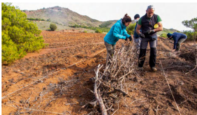
Figura 4. Izquierda: construcción de fajinas forestales. Derecha: plantación. Estas labores se realizaron con la ayuda de la Fundación Sierra Minera.
