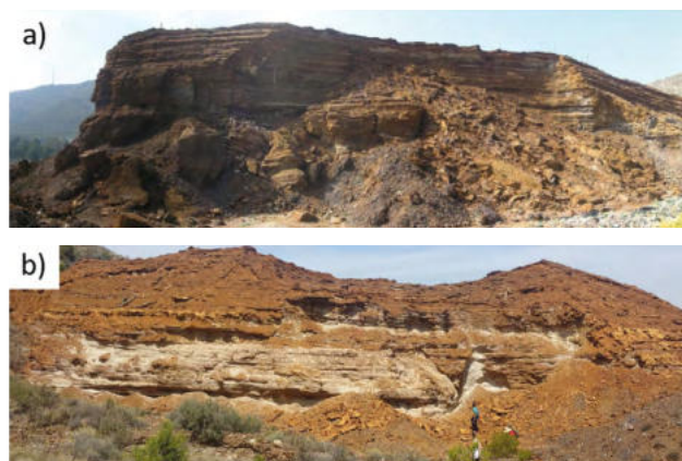
Figura 6. a) Riesgos geotécnico-estructurales en las presas de lodos mineros (relaves) con diferentes formas geométricas de desprendimiento en bloques y deslizamiento. a) presa El Descargador II y b) presa El Descargador I.
