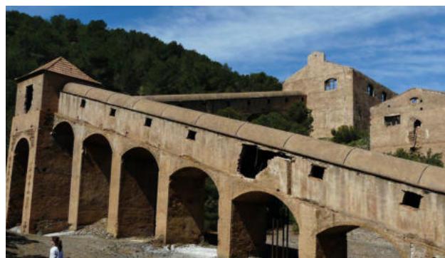
Figura 8. Lavadero El Lirio, conjunto minero de Ponce.
