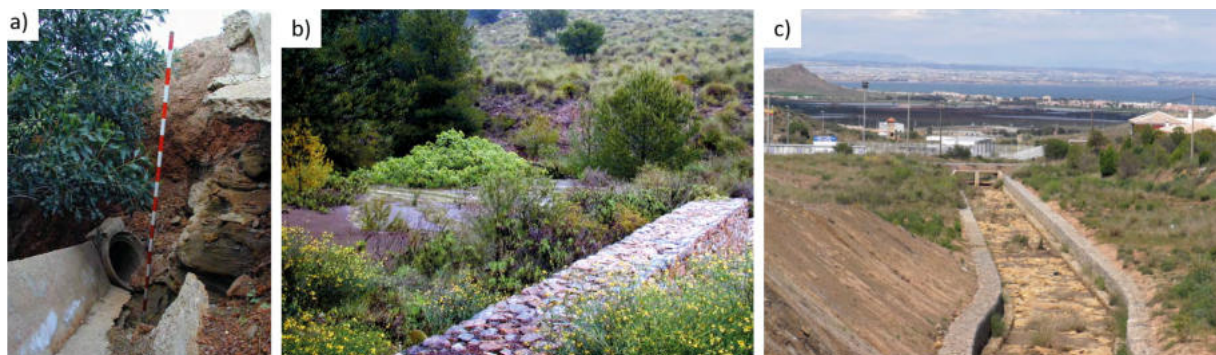
Figura 13. a) Ejemplo de un sistema de drenaje rígido con tubos de hormigón y canal de cemento en la presa de lodos Marqués de Pejar restaurada, es sistema está roto y desconectado más de dos metros, b) un sistema de drenaje flexible con gaviones en la rambla de Portman y c) sistema de drenaje flexible con gaviones en la rambla del Beal.
