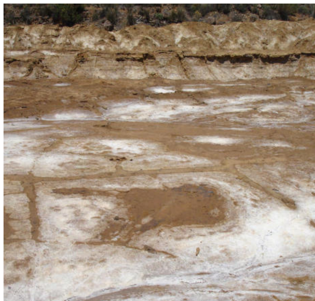
Figura 5. Presa minera conocida como Descargador II. Se observan abundantes sales blanquecinas de sulfatos altamente solubles formadas por evaporación y ascenso capilar en la época estival.
