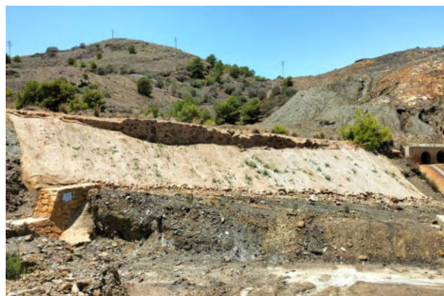
Figura 2. izda: ensayo realizado en zonas llanas en las que se evalúa el resultado de las siembras en sustratos con distintas enmiendas y con cubrición, o no, de manta vegetal; dcha: estado de talud tras enmienda con tierra vegetal, siembra y cubrición de talud mediante manta vegetal. En ambos se puede comprobar la existencia de germinación siendo mayor en las zonas cubiertas con manta vegetal.
