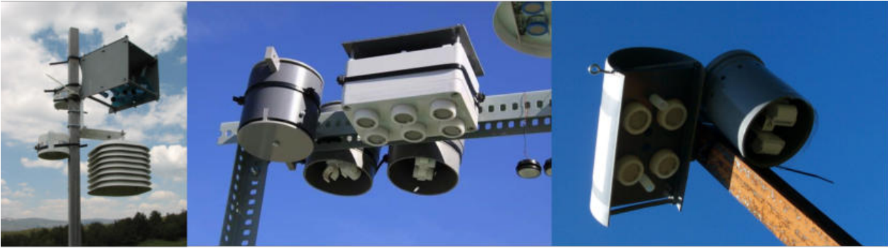
Figura 16. Dosímetros pasivos para medida de contaminantes gaseosos. Distintos modelos de dosímetros para el análisis de los niveles de ozono y óxidos de nitrógeno. Fuente: CIEMAT, CEAM, MITECO.
