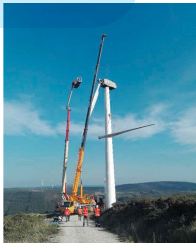
Figura 13. Desmontaje del rotor completo (izq.) y desmontaje por palas (der.). Fuente: Surus Inversa, S.L. 94 .
