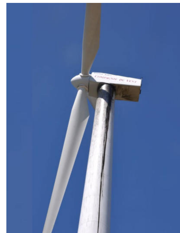
Figura 37. Fuga de aceite en aerogenerador. Fuente: Laurent Goiffard ( https://commons.wikimedia.org/wiki/File:Eolienne_Compagnie_du_Vent.JPG )
