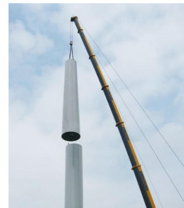
Figura 8. Construcción de la torre de un aerogenerador a partir de secciones tubulares de acero.
