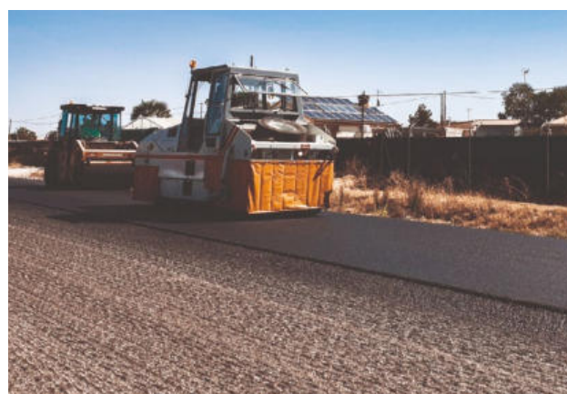
Figura 29. Aplicando la mezcla en el pavimento. Fuente: LIFE Refibre (2021) 105 .
