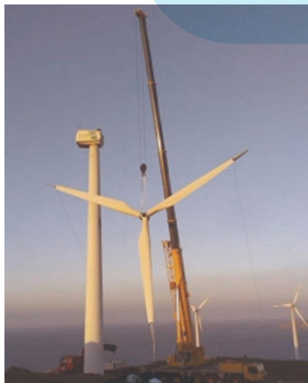
Figura 13. Desmontaje del rotor completo (izq.) y desmontaje por palas (der.). Fuente: Surus Inversa, S.L. 94 .
