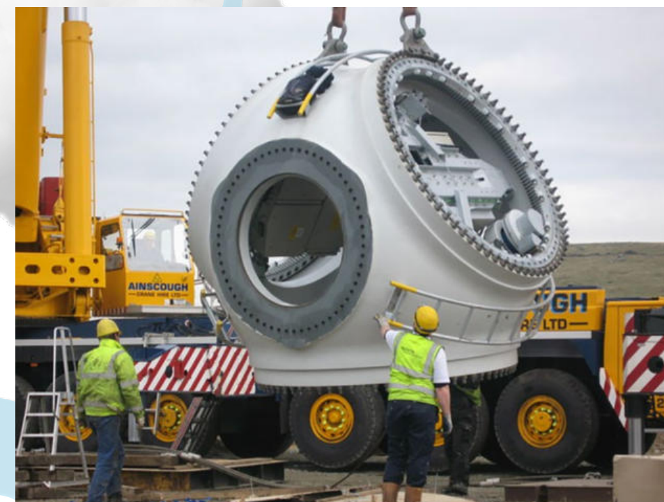
Figura 5. Bujes desarmados de un aerogenerador.
