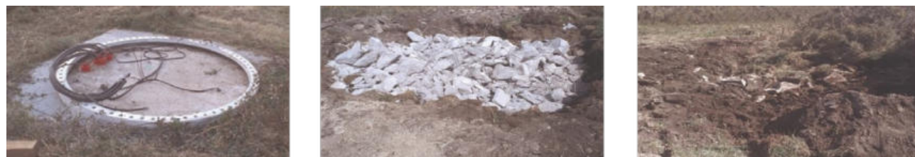
Figura 15. Secuencia de restauración del hueco de los cimientos de un aerogenerador.
