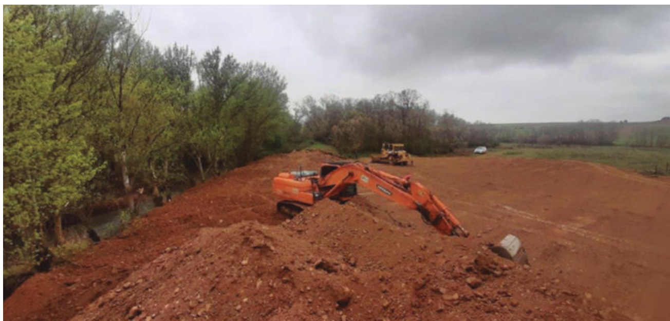
Figura A.4.3.4. Trabajos de eliminación de una mota en la margen derecha del río Sequillo en Belver de los Montes (Zamora). Todo el material fue vertido al río definido por la hilera de chopos. Fuente: CHD.
