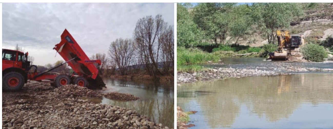
Figura A.2.8.2 (a) Volcado de gravas en el cauce y (b) proceso de eliminación del badén. Fuente: ACA.
