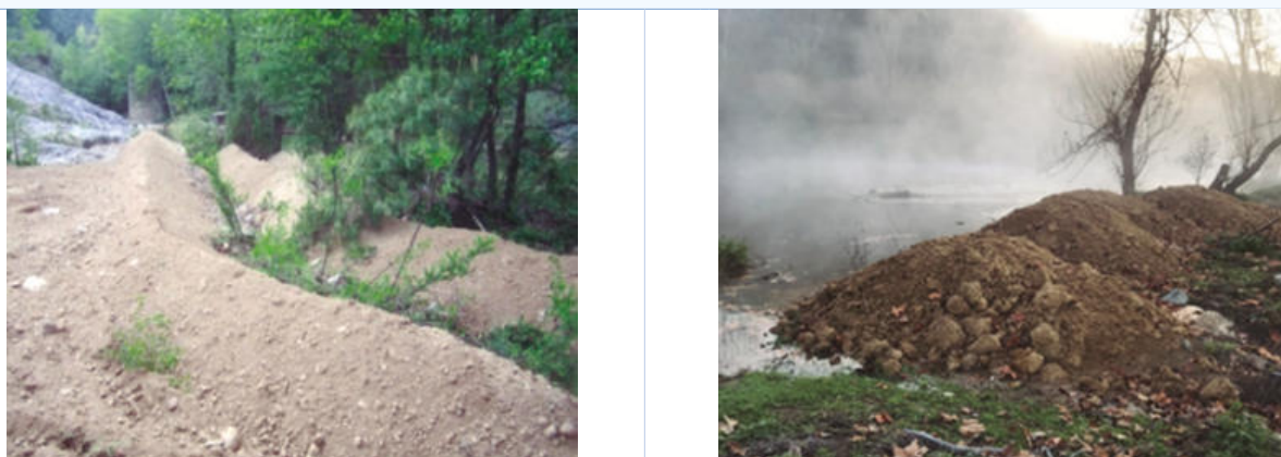
Figura A.2.10.2 (a) Acopio de los sedimentos a inyectar en el río Llobregat y (b) disposición de los cordones de sedimento paralelos a la orilla del río Ter. Fuente: ACA.
