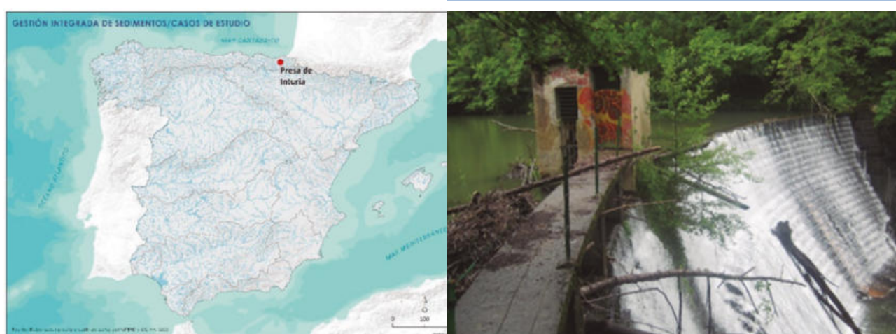
Figura A.2.5.1 (a) Mapa de localización de la presa de Inturia y (b) aspecto de la presa de Inturia antes de su demolición. Fuente: URA.
