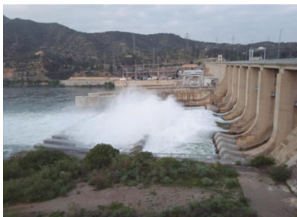
Figura A.4.1.2 (a) Presa de Ribarroja. Apertura de compuertas para el alivio de la crecida controlada (5 de mayo de 2022); (b) Toma de muestras en la Sección 2, puente de Mora de Ebro (5 de mayo de 2022). Fuente: CHE.
