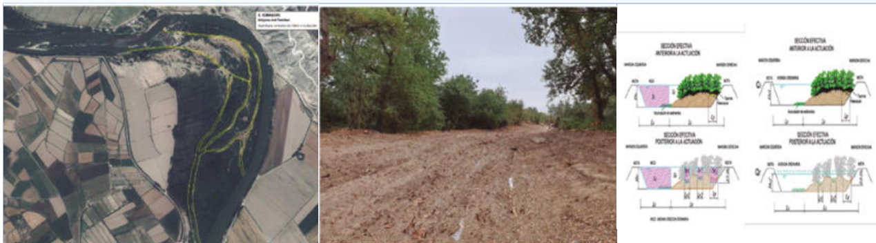
Figura A.2.3.3 Ramales de libre circulación. (a) Ubicación en la Mejana del Tambor; (b) desbroce y labrado del lecho y (c) cálculo de la sección efectiva de los ramales y cota de la lámina de agua en avenida. Fuente: CHE
