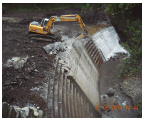
Figura A.2.5.2 (a) Esquema de las fases de demolición de la presa de Inturia. (b) Proceso de demolición de la presa de Inturia durante la segunda fase, en agosto de 2014. Fuente: URA.
