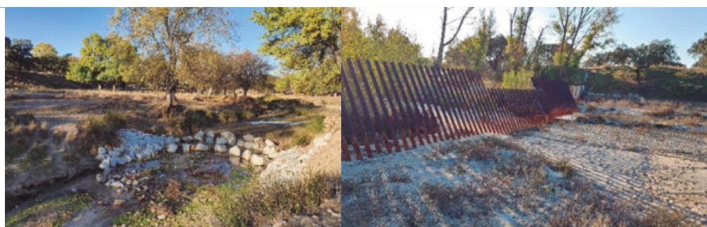
Figura A.4.8.3 Actuaciones de protección de la erosión (a) esquema de la hidrotecnia tipo cross vane en planta, (b) localización de la hidrotecnia en una sección del cauce y (c) peine retenedor de sedimentos en el tramo final del arroyo de la Trofa.
