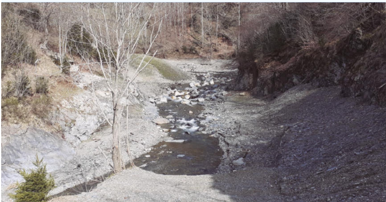
Figura. A.2.4.3. Vista del tramo donde se localizaba la presa del azud de la CH Molló en marzo 2021. Fuente: ACA.
