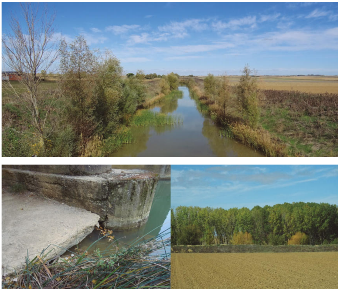
Figura A.4.3.2 Río Valderaduey. (a) Aspecto de un tramo rectificado; (b) Fenómenos de erosión local en los cimientos de un puente y (c) Mota de defensa frente a inundaciones para la defensa de los cultivos agrícolas ubicados en la llanura aluvial.
