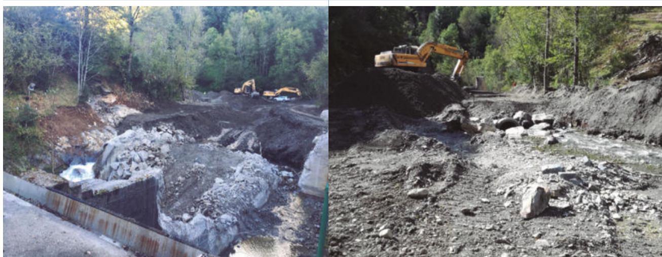
Figura A.2.4.2 (a) Trabajos de demolición de la presa y del antiguo desarenador y retirada parcial del sedimento retenido en el vaso del azud; (b) Trabajos de retirada de sedimento anóxico en la zona de presa mediante excavadora. Fuente: ACA.
