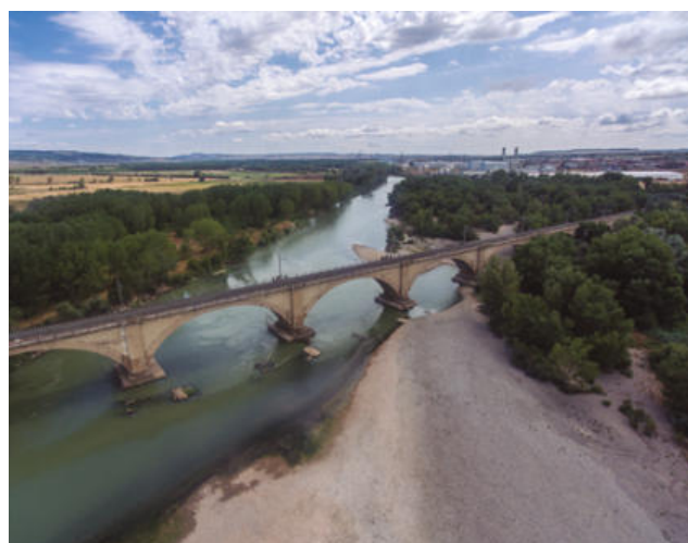
Puente del ferrocarril sobre el río Ebro a su paso por Alfaro. Eduardo Berrián Luna
