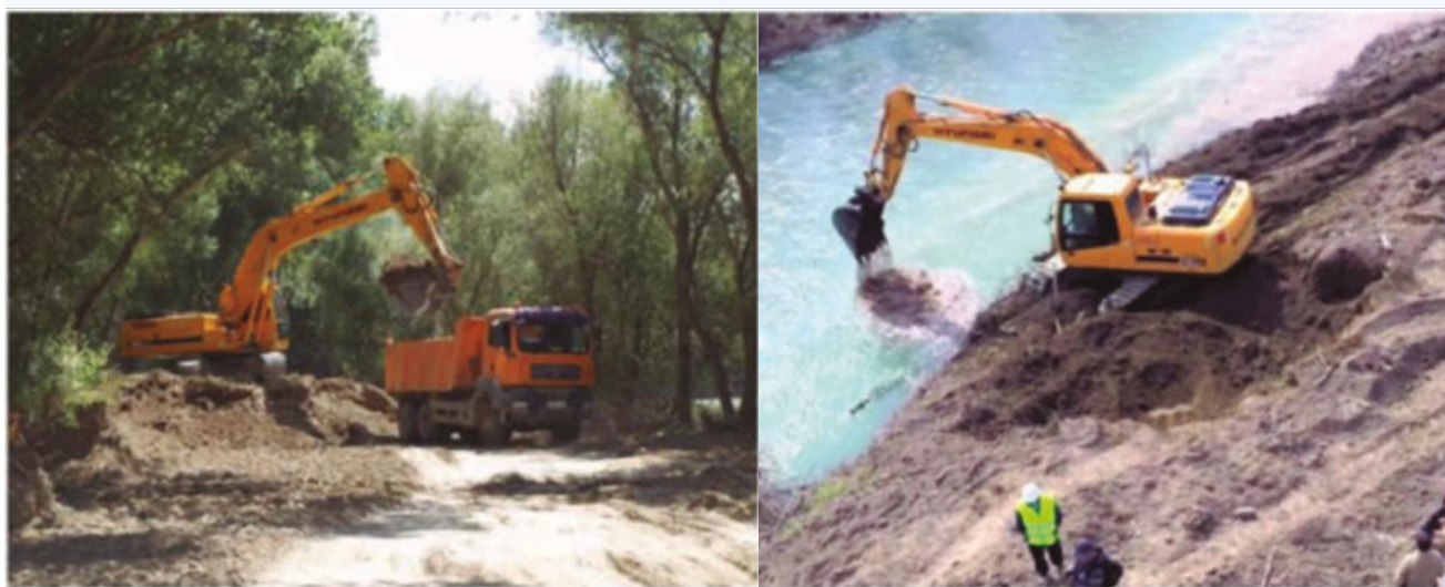
Figura A.2.2.2 (a) Eliminación de obras de defensa frente a inundaciones para reconectar el lecho del río y las llanuras de inundación en los espacios de la Red Natura2000; (b) Eliminación de diques y reintroducción de sedimentos; en algunos casos, realizada por los mismos operadores que hace décadas habían dragado el río y construido las obras de defensa. Fuente: Gobierno de Navarra y MN Consultores.
