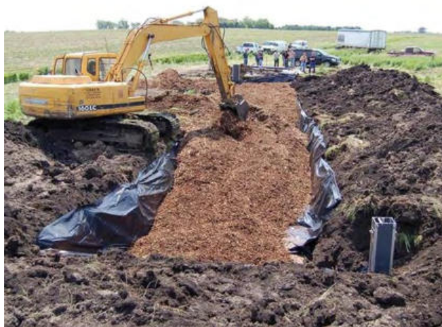
Figura 2. a) Construcción de biorreactores rellenos de astillas de madera en EE.UU. https://acsess.onlinelibrary.wiley.com/doi/full/10.1002/agg2.20149 ; b) Relleno de un biorreactor con virutas de madera para tratar efluentes de acuicultura en EE.UU (fotografía de L. Christianson/Iowa Soybean Association Environmental Programs and Services; https://www.globalseafood.org/advocate/woodchip-bioreactors-effectively-treat-aquaculture-effluent/ ).
