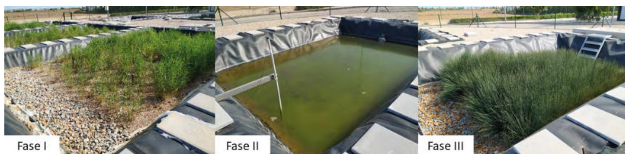
Figura 5. Planta piloto de humedales artificiales de Los Alcázares en el Campo de Cartagena. En las imágenes se muestran las tres fases de tratamiento con diferentes tipos de flujo (Fase I: flujo subsuperficial; Fase II: flujo superficial; Fase III: flujo subsuperficial) y vegetación ( Phragmites australis en Fase I y Juncus maritimus en Fase III).
