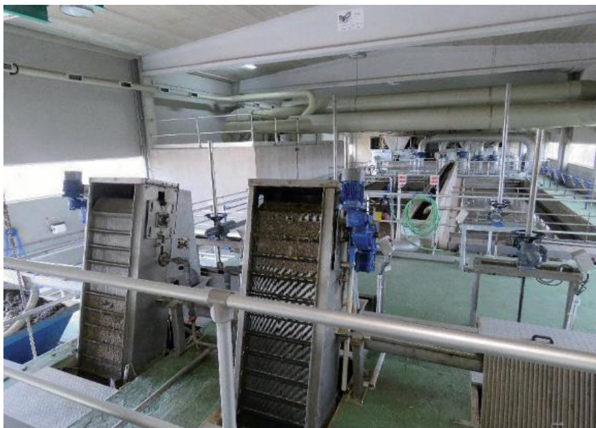
Figura 5.3. Desenarenado en EDAR San Pedro del Pinatar. Foto: M. B. Bernabé-Crespo.
