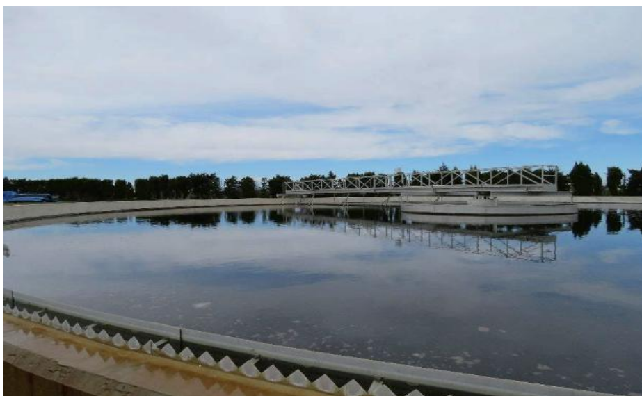
Figura 5.4. Decantación secundaria en EDAR San Javier. Foto: M. B. Bernabé-Crespo.
