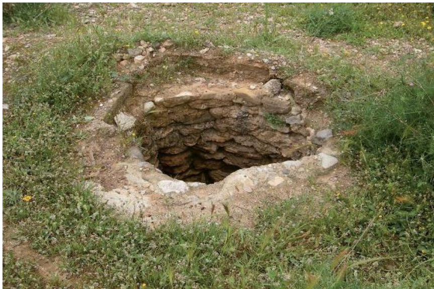
Figura 1.13. Lumbrera en la galería de la margen derecha de la rambla de La Azohía, afluente de la de Fuente Álamo-Albujón. Foto: J. M a Gómez Espín.
