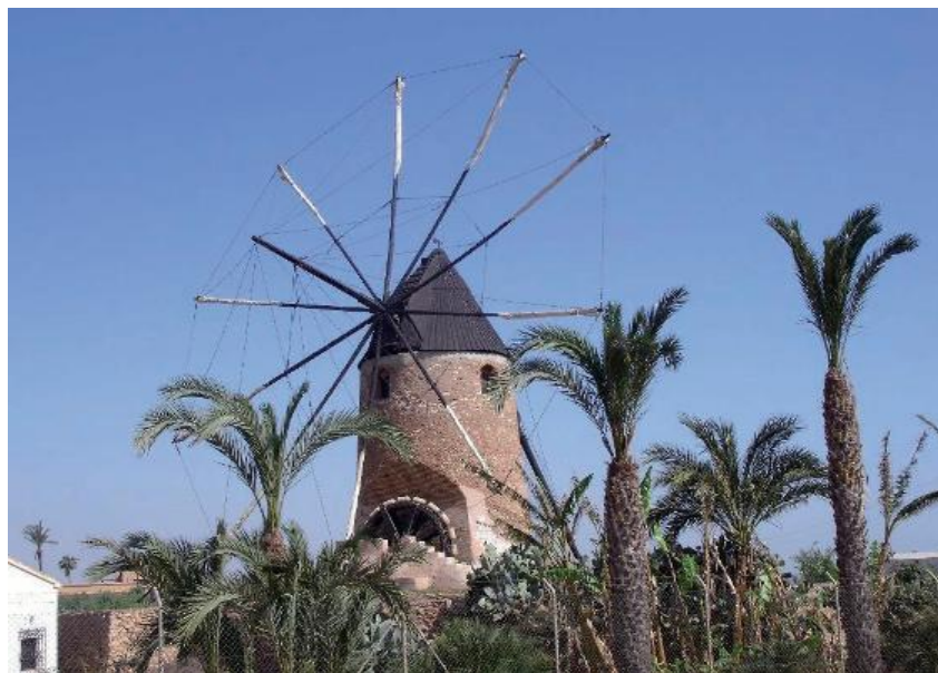
Figura 1.12. Molino de viento del Campo de Cartagena con rueda hidráulica. Foto: E. Gil-Meseguer.
