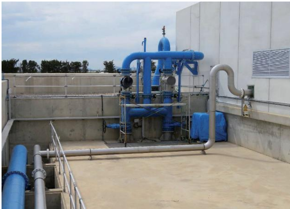
Figura 5.18. Desinfección por ultravioleta en EDAR San Javier. Foto: M. B. Bernabé-Crespo.
