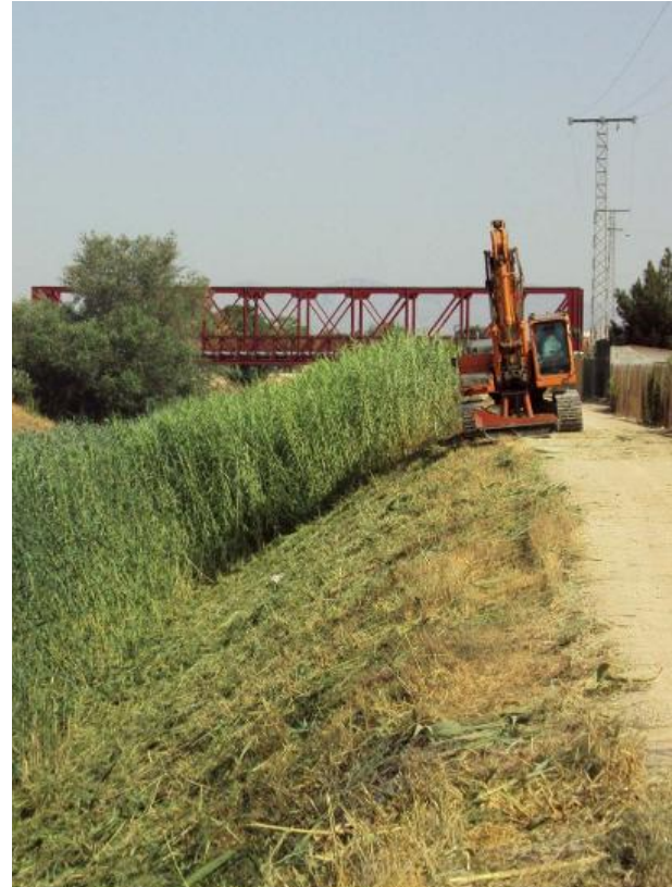
Desbroce de mantenimiento para mantener la capacidad de desagüe del cauce
