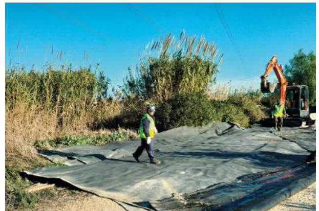
Proceso de retirada de lámina de PEAD
