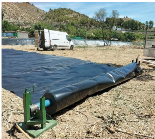
Soporte para desenrollado de PEAD
