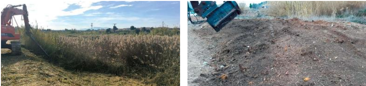
Desbroce mecanizado en formaciones monoespecíficas de caña
