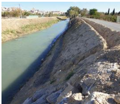
Zanjas longitudinales (superior e inferior) paralelas al cauce
