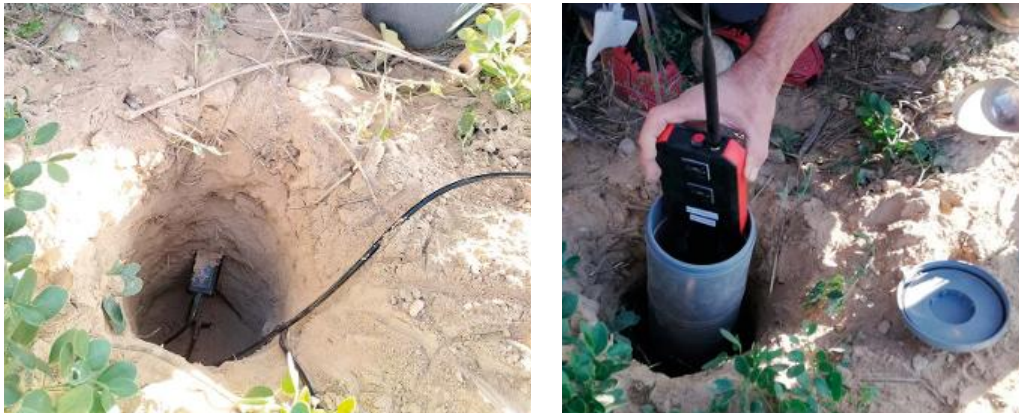
Instalación equipo de monitorización
