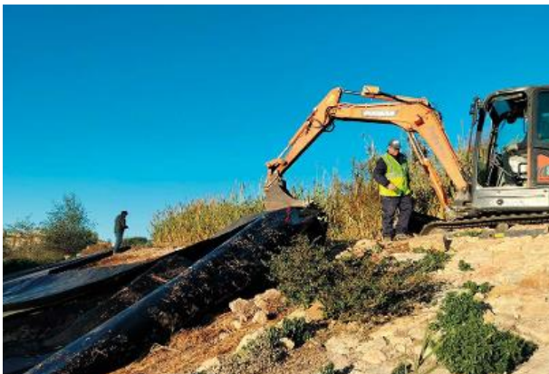
Proceso de retirada de lámina de PEAD
