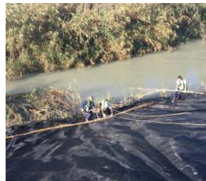
Fijación de la lámina en la parte inferior sin zanja
