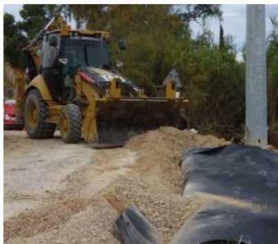
Fijación de la lámina en la parte superior
