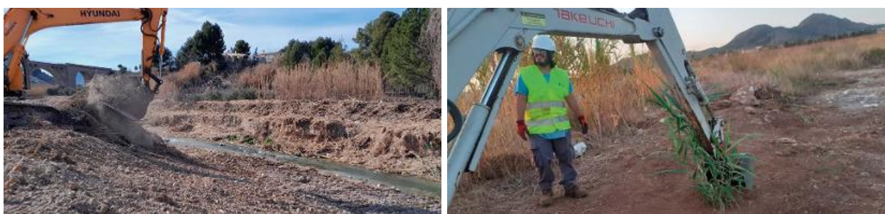
Extracción mecanizada de rizoma
