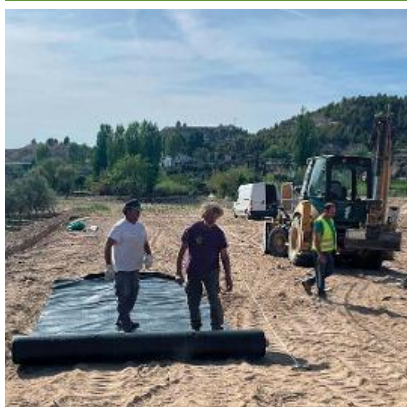
Desenrollado de geotextil
