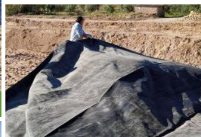
Extensión manual de geotextil
