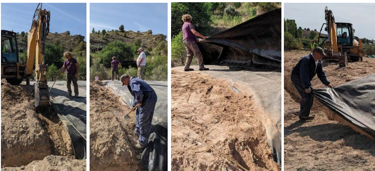
Instalación del primer paño (geotextil)
