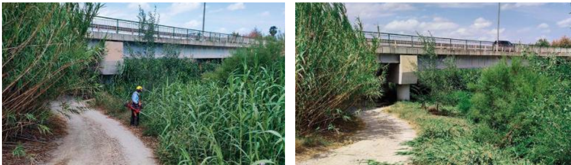
Desbroce manual respetando la vegetación autóctona
