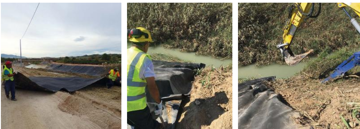
Instalación del primer paño (PEAD)
