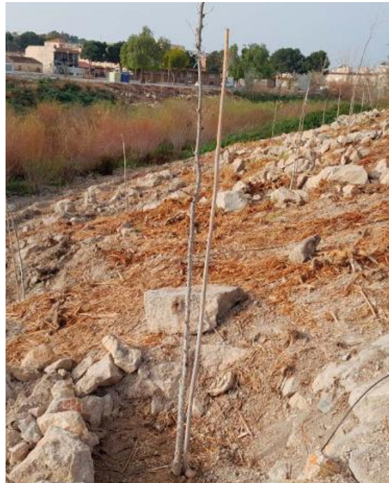
Apertura de hoyo en escollera
