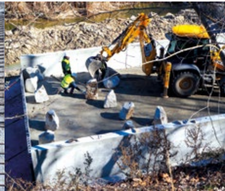
FIGURA 44 Colocación de los bolos en la rampa
