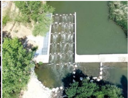
FIGURA 36 Vista aérea de la rampa y azud en la situación actual
