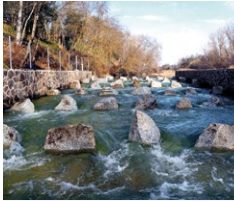
FIGURA 39. Vista de la rampa con los muros laterales encachados
