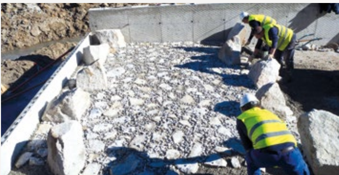
FIGURA 47 Encachado del lecho de la rampa
