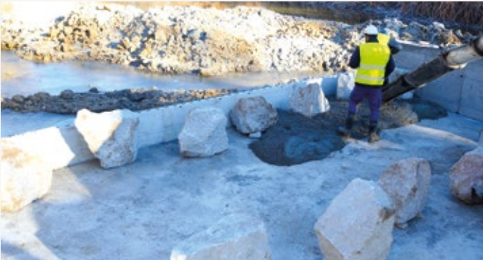
FIGURA 46 Hormigonado del lecho de la rampa
