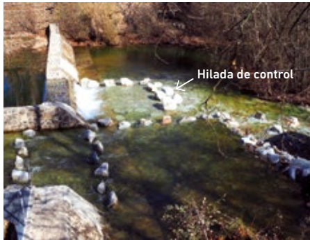
FIGURA 35. Hilada de control
