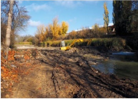
FIGURA 41. Construcción del acceso a la rampa en la margen derecha
