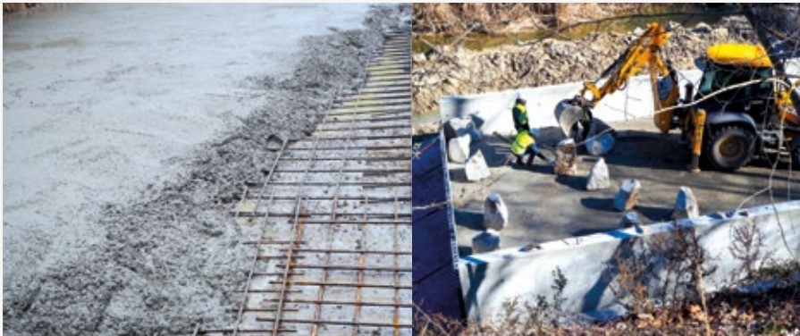
FIGURA 43 Detalle de la construcción de la base de la rampa
