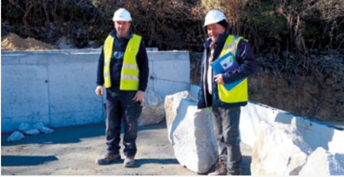
FIGURA 45 Comprobación de la disposición relativa de bolos en la hilada
