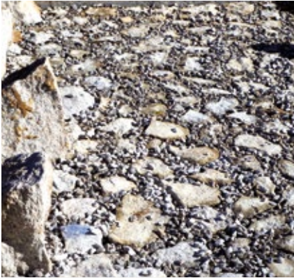
FIGURA 38. Lecho naturalizado de la rampa.
