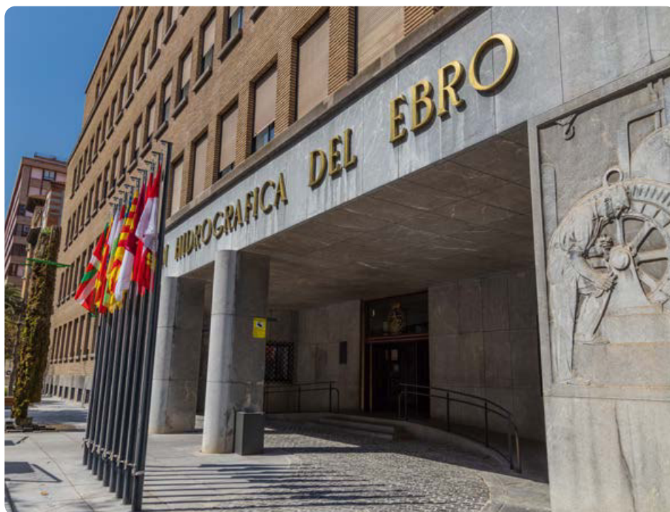
Vista de la puerta principal de la Sede central de la Confederación Hidrográfica del Ebro en Zaragoza
