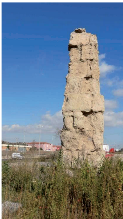
Figura 2.17. Espiaderos de la conducción de aguas que abastecía a la fuente del paseo de las Delicias (Fuente: F.J. Pérez de la Cruz)
