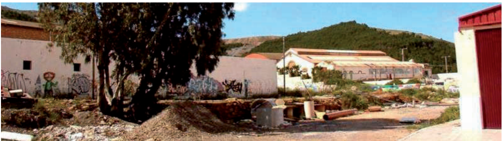
Figura 3.20. Ubicación del depósito subterráneo de agua para La Unión (Fuente: R. Mouzo Pagán)
