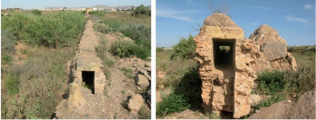
Figura 4.18. Restos de las conducciones de las aguas de la Compañía Francesa que se conservan en el entorno de la rambla de Benipila (Fuente: F.J. Pérez de la Cruz)
