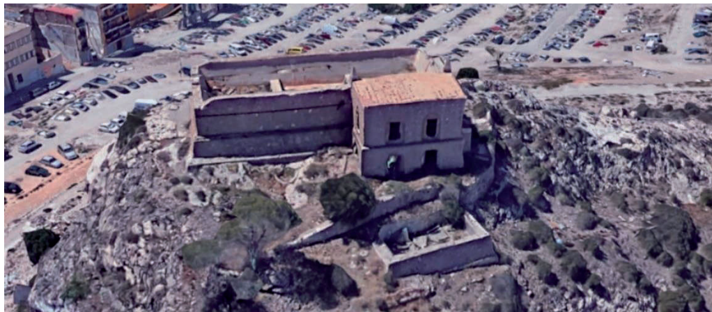
Figura 4.21. Vista aérea del Monte Sacro donde se aprecia en primer término el depósito de planta rectangular construido para almacenar las aguas de la Compañía Francesa (Fuente: Google Earth Pro)
