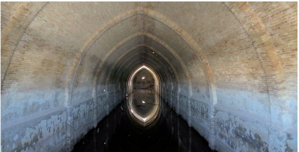
Figura 2.16. Interior del depósito donde se reunían las aguas de los manantiales de San Juan y las del Calvario (Fuente: F.J. Pérez de la Cruz)
