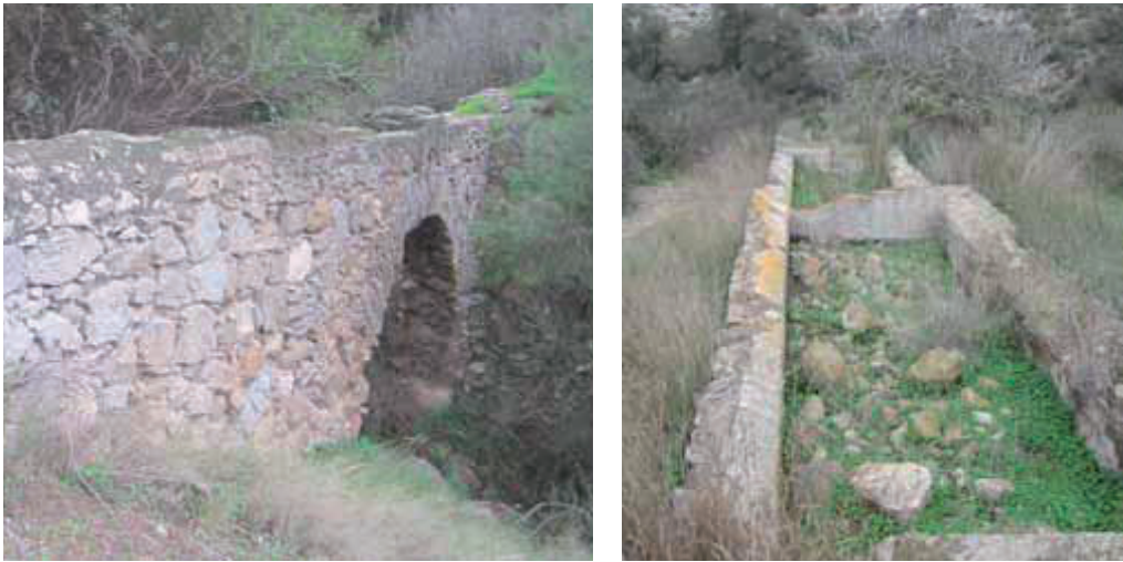
Figura 2.18. Acueducto y balsas en el barranco del Feo (Fuente: Pazo, 2013)
