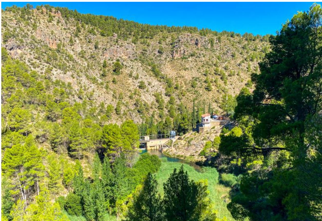
La Presa de Toma vista desde aguas arriba al borde del camino de servicio.
