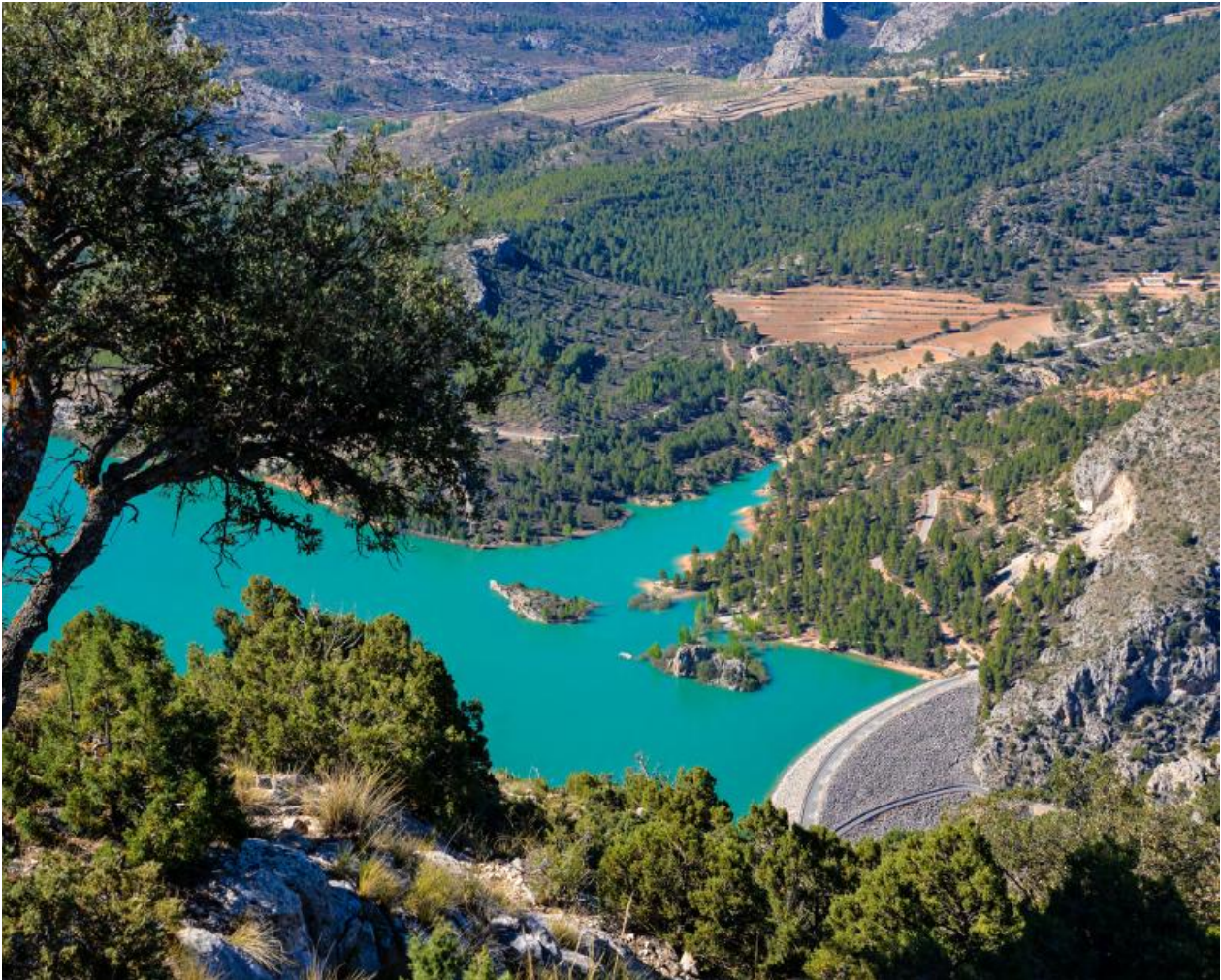
Detalle de la Presa del Embalse desde unos metros más abajo del Puntal del Aire.
