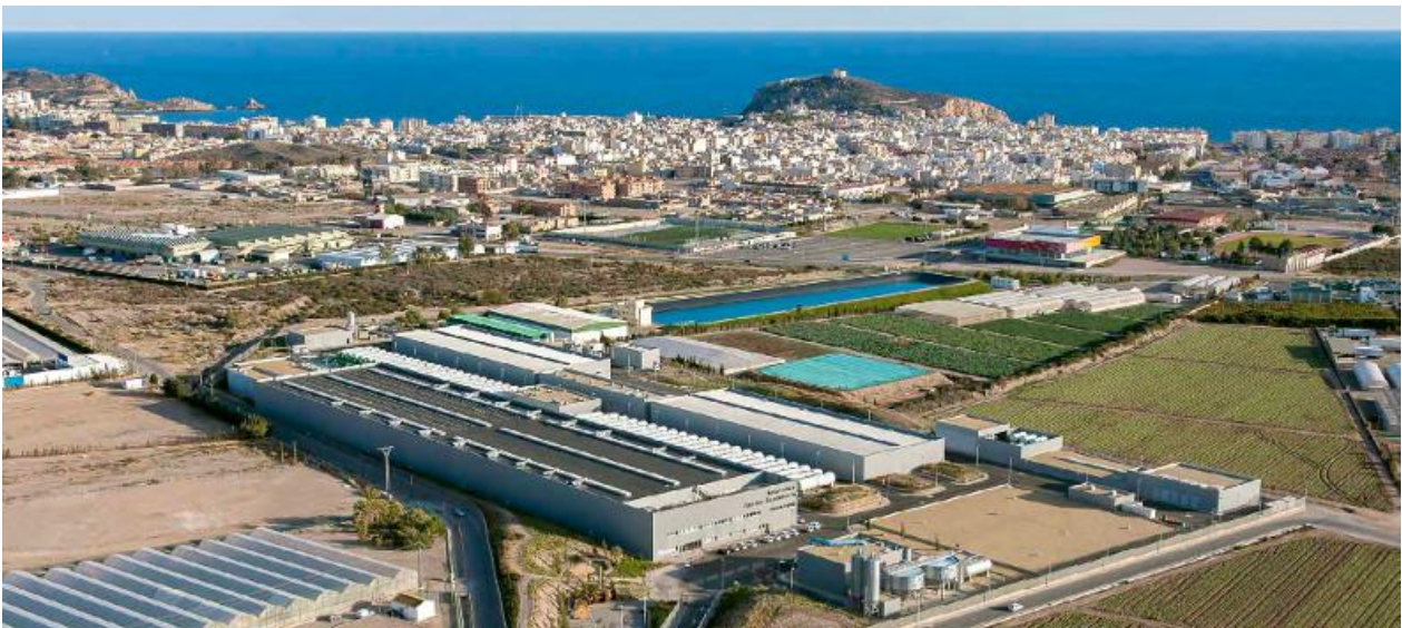
Instalación desalinizadora de Águilas propiedad de la sociedad ACUAMED y que da servicio a la Mancomunidad de los Canales del Taibilla así como a otros usuarios. Fuente: archivo de ACUAMED.
