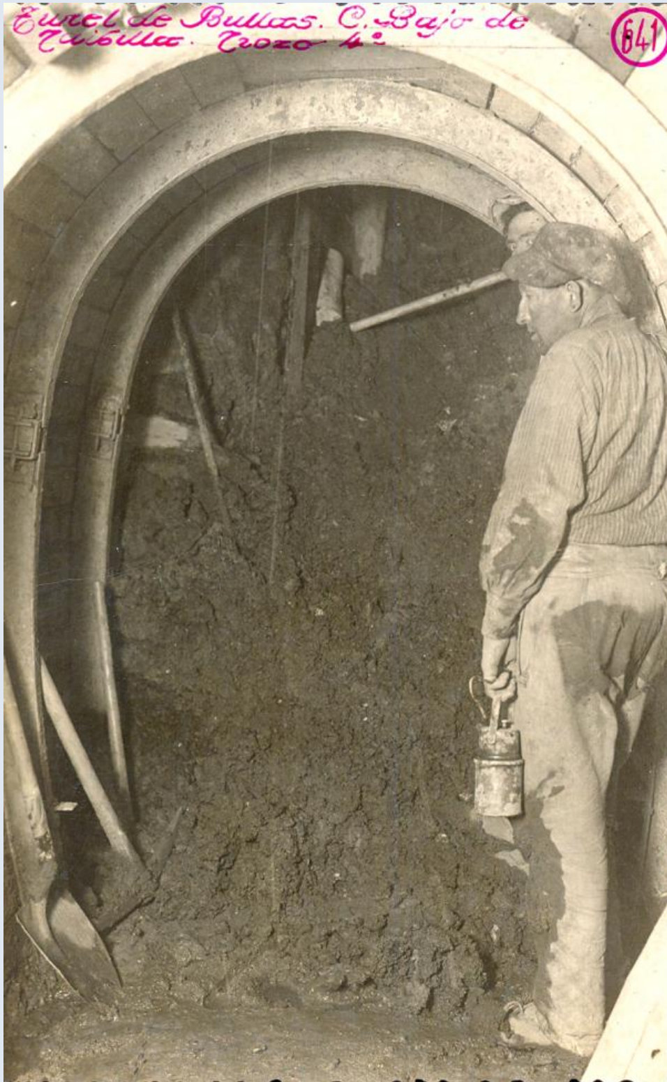
Construcción del túnel que atraviesa el casco urbano de Bullas en el Canal de España, justo después del partidor.
