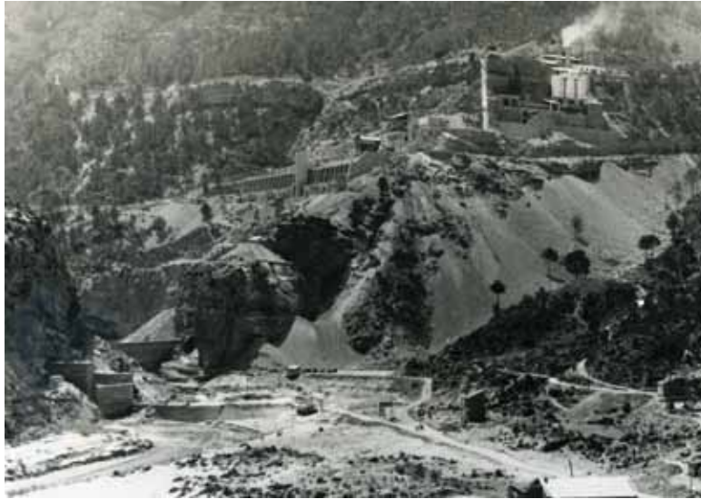
Vista general de las obras
