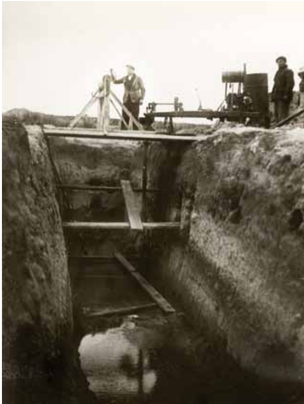
Obras de mejora en los riegos de Alpera-Almansa. 1933
