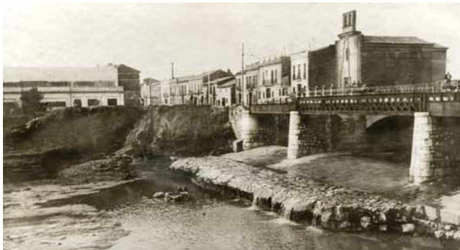
Desperfectos en el zampeado general. 1949-50
