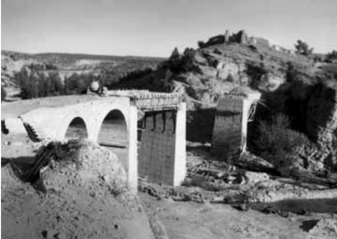
Puente en termino de Caudé (Teruel). 16-9-1966 Construcción sobre el embalse del Arquillo de San Blas en la partida de Abuán
