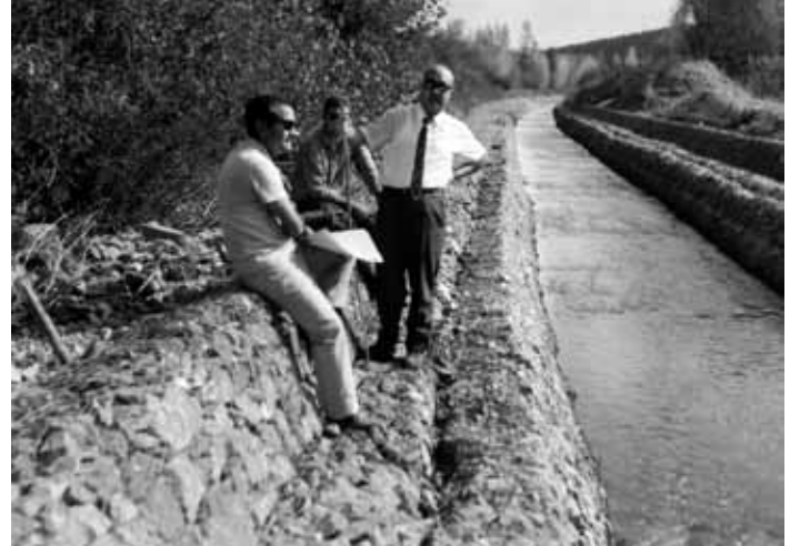
Río Guadalaviar. 1966 Obras de defensa en la vega de Torres de Albarracín
