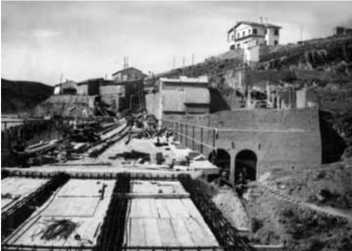
Presa de Arquillo de San Blas. 1962 Estado de las obras
