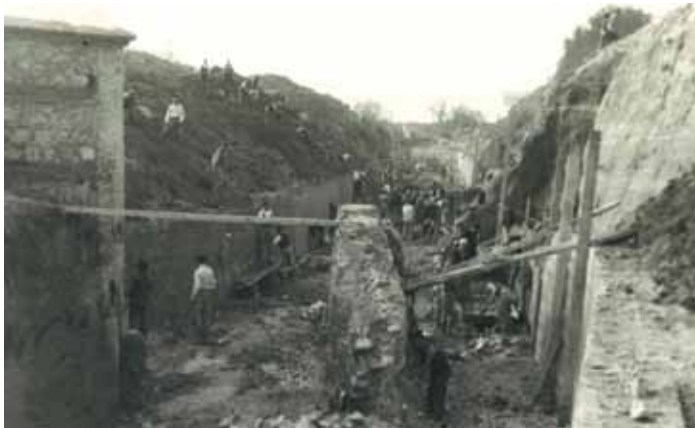
Acequia Real del Júcar, en La Punta del Diamant, Guadassuar, (Valencia). 1949 Trabajos de reforzamiento y revestimiento. (Cedida por ARJ)
