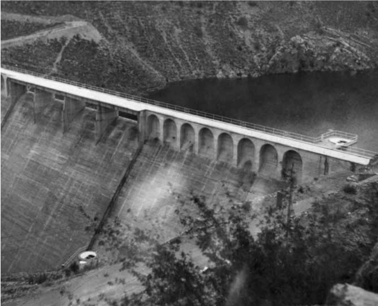
Presas del Arquillo de San Blas. 1964
