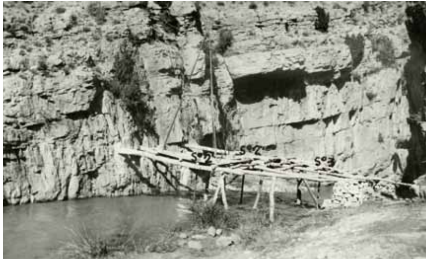
Trabajos de impermeabilización del cauce
