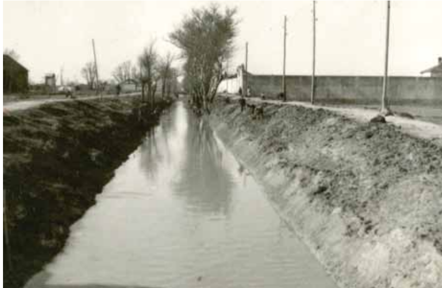
Acequión de Albacete. 1949 Obras de ampliación y mejora del drenaje
