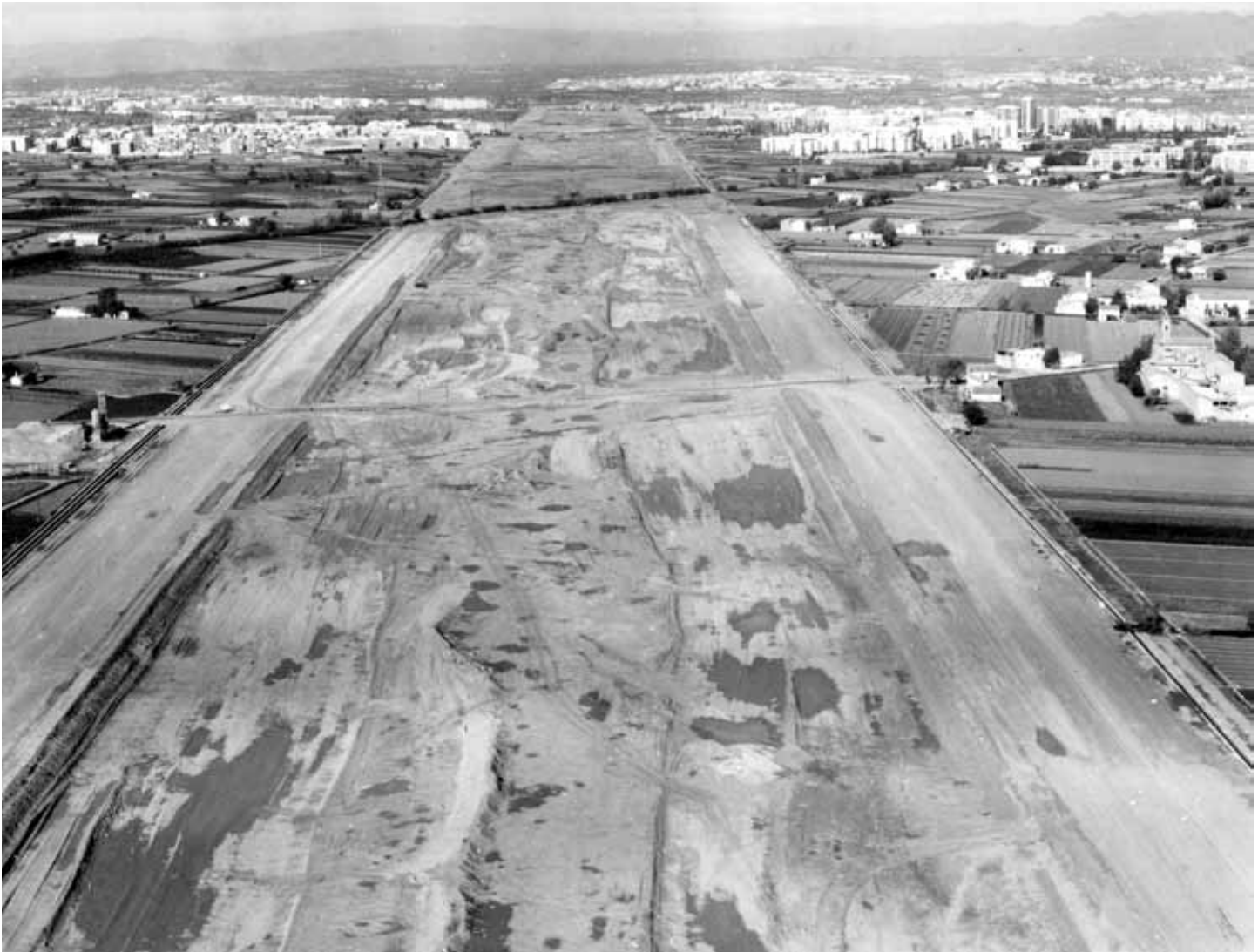
Explanación. Obras de la Solución Sur, Valencia. 1966-67
