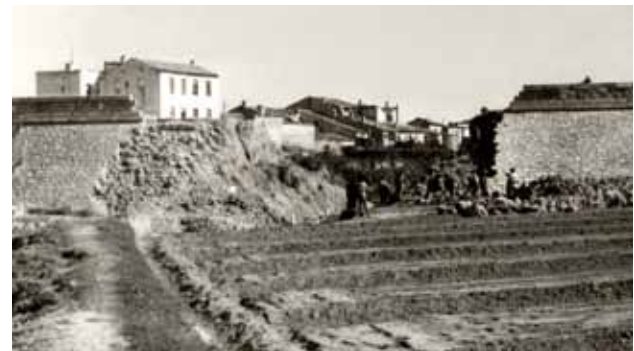
Reparación del dique y pretil de cierre del brazo muerto . Alzira, 1947
