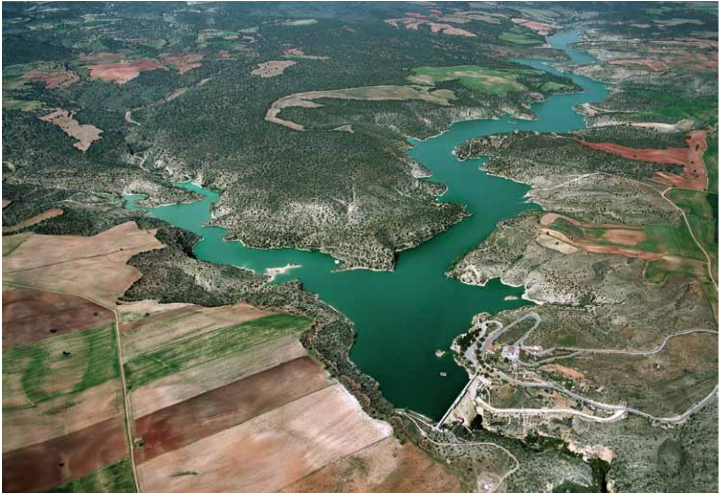
Arquillo de San Blas (Teruel). Vista aérea del embalse
