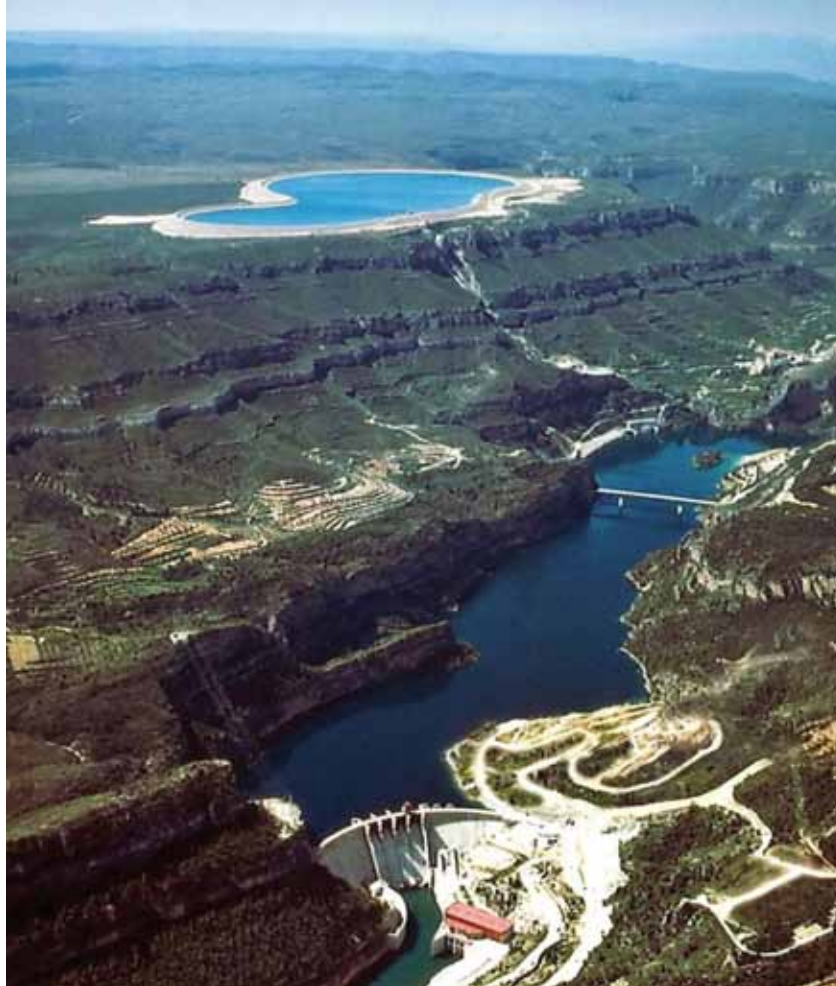
Aprovechamiento hidroeléctrico del Júcar. Complejo de Cortes-La Muela (Valencia)
