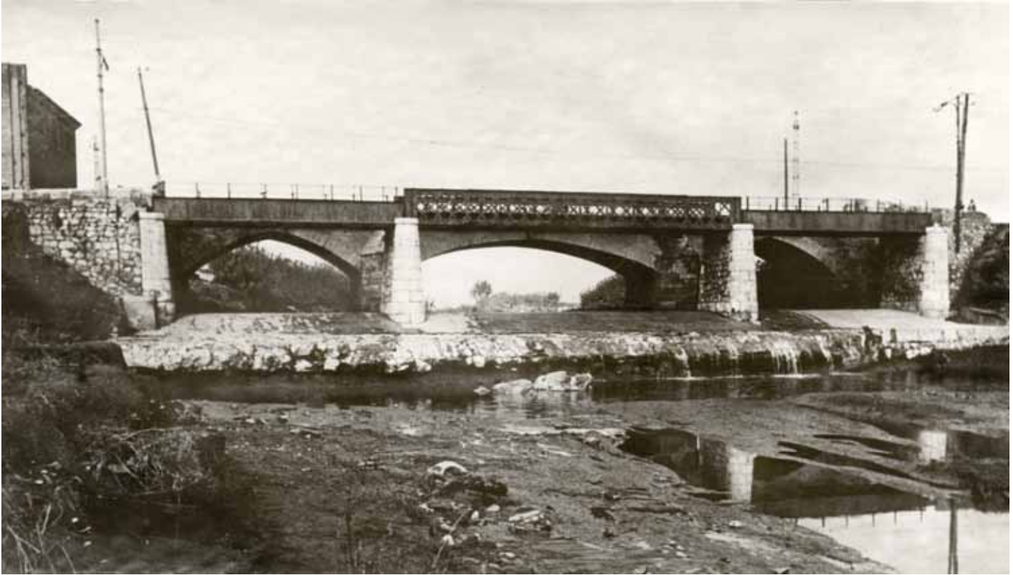
Estado del puente tras las riadas del Carraixet de septiembre de 1949 y de octubre de 1950, desde aguas abajo
