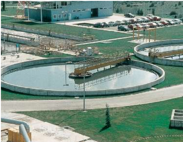
EDAR. Tratamiento primario
