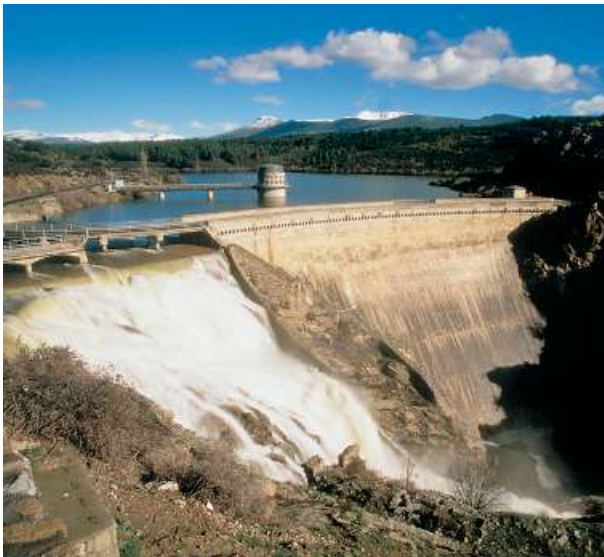
Presa del Villar. Río Lozoya (Madrid)
