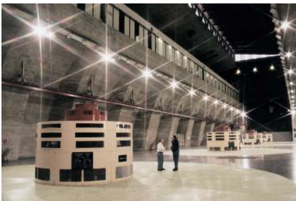
Presa Jose Mª Oriol (central)
