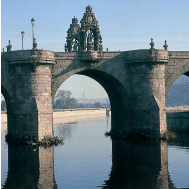
Puente de Toledo. Río Manzanares (Madrid)
