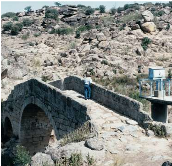
Estación de aforos de Villarejo de Montalbán. Río Cedena
