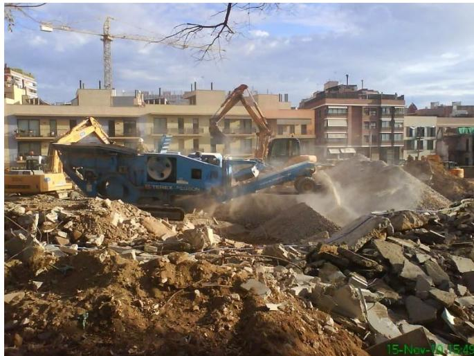
**Figura 9.21.** Restos de materiales de obra. Los materiales no están cubiertos ni irrigados, por lo que son susceptibles de resuspensión. Barcelona 2010.
