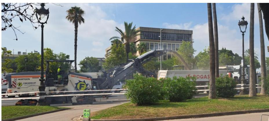
**Figura 9.23.** Ejemplos de emisiones de polvo durante el rayado de la capa de rodadura y la carga del contenedor del camión.
