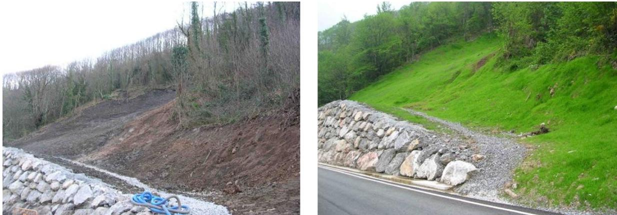
**Figura 9.22.** Efecto estabilizador del polvo en la superficie mediante hidrosiembra en la restauración de un talud. Imágenes cedidas por [Montaña Restauración Medioambiental S.L.U.](#)
